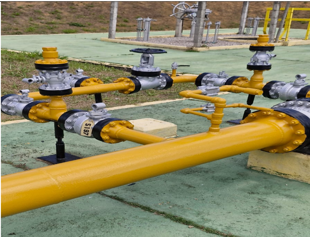
Foto 4: Válvula em destaque.
