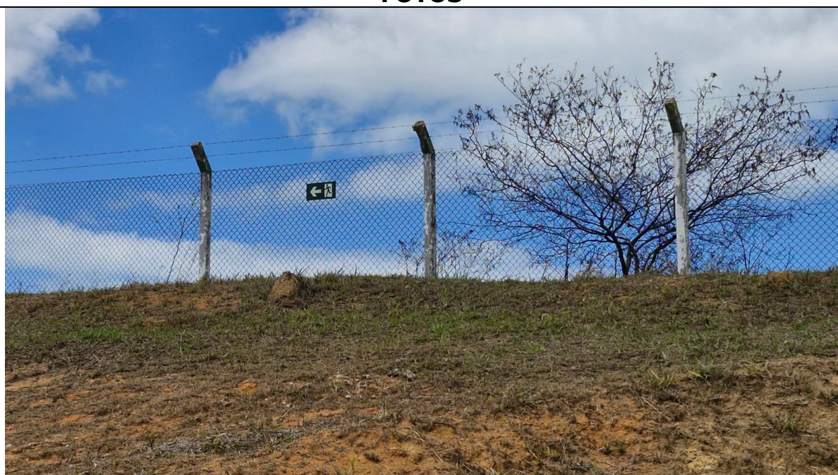
Foto 6: Cerca da área, com placa de sinalização da rota de fuga.
