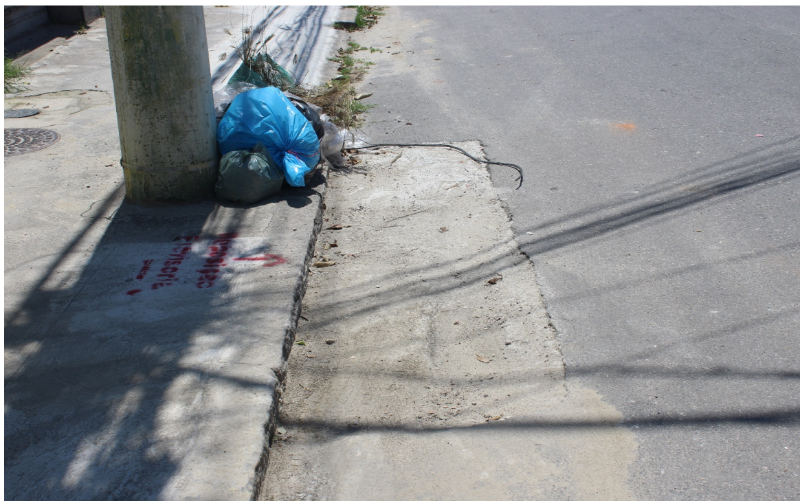
Foto 14: Recomposição provisória da via
