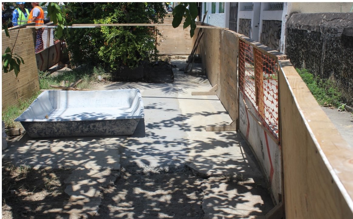
Foto 10: Execução de recomposição do passeio (lado par)
