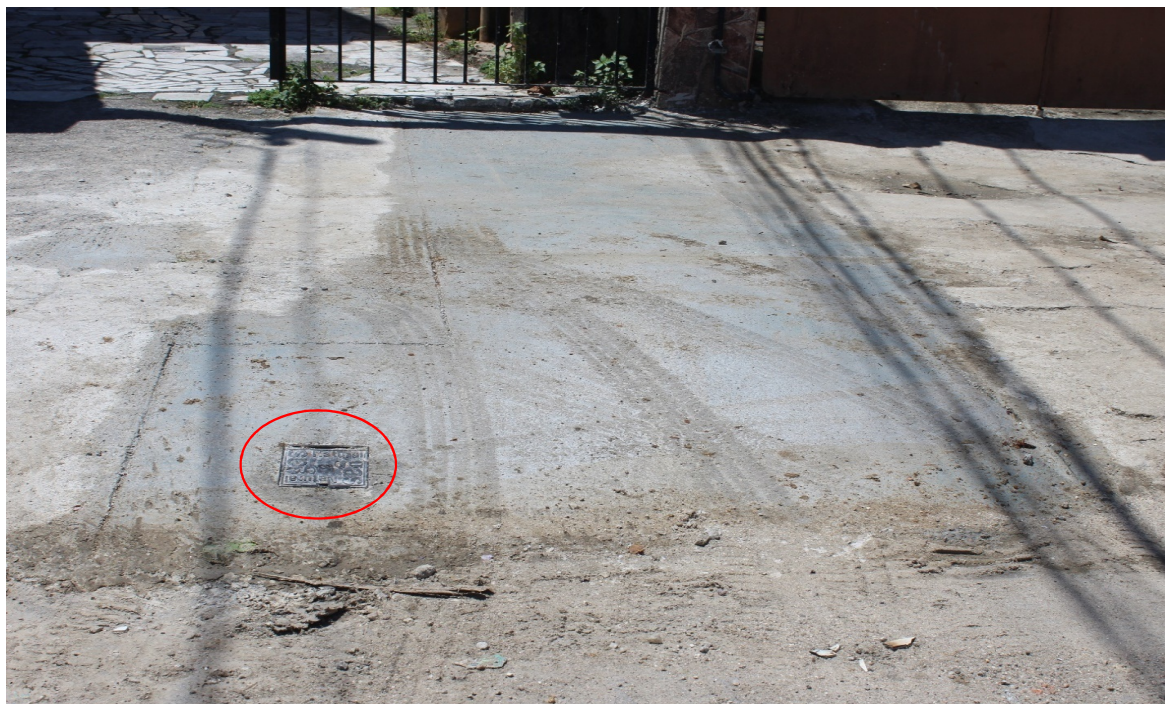
Foto 6: Recomposição do passeio (válvula de ramal) - lado ímpar
