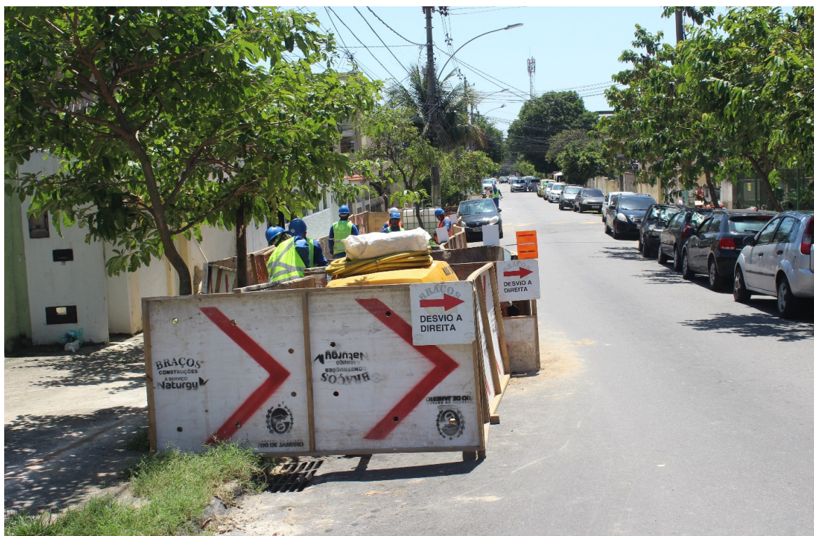
Foto 9: Isolamento e sinalização
