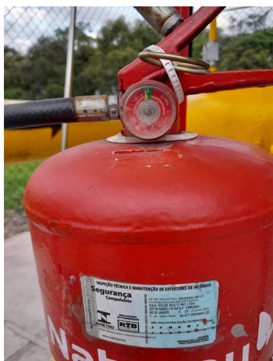
Foto 4: Extintor fora da pressão de carga (antes e depois)
