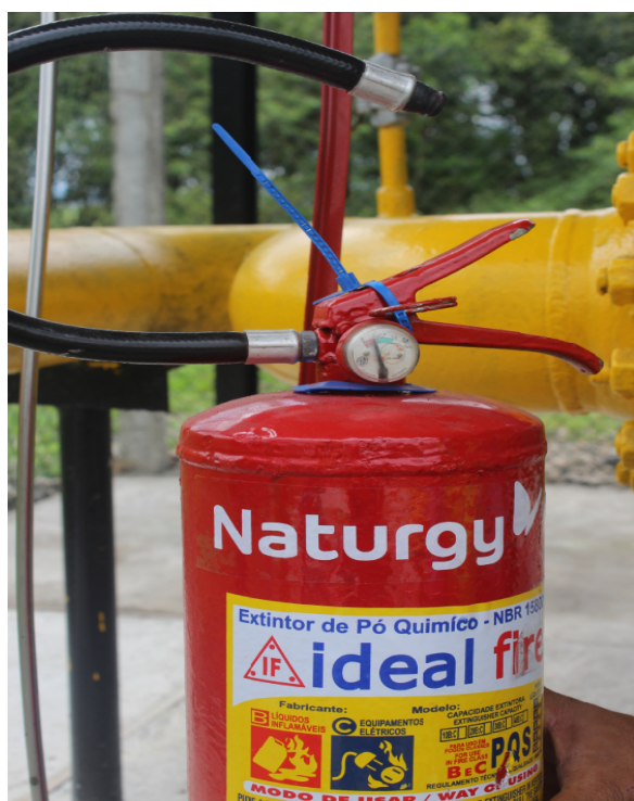
Foto 4: Extintor fora da pressão de carga (antes e depois)
