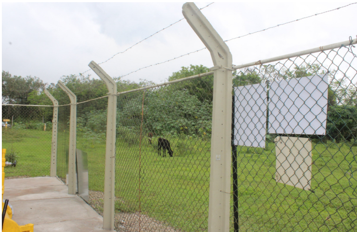
Foto 9: Cerca em bom estado
