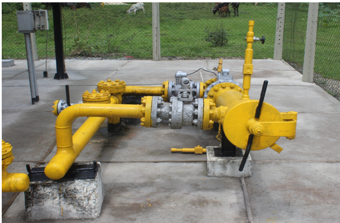
Foto 5: Lançador de pig
