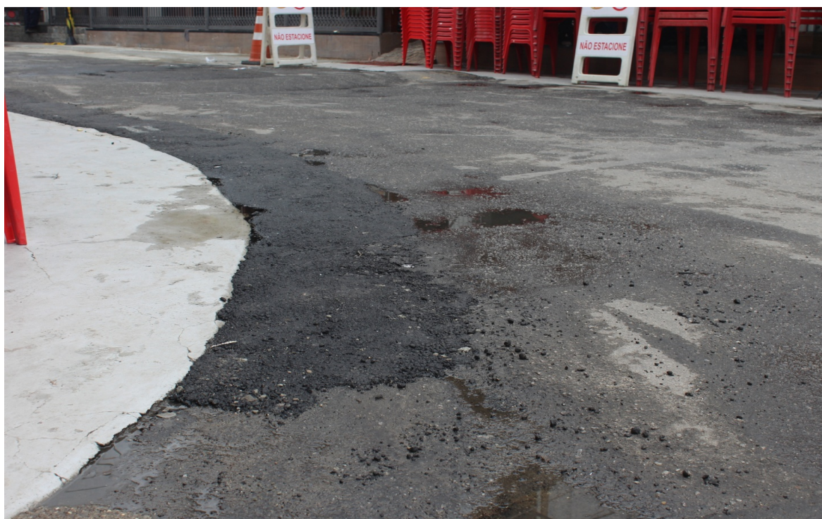
Foto 4: Trecho inicial realizado por método destrutivo
