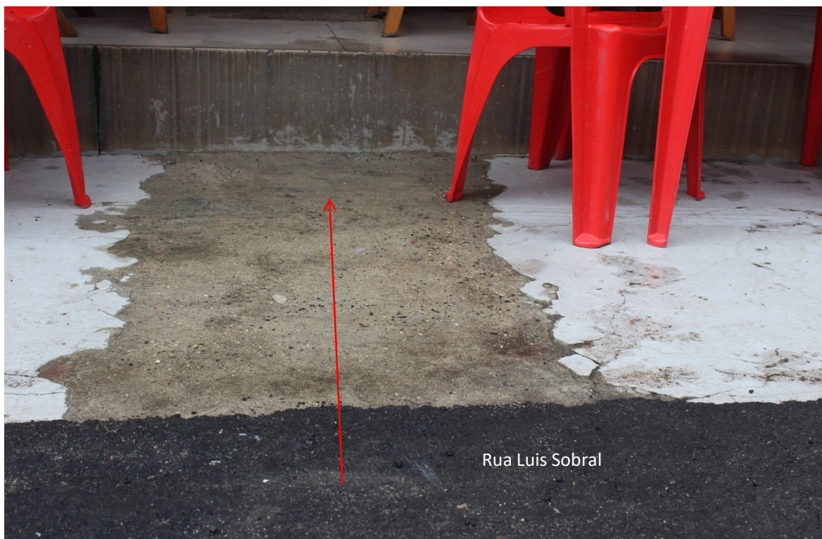
Foto 1: Ponto de início da obra (construção de ramal do cliente)
