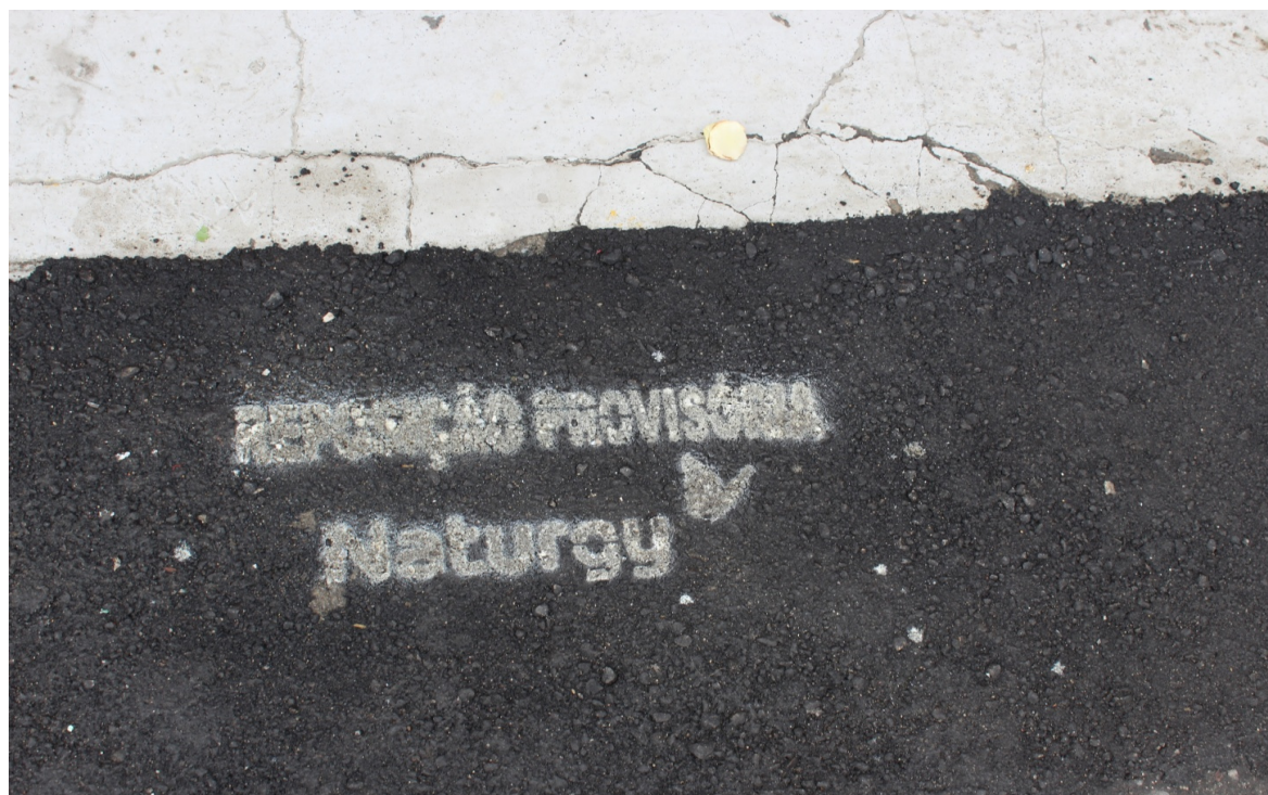
Foto 2: Recomposição provisória da via
