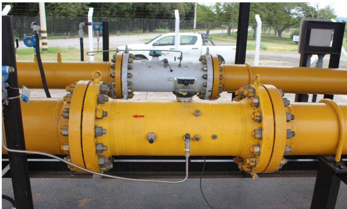
Foto 9: Medidores de Turbinas.
