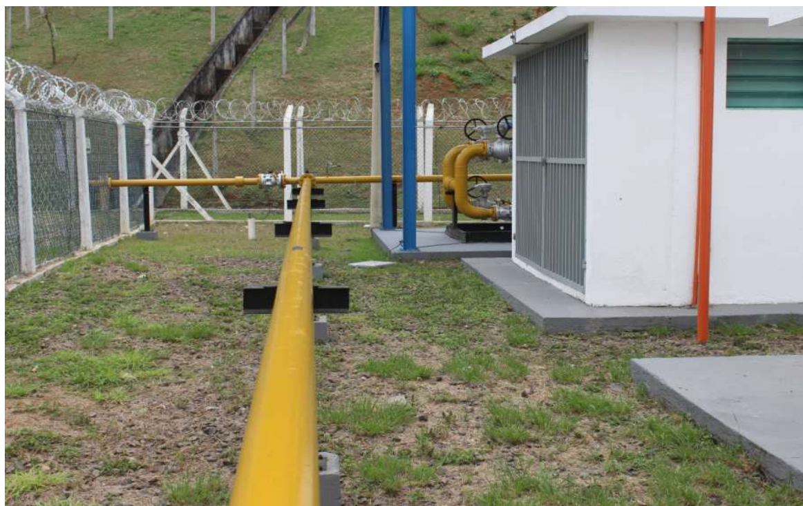
Foto 8: Tubulação de entrada - 2º corte
