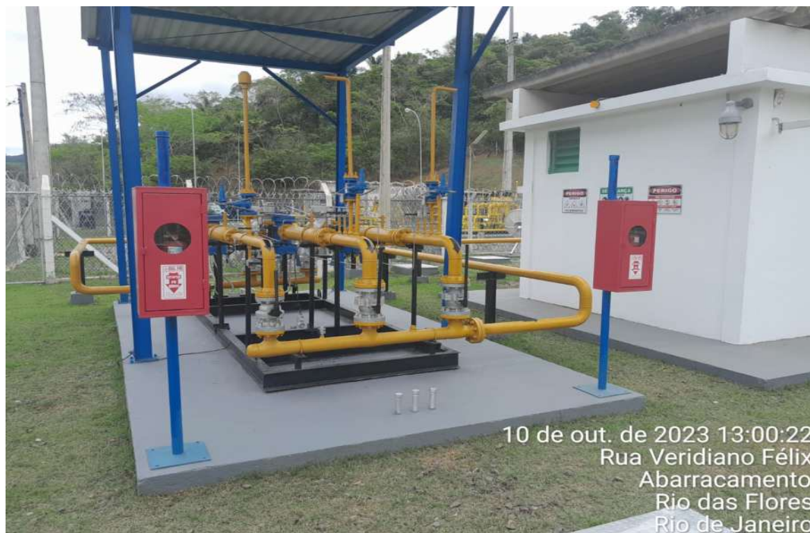
Foto 24: Adequação da altura do abrigo de extintor de incêndio
