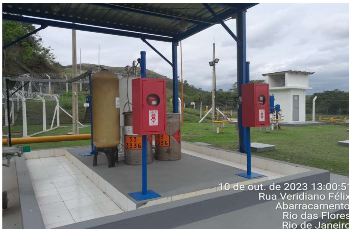
Foto 22: Adequação da altura das caixas de extintor de incêndio
