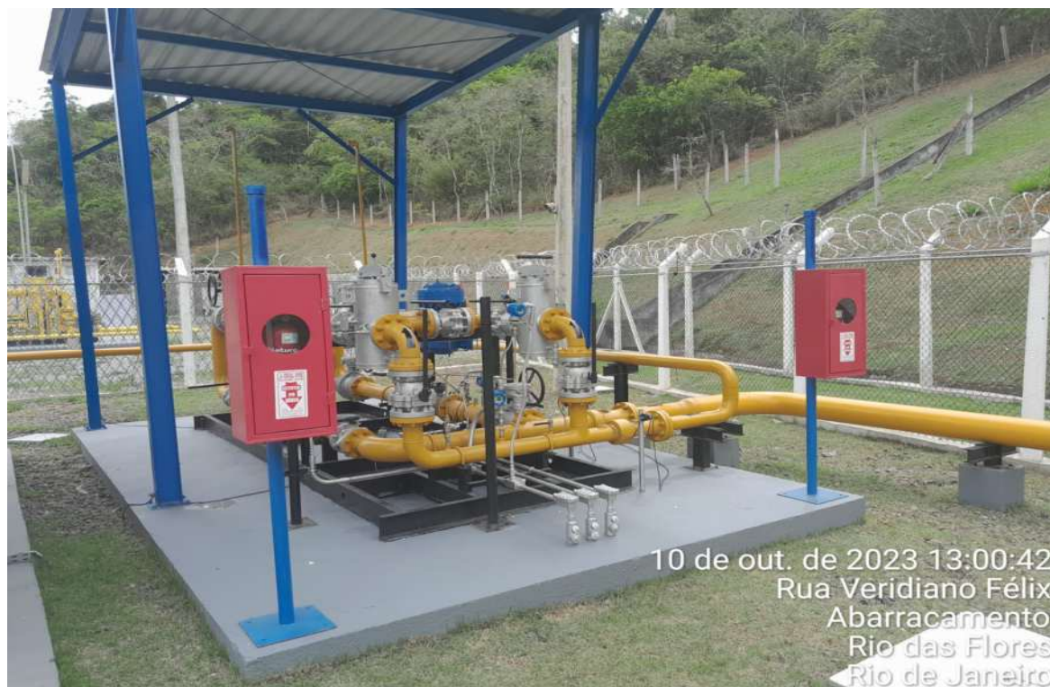
Foto 26: Adequação da altura do abrigo de extintor de incêndio
