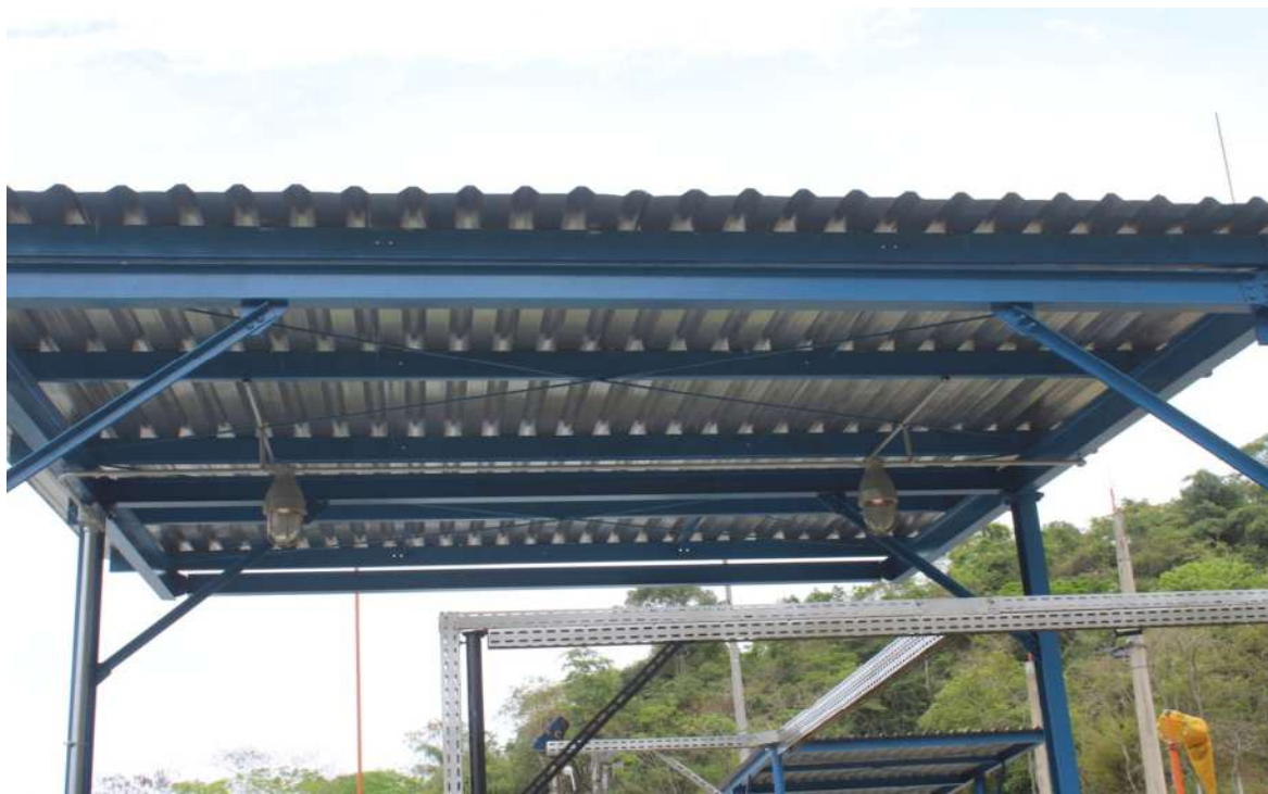
Foto 17: Cobertura da estação de odorização
