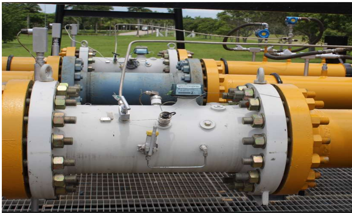
Foto 5: Medidores de Turbinas.
