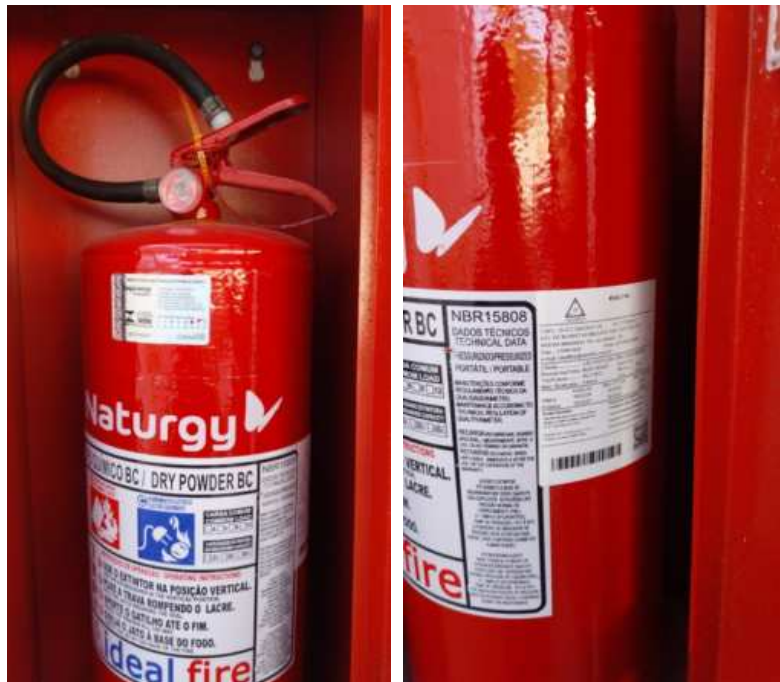
Foto 18: Adequação de extintor de incêndio.
