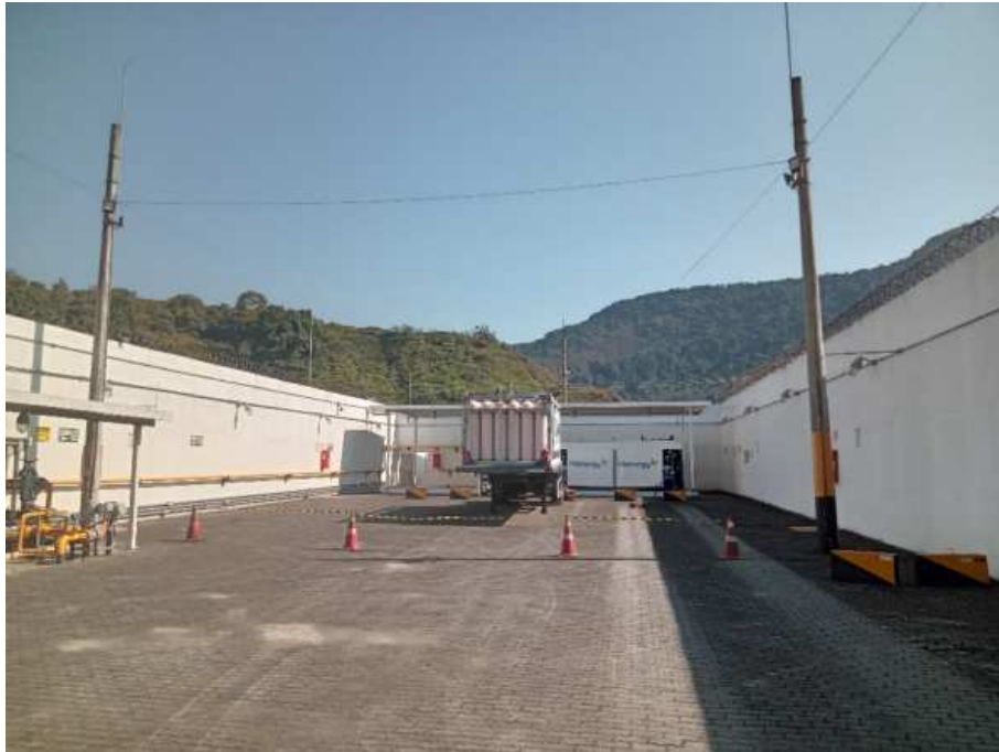
Foto 3: Vista geral da estação de descompressão.
