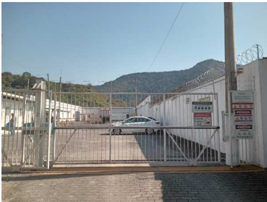
Foto 1: Placas de sinalização na entrada da estação.
