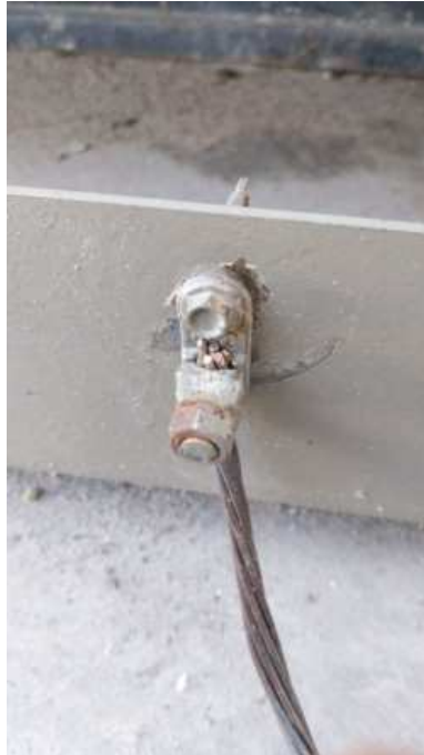
Foto 17: Adequação de cabo de aterramento.
