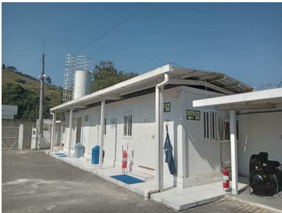
Foto 11: Salas de controle e operação, copa e banheiro.
