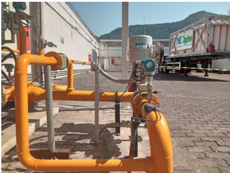
Foto 10: Medidor rotativo em by-pass e válvula telecomandada.
