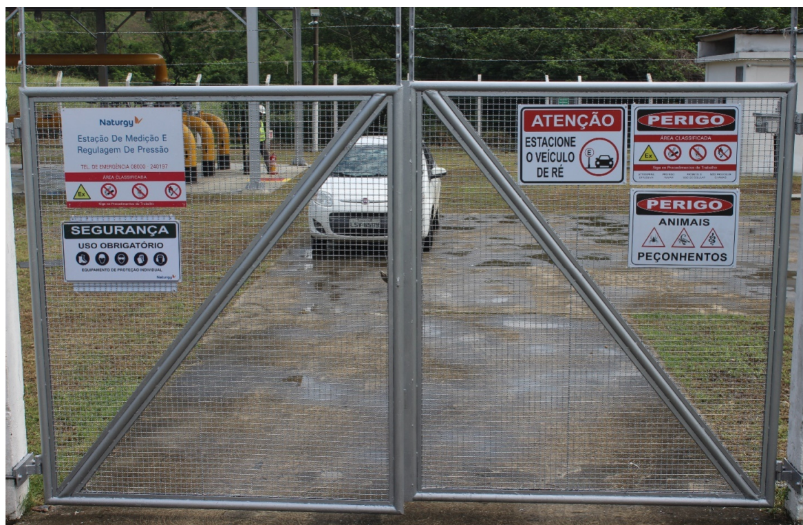
Foto 2: Sinalização (entrada da estação)
