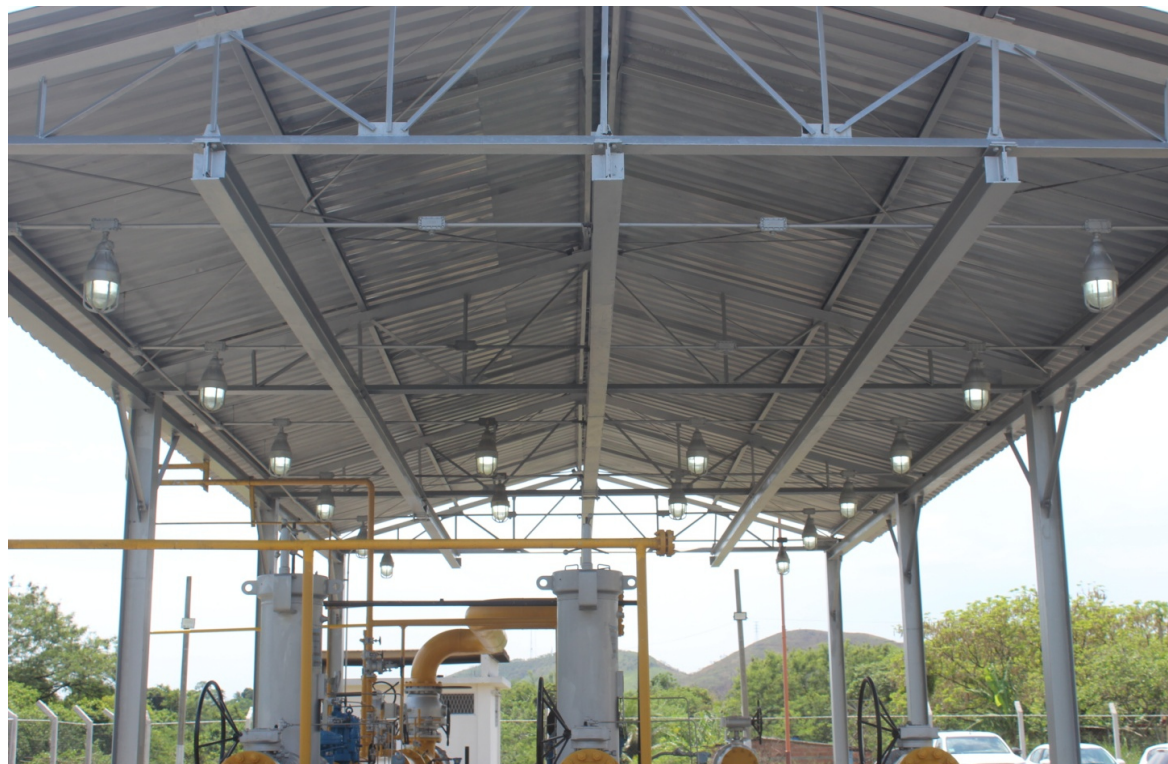
Foto 14: Cobertura da estação
