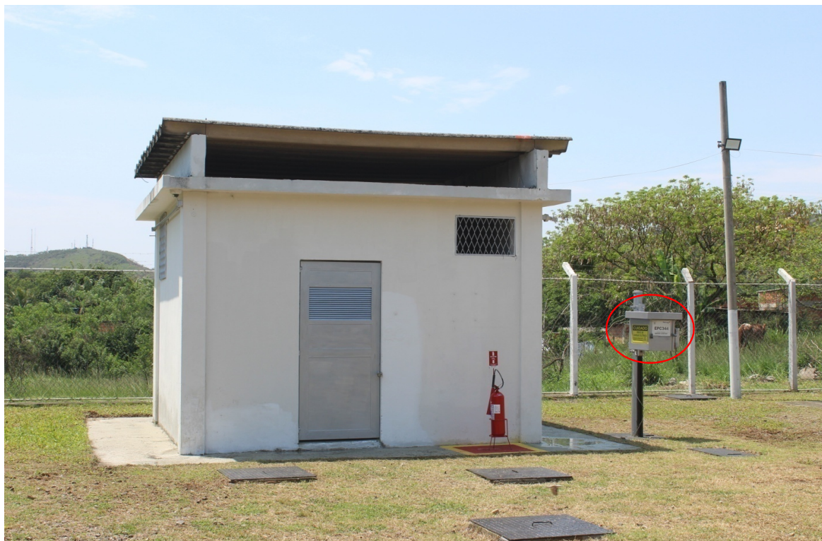
Foto 20: Sala de Controle e sistema de proteção catódica
