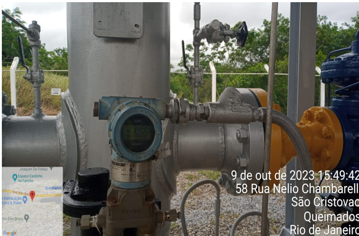
Foto 12: Manômetro diferencial de pressão em funcionamento
