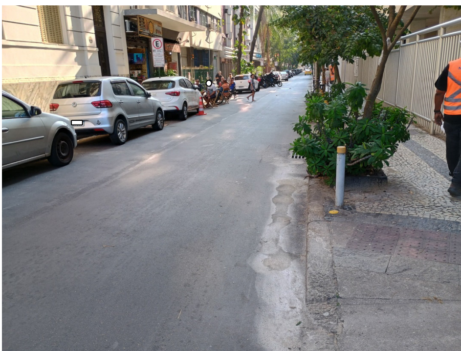
Foto 2: novo asfalto na rua Correia Dutra.
