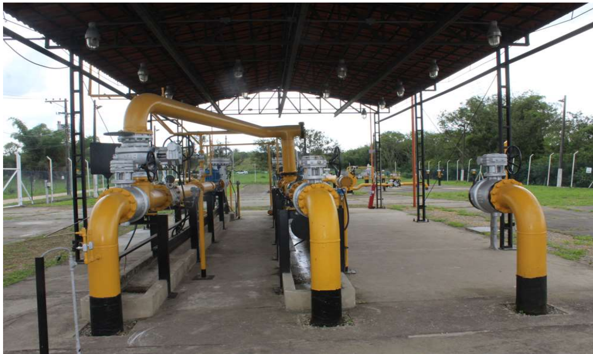
Foto 11: Estação de Regulagem e Medição.
