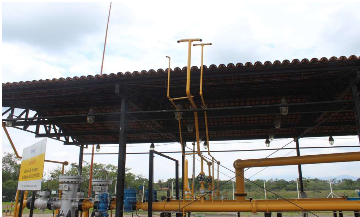
Foto 3: Cobertura da estação.
