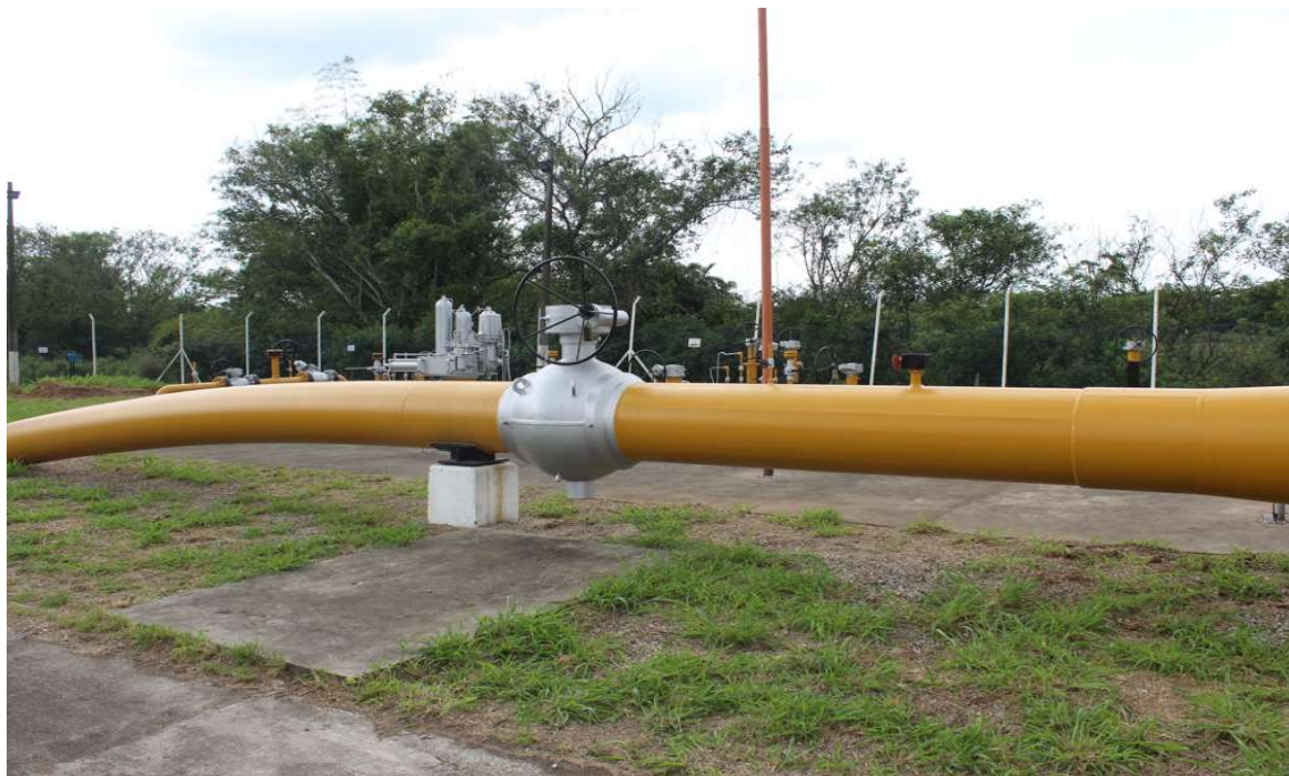
Foto 9: Duto de lançamento para Manutenção.
