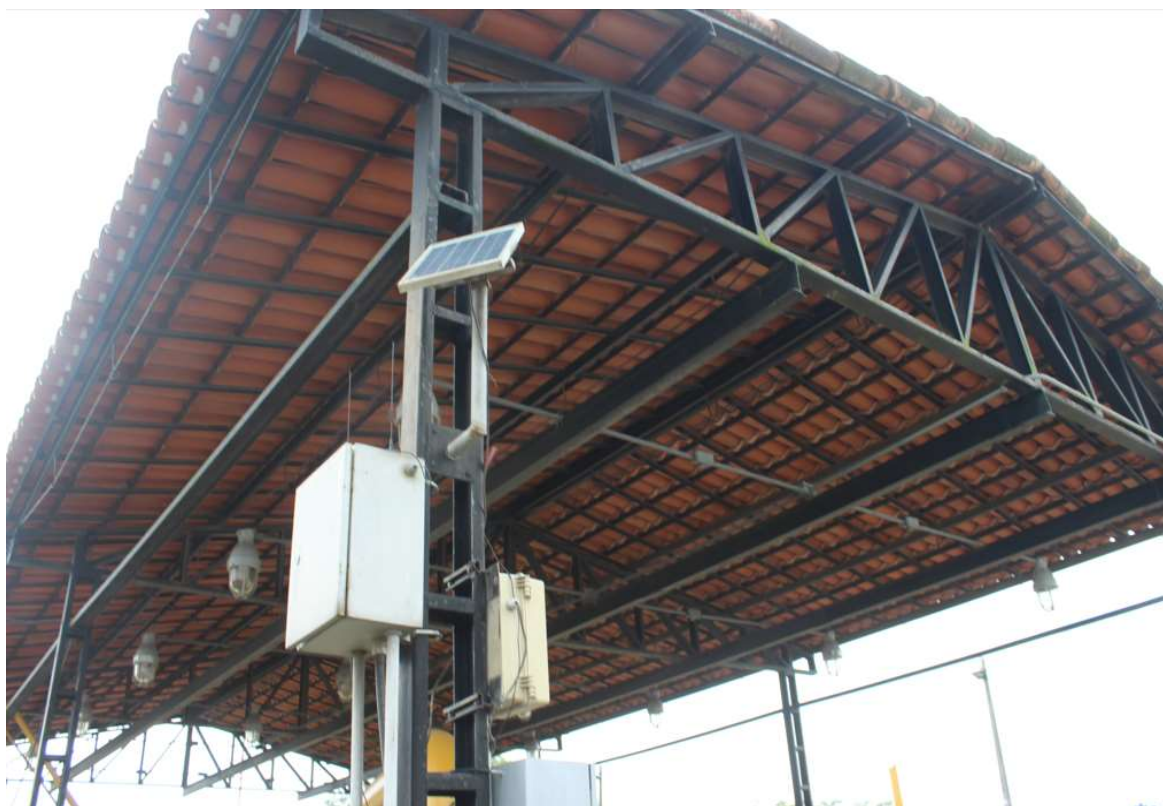
Foto 4: Cobertura da estação e o painel solar .
