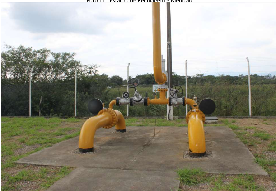
Foto 11: Estação de Regulagem e Medição.
