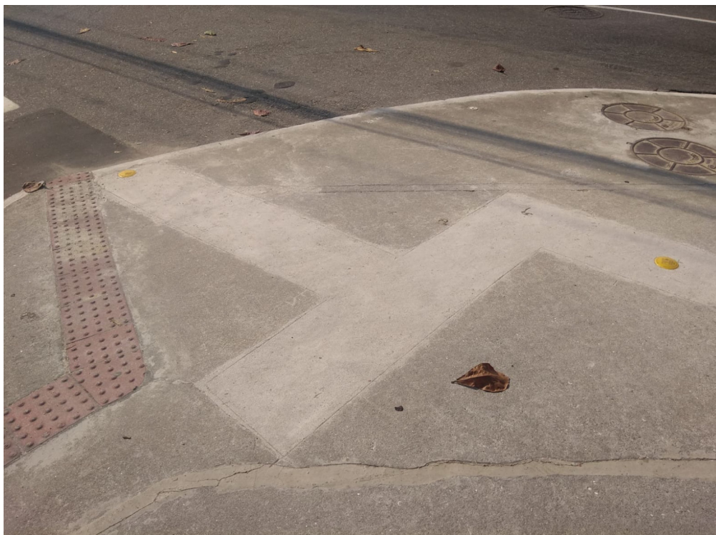
Foto 5: Recomposição definitiva entre as extensões executadas pelo método direcional.
