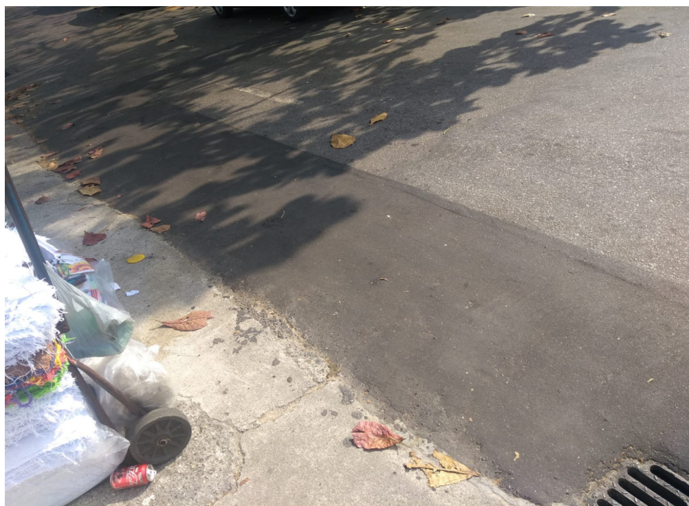
Foto 6: Recomposição definitiva entre as extensões executadas pelo método direcional.
