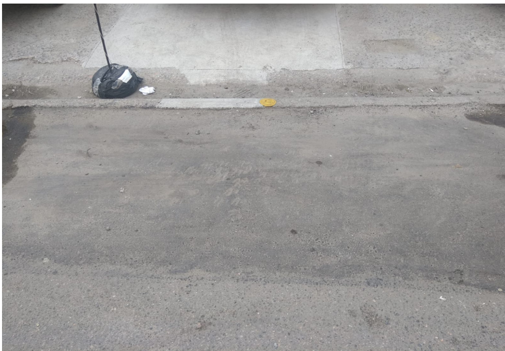
Foto 7: Recomposição definitiva do buraco feito para a travessia da via.
