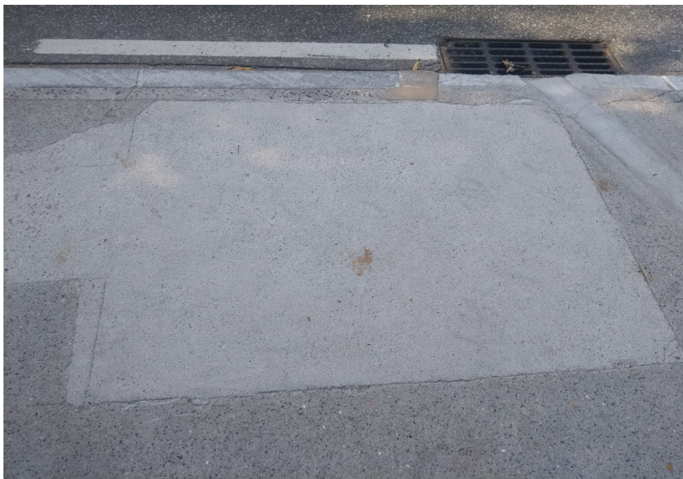
Foto 4: Recomposição definitiva entre as extensões executadas pelo método direcional.
