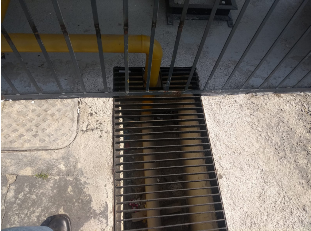
Foto 1: Canaleta para passagem de duto de Aço de 3" e conexão com o cliente.
