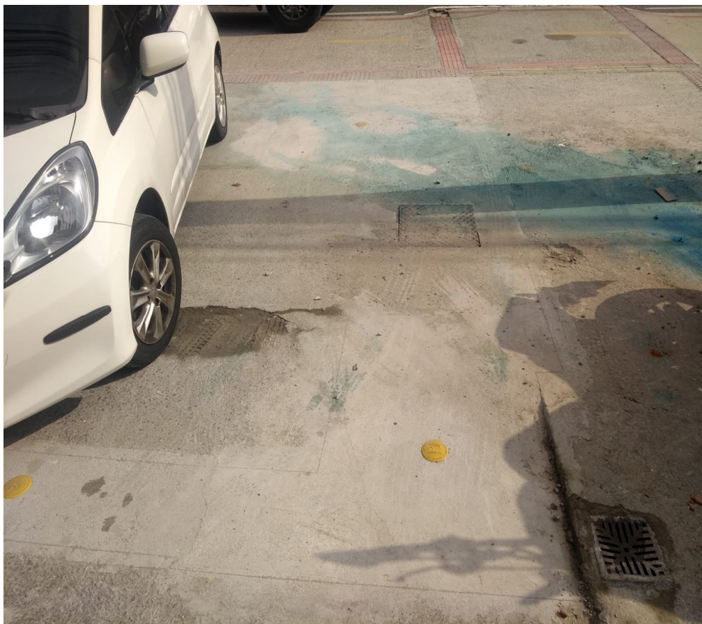
Foto 9: Recomposição definitiva na ligação com a rede de distribuição.
