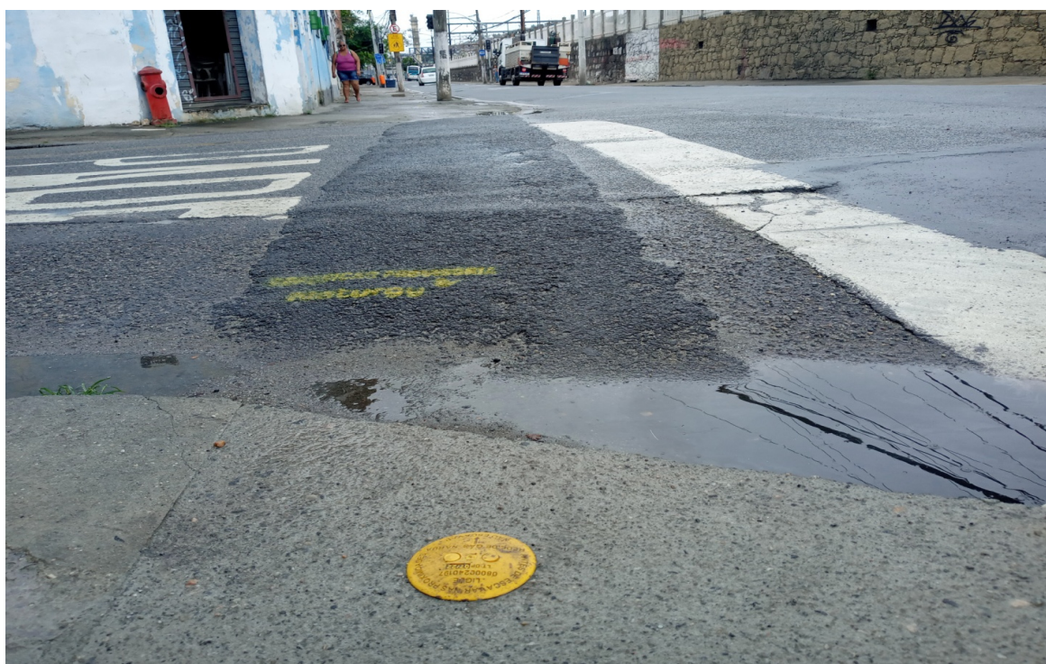
Foto 4: Recomposição provisória
