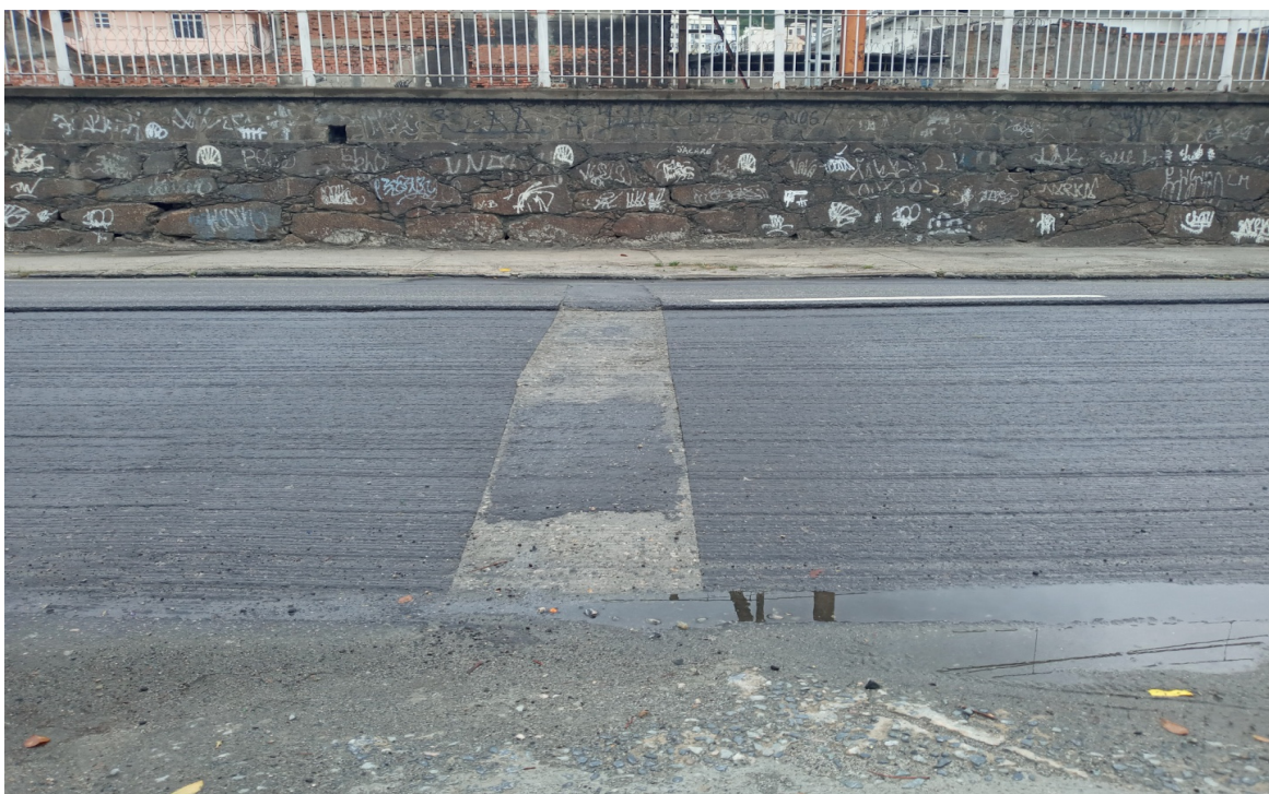
Foto 6: Trecho de obra com asfalto fresado
