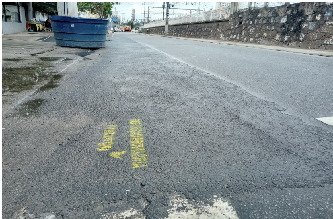
Foto 5: Trecho a ser fresado
