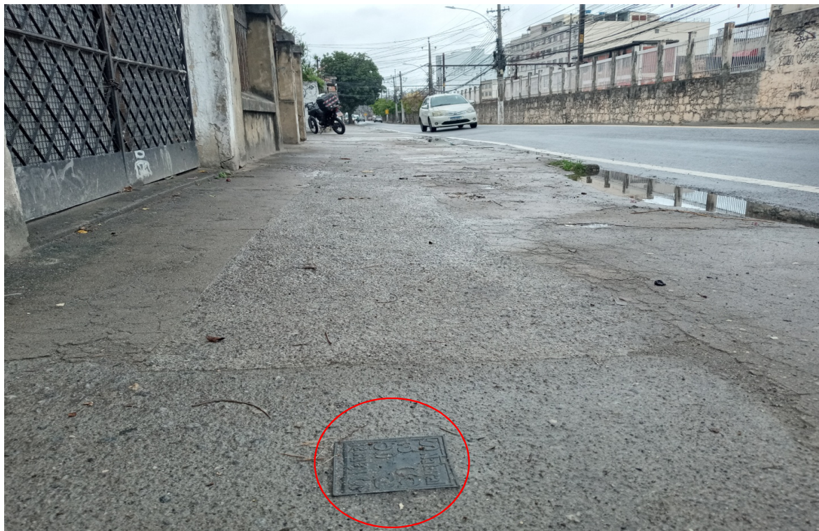
Foto 3: Recomposição e válvula de ramal
