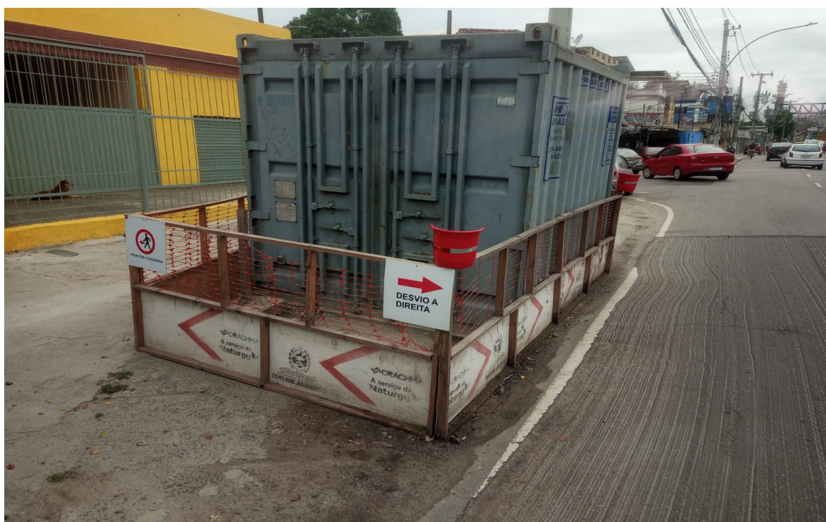
Foto 8: Isolamento com sinalização noturna
