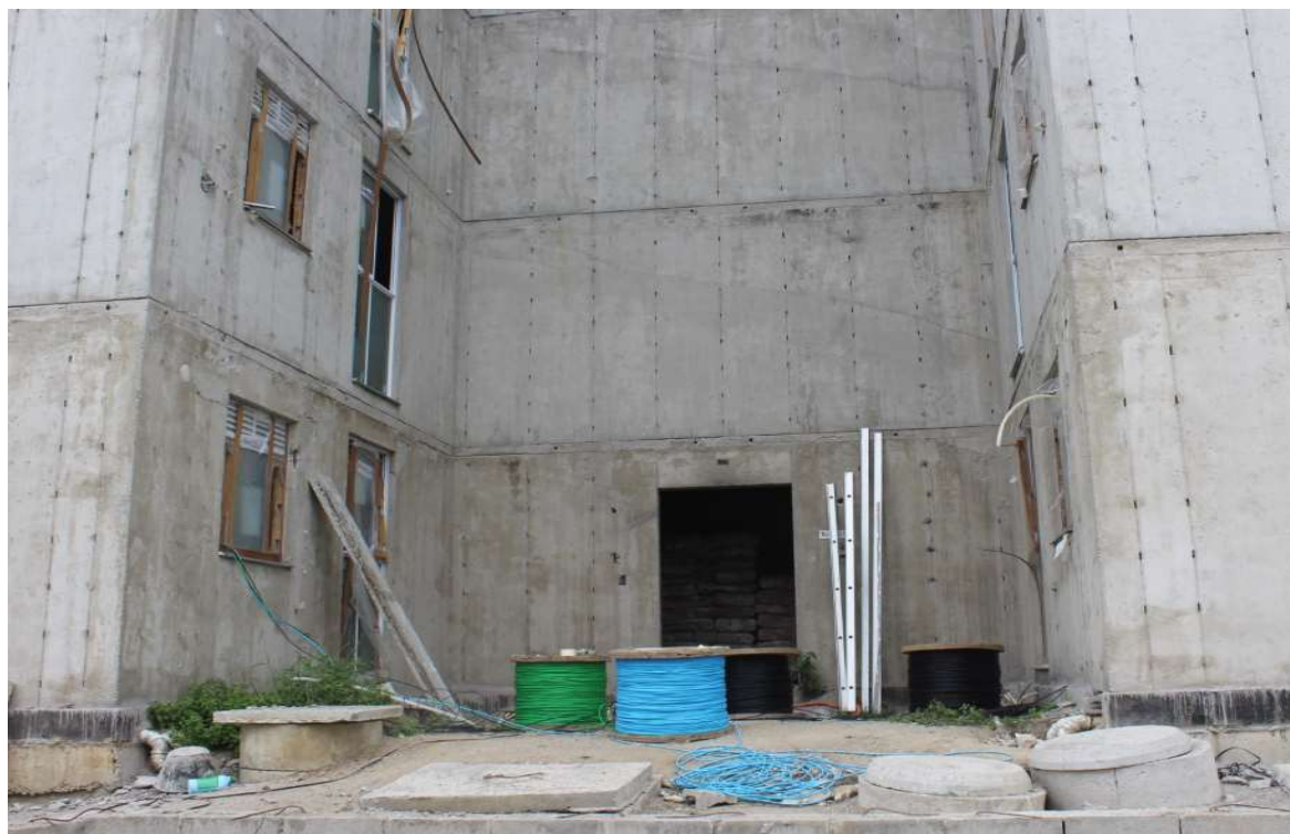
Foto 6: Futura instalação de PI
