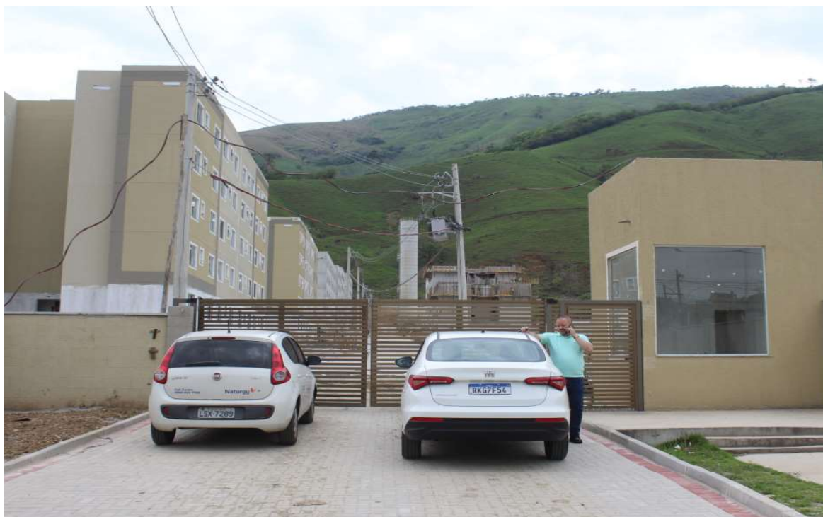
Foto 1: Fachada do condomínio
