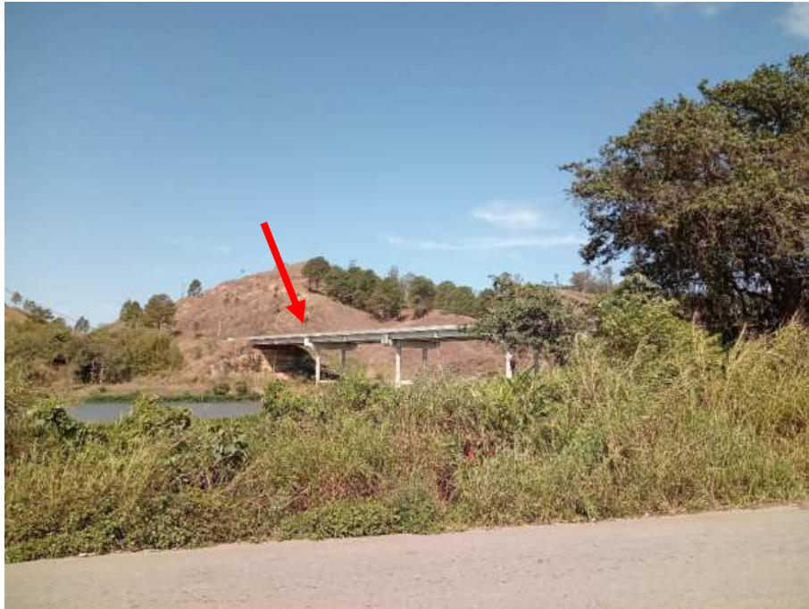
Foto 9: Vista do elevado onde será realizada a travessia de rede aérea com tubo de aço de 4".
