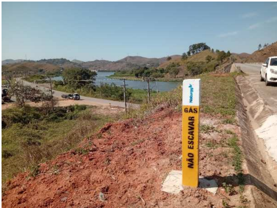
Foto 8:Marco vertical de concreto a jusante do elevado.
