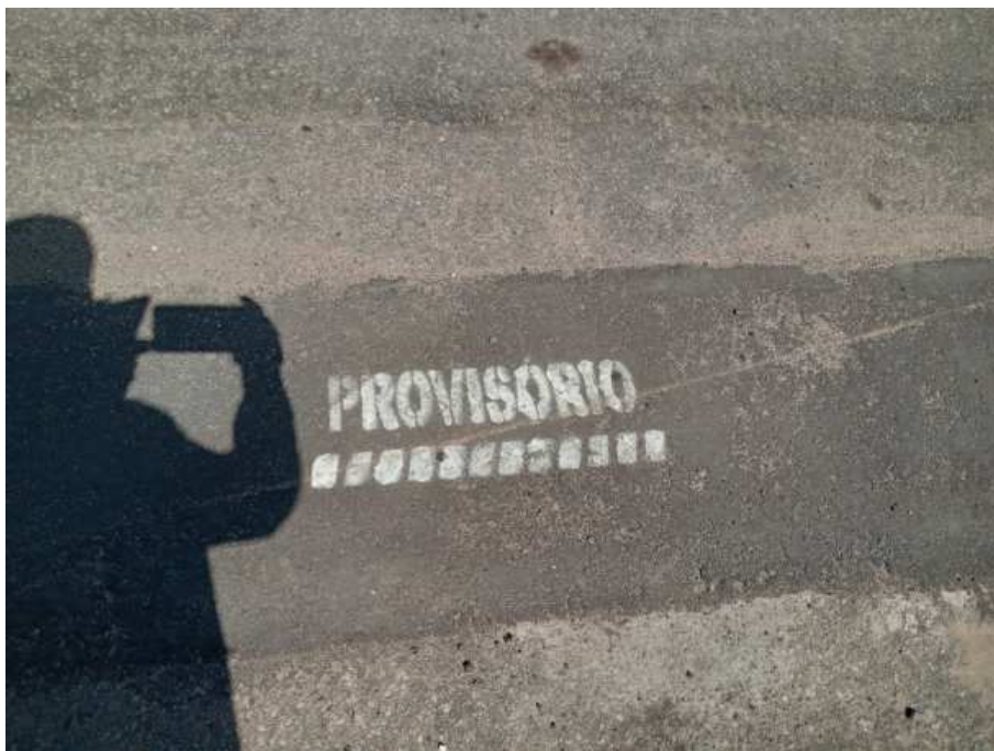
Foto 5: Identificação de recomposição provisória.
