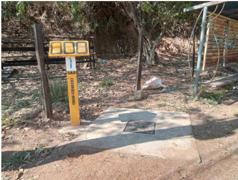
Foto 1: Ponto de interligação da rede construída com a rede PE Ø200 mm e rede existente Ø160 mm.
