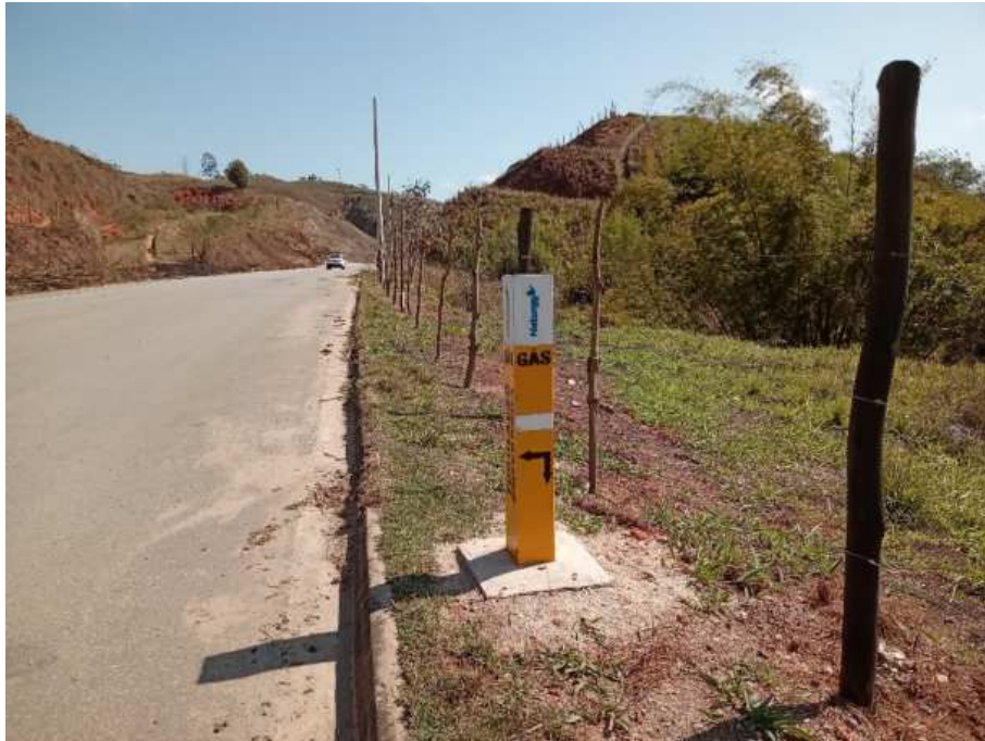
Foto 3: Marco vertical de concreto indicando a presença de rede de gás enterrada.
