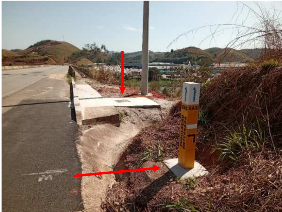
Foto 7: Caixa de válvula e marco vertical de concreto a montante do elevado, onde haverá travessia aérea..
