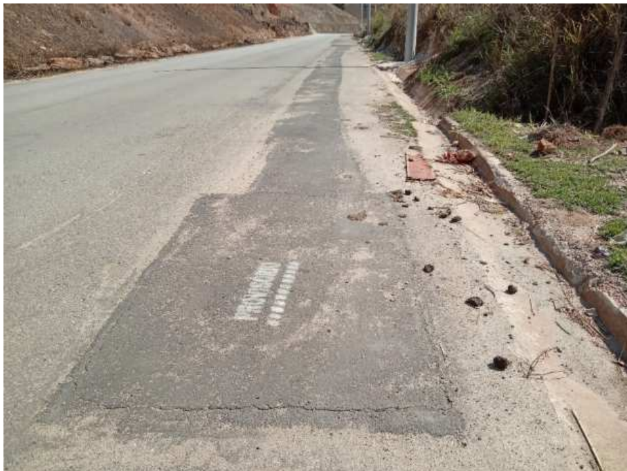
Foto 4: Recomposição provisória de trecho realizado por método destrutivo.
