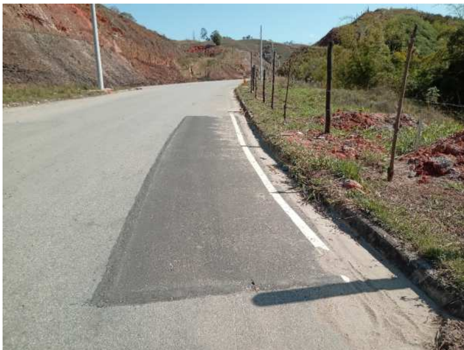
Foto 2: Recomposição permanente da via.
