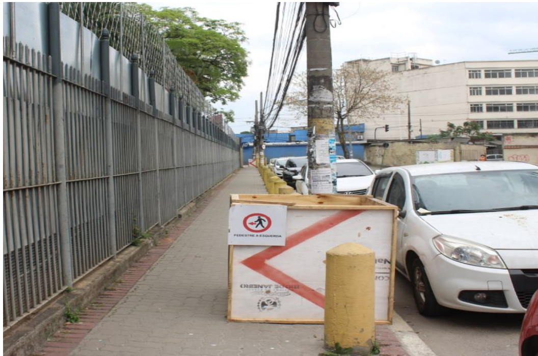
Foto 10: Isolamento de calçada por tapume e sinalização de pedestre
