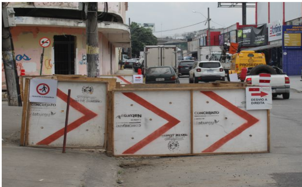
Foto 7: Isolamento de obra
