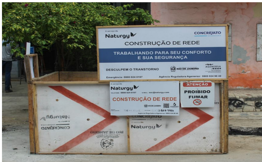
Foto 3: Identificação da obra
