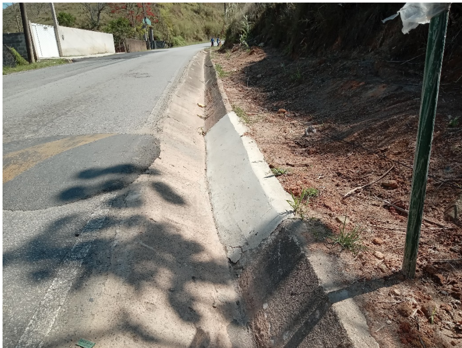
Foto 4: Recomposição da canaleta danificada durante o processo de construção da rede.
