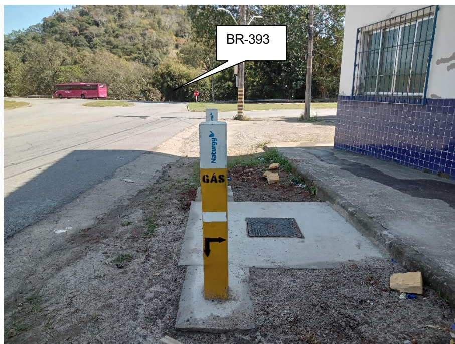
Foto 7: Caixa de válvula e marco vertical de concreto no ponto de finalização da fase 1.
