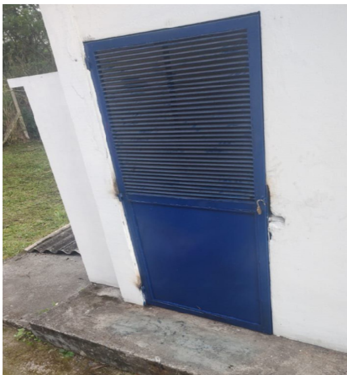
Foto 7: Porta deteriorada (depois)
