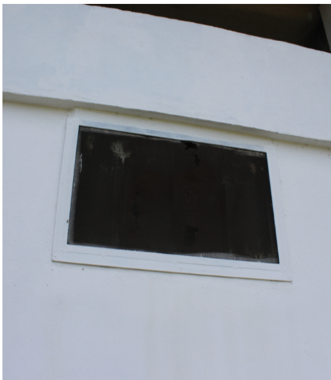
Foto 10: Tela de proteção de janela (antes)
