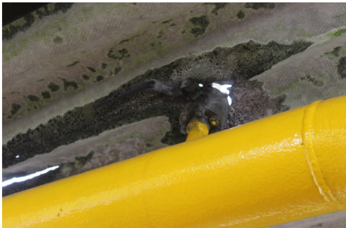
Foto 18: Telhado sem acabamento (antes)
