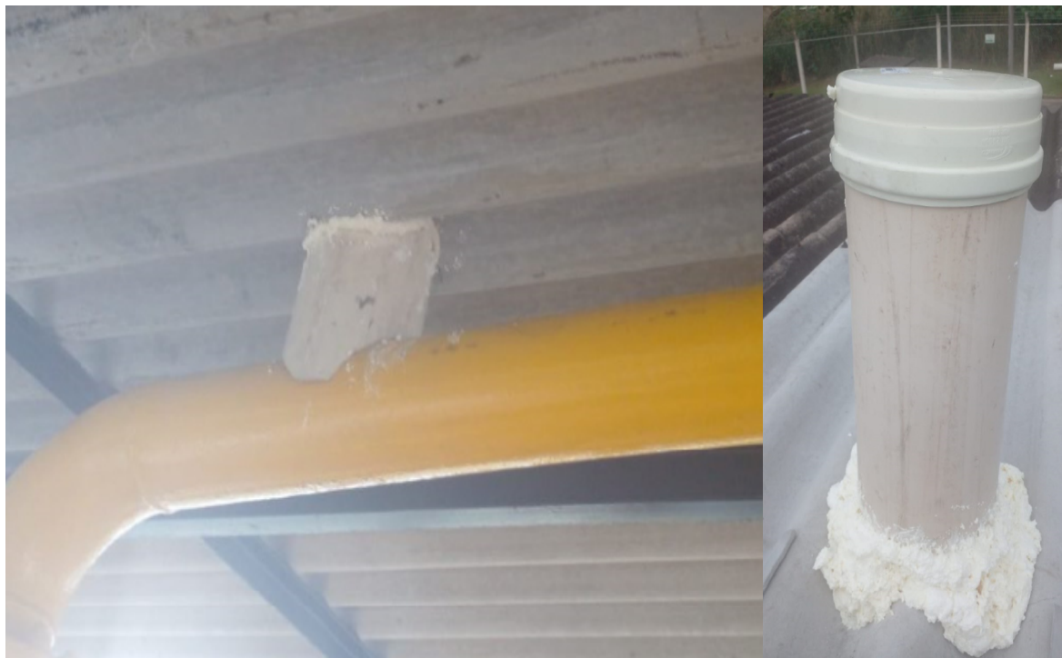
Foto 19: Telhado sem acabamento (depois)
