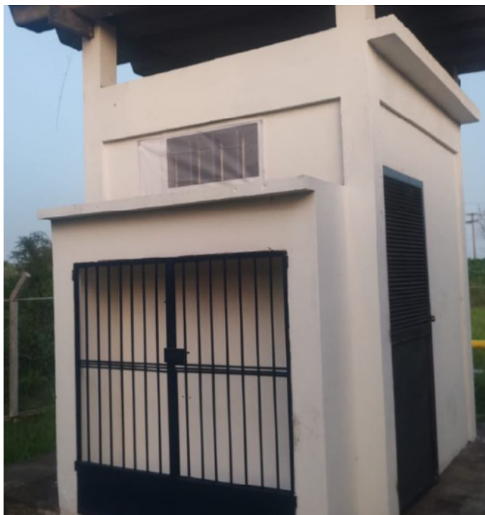
Foto 11: Tela de proteção de janela (depois)
