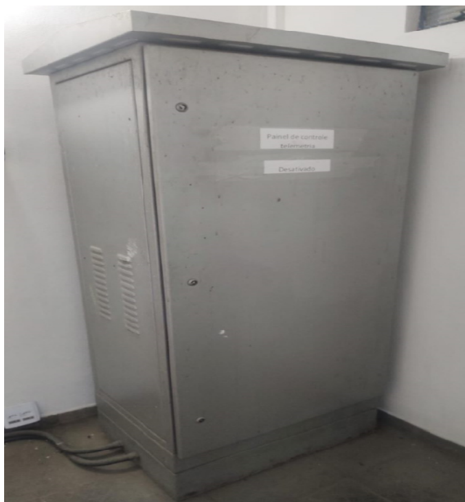
Foto 9: Painel de controle sem identificação (depois)
