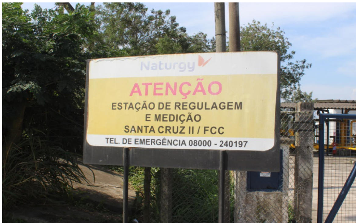
Foto 1: Placa de identificação da Estação
