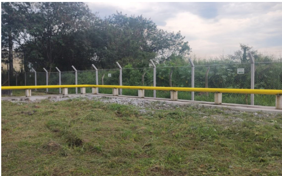
Foto 17: Placas de rota de fuga (depois)
