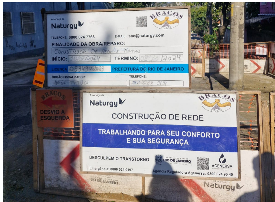
Foto 3: Identificação da obra.
