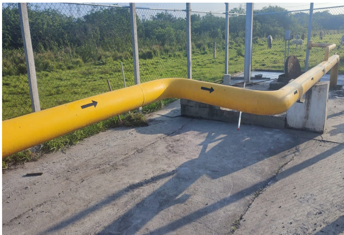
Foto 4: Tubulação de 8" que alimenta a Gerdau (depois)
