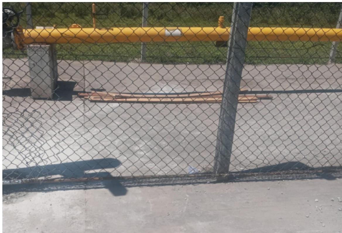
Foto 8: Distanciamento entre cerca e piso (depois)
