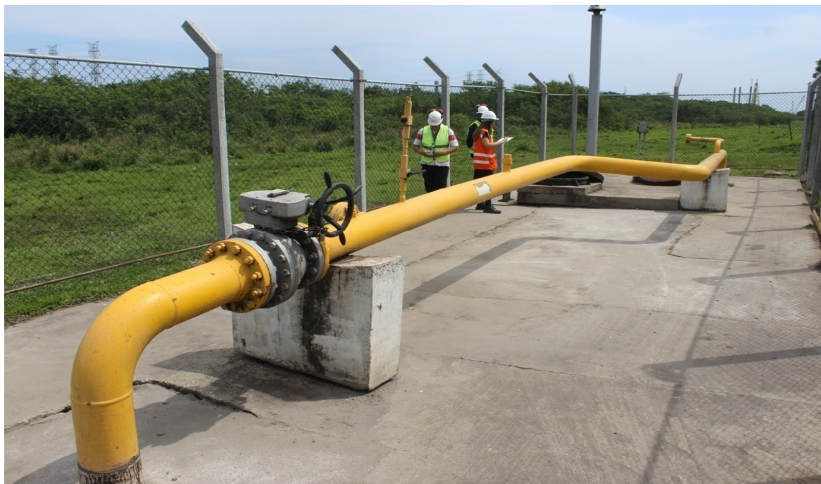
Foto 3: Tubulação de 8" que alimenta a Gerdau (antes)
