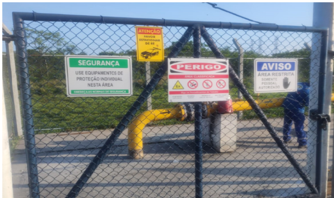
Foto 13: Entrada da estação com a devida sinalização (depois)
