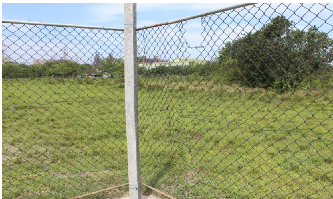
Foto 11: Cerca da estação (antes)
