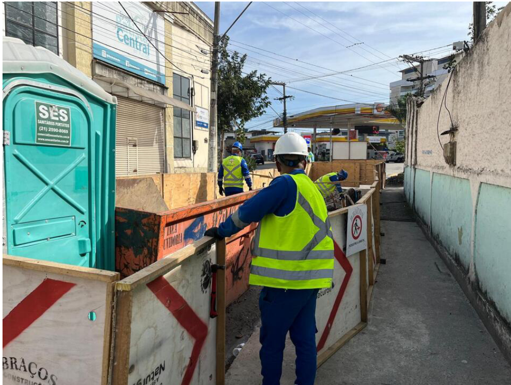
Foto 3: Obra de vedação no início do trajeto da tubulação.
