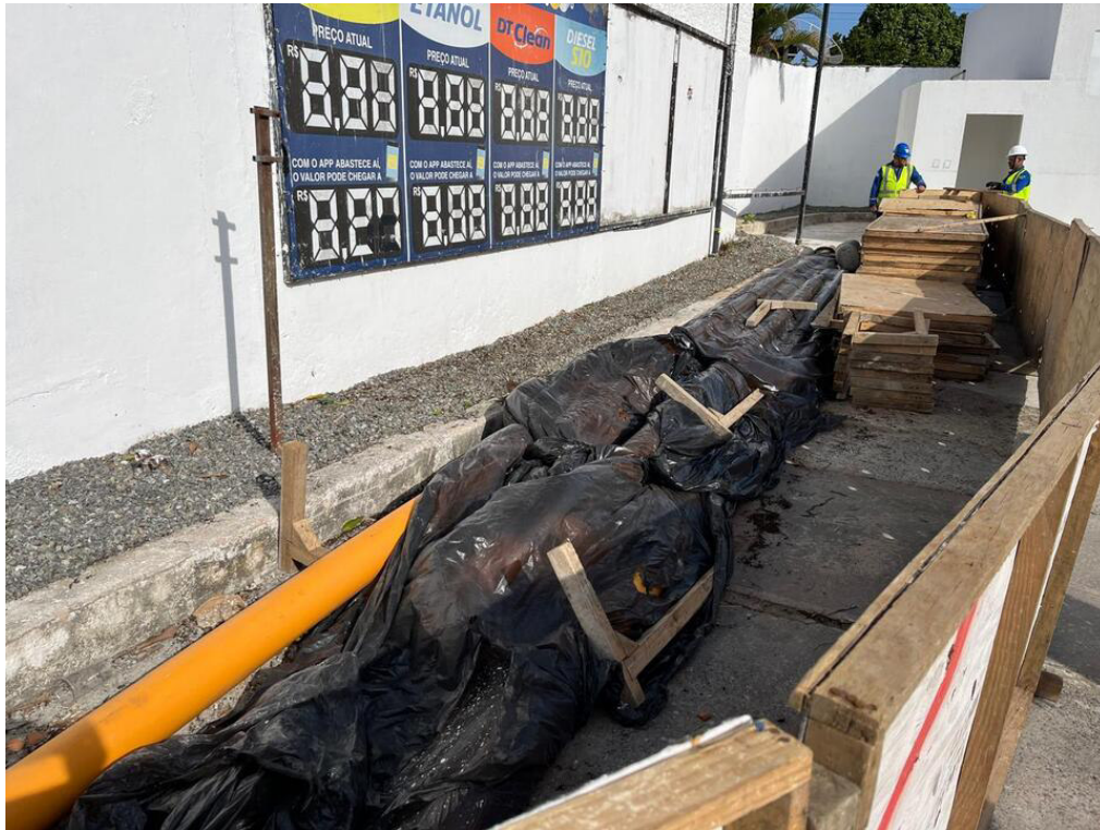
Foto 13: Área de armazenamento de material no auto posto.
