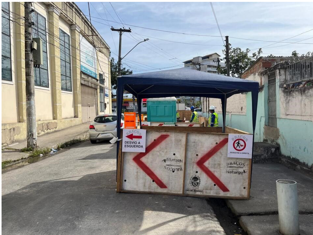
Foto 2: Área de vivência (à frente) e obra de vedação (atrás) no início do trajeto.
