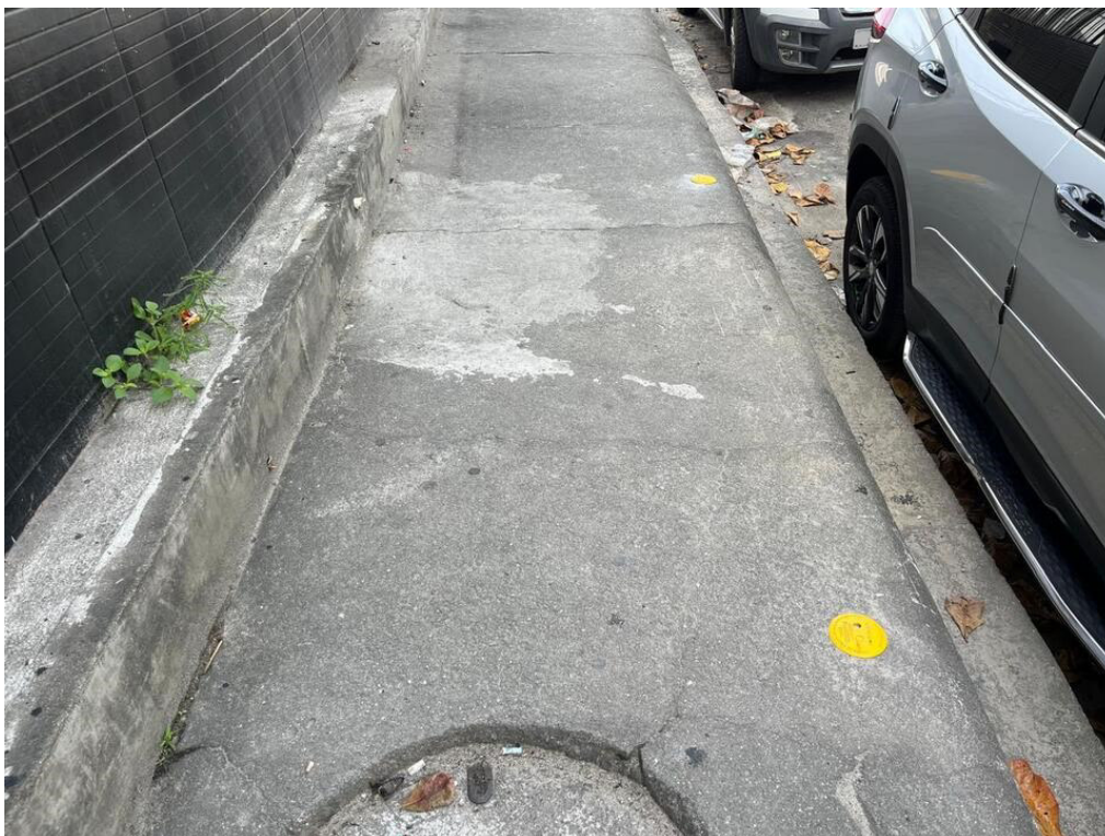
Foto 4: Passeio com marcos planos instalados na Rua Gaspar de Freitas.
