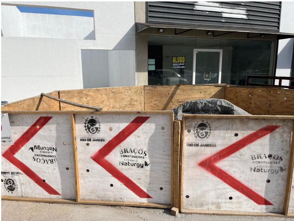
Foto 14: Área de armazenamento no auto posto.
