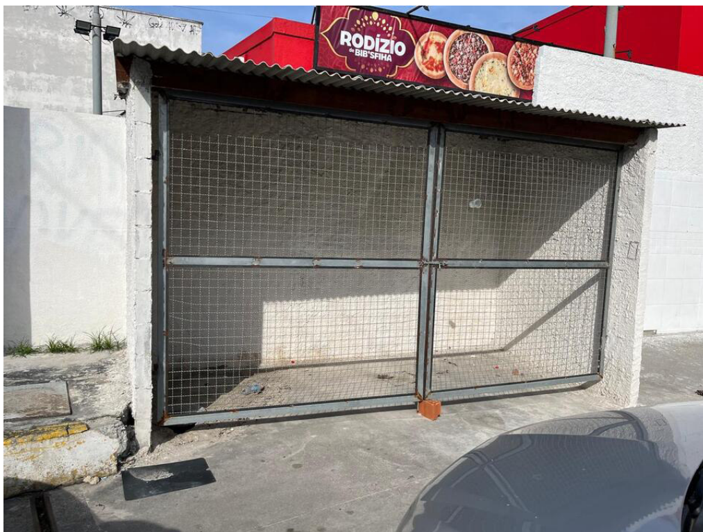
Foto 12: Parte interna do auto posto onde obra terminará com instalação do ramal.
