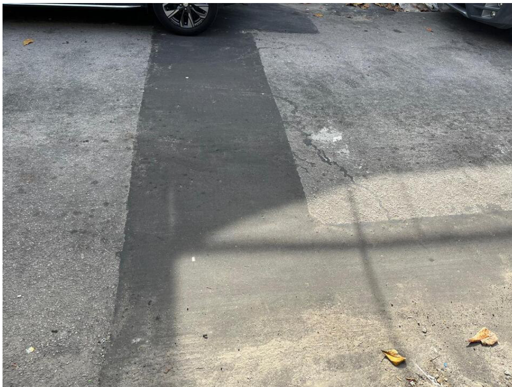
Foto 5: Travessia da via realizada por método destrutivo, já recomposta.
