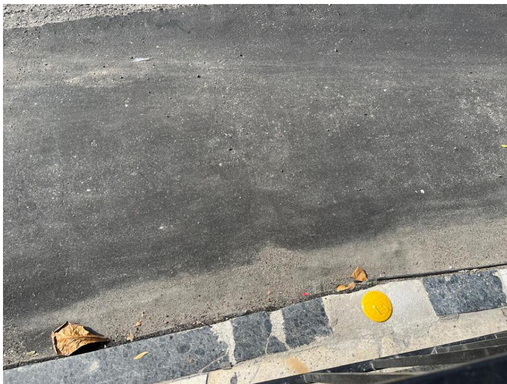
Foto 7: Trecho recomposto na esquina do Bom Buteco, com marco plano visível no meio-fio.
