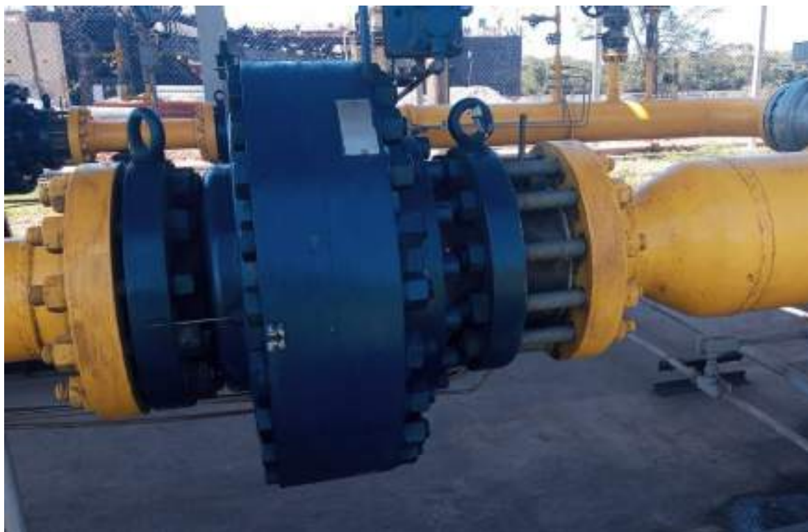
Foto 11: Parafusos oxidados (depois).
