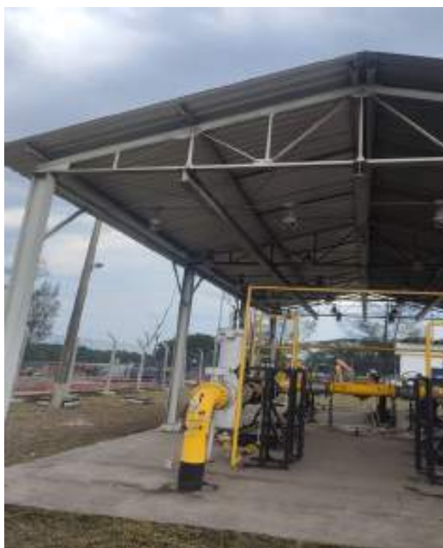
Foto 26: Telhado reparado e capina feita.
