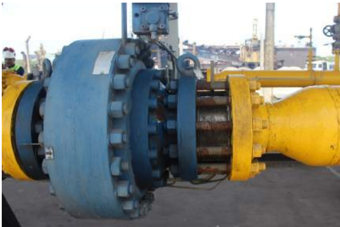
Foto 10: Parafusos oxidados (antes).
