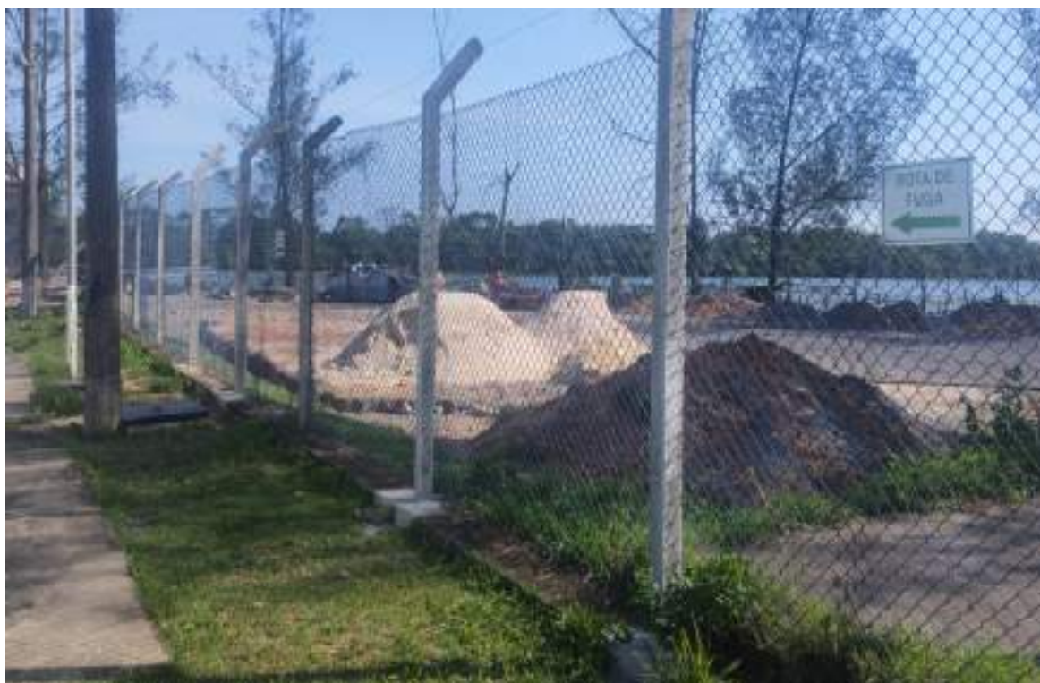
Foto 27: Adição de placas de rota de fuga.
