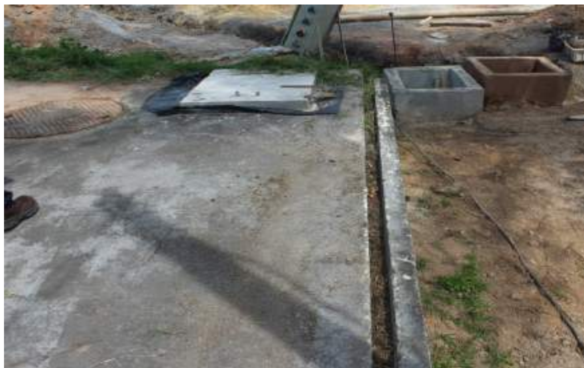
Foto 32: Parede cedendo (antes).
