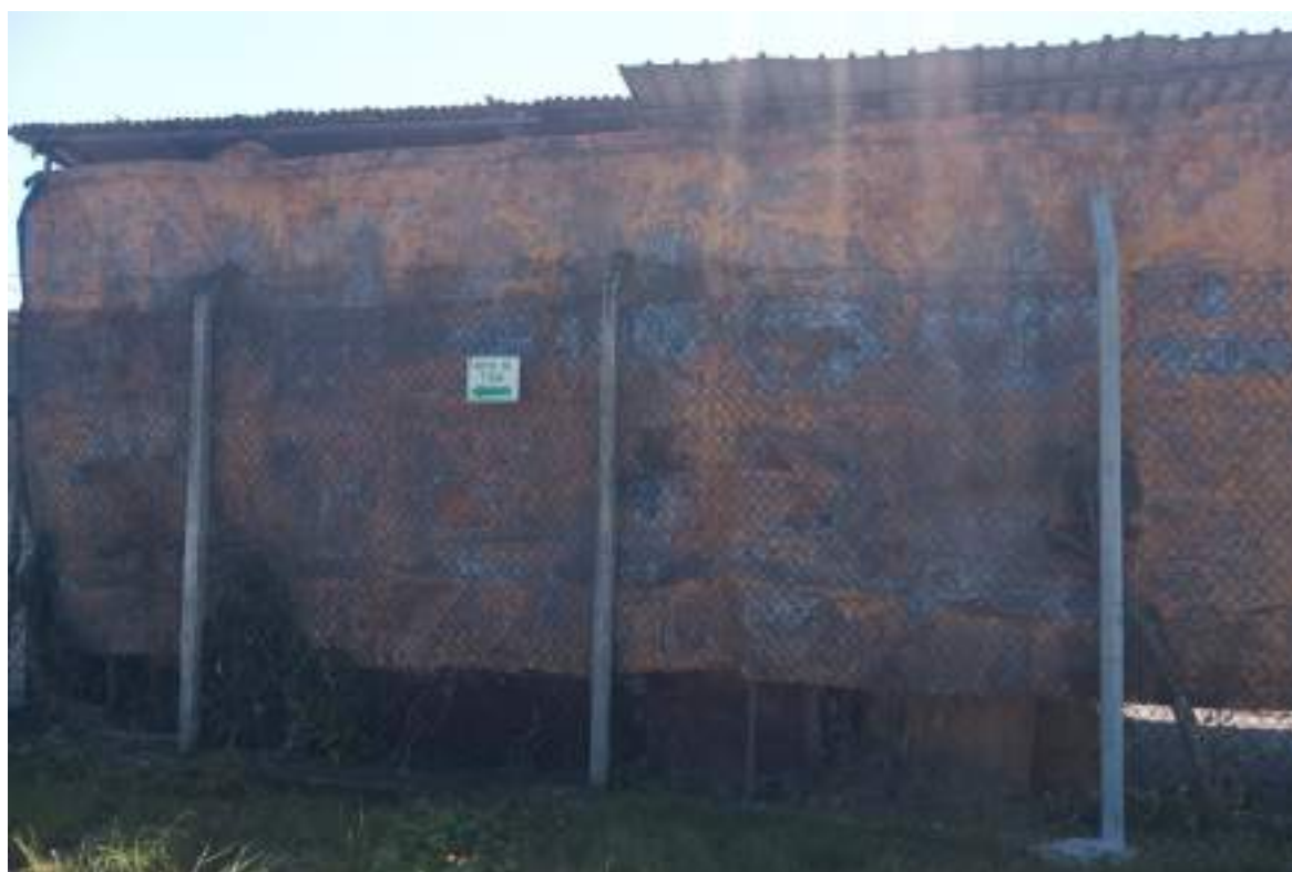
Foto 24: Capina alta, planta cobrindo cerca e placa de rota de fuga (depois).
