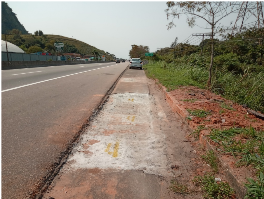
Foto 4: Trechos com recomposição provisória.
