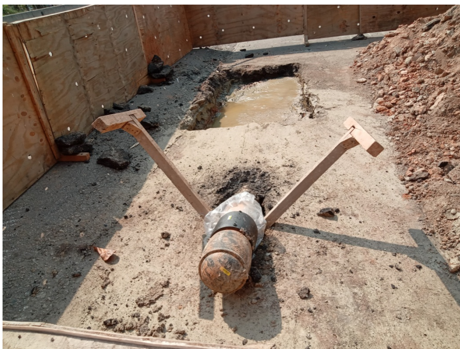
Foto 2: Ponta de rede PE Ø200 mm a ser conectada.
