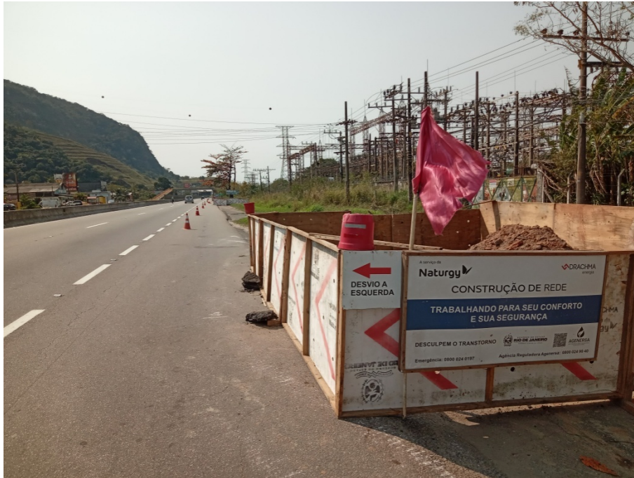
Foto 3: Sinalização da obra na pista.
