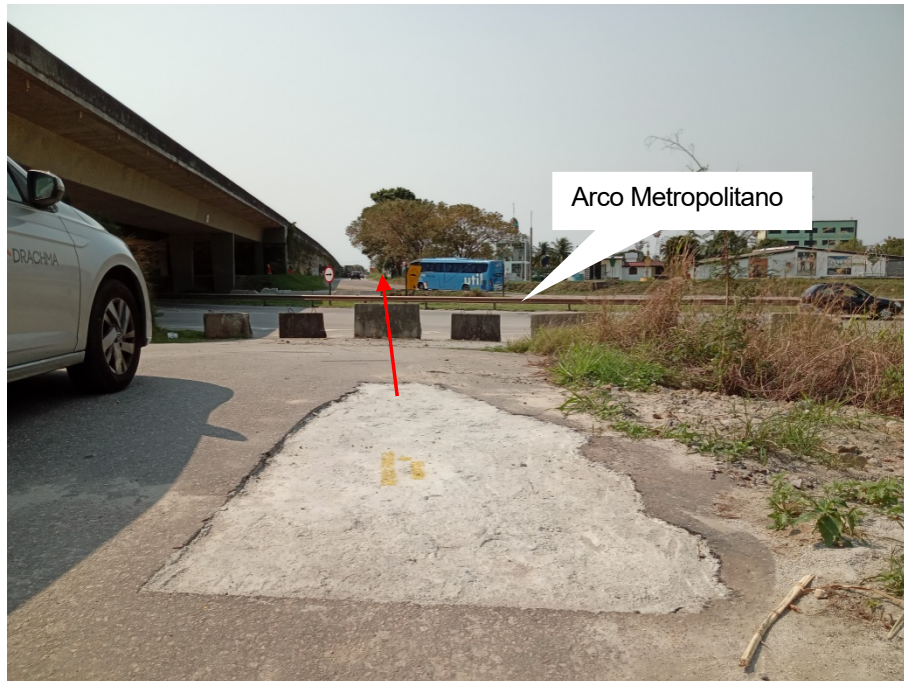
Foto 5: Recomposição provisória. (Ponto de travessia de rede aguardando licença)
