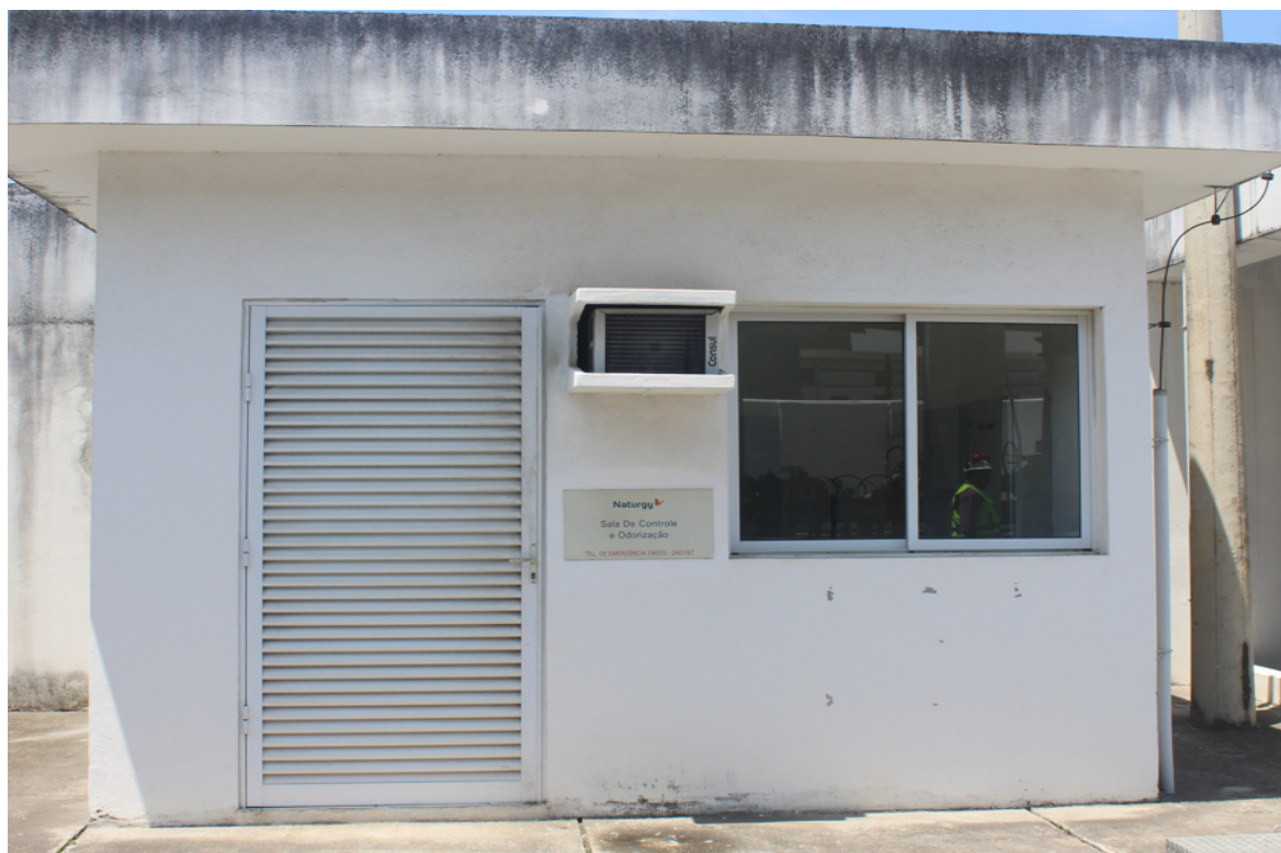
Foto 20: Sala de controle de odorização.
