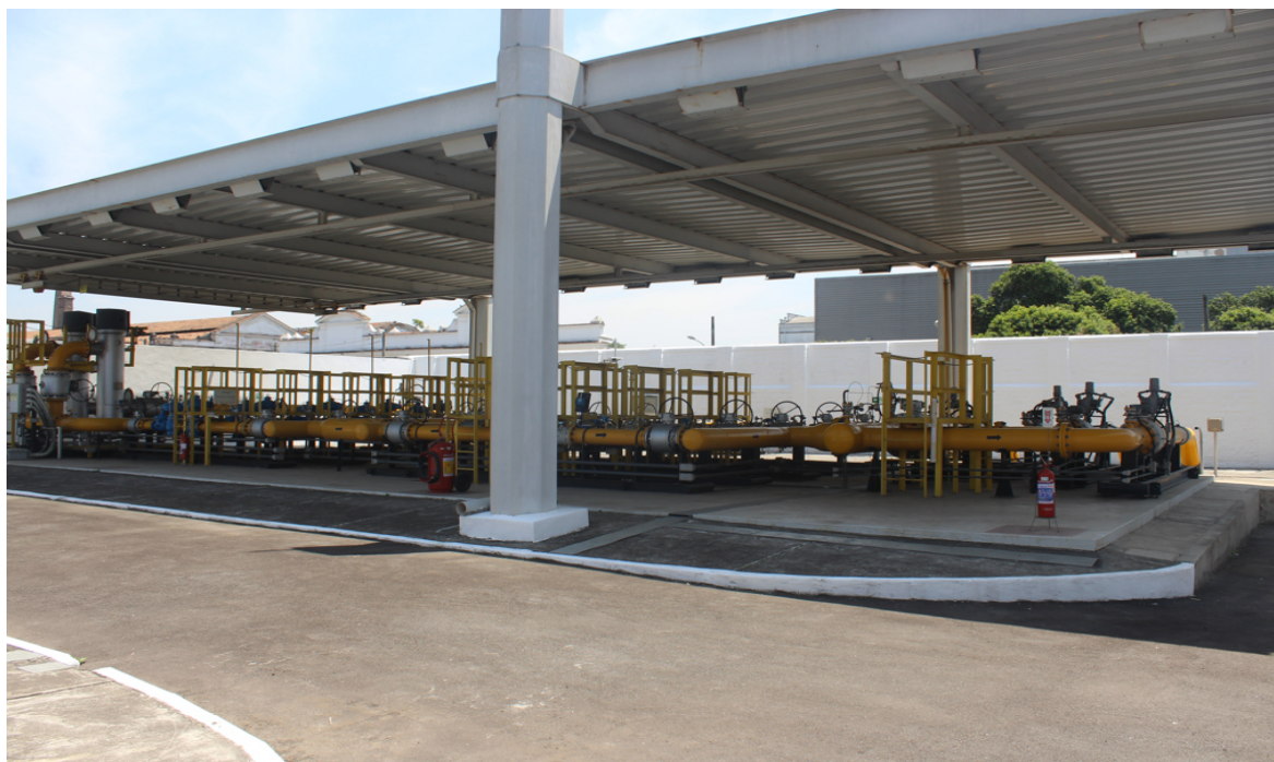
Foto 5: Cobertura da estação.
