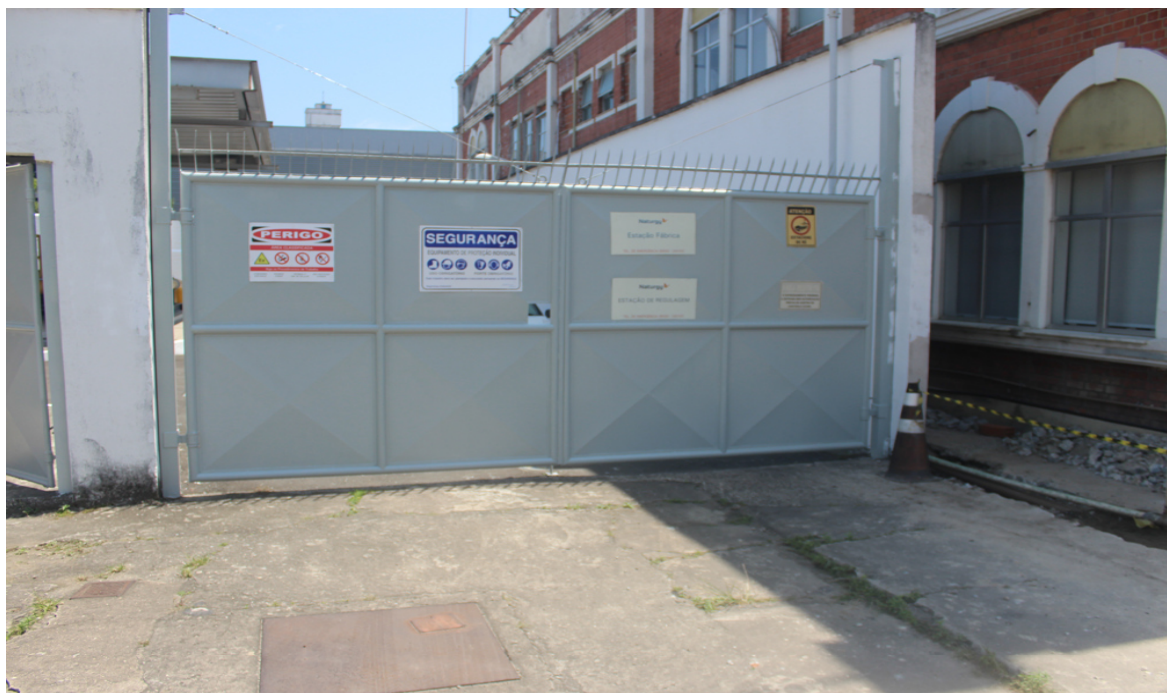
Foto 1: Acesso à Estação de Regulagem e Medição - Avenida Pedro II.
