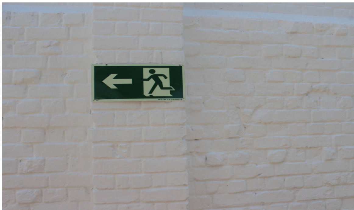
Foto 11: Placa de rota de fuga.
