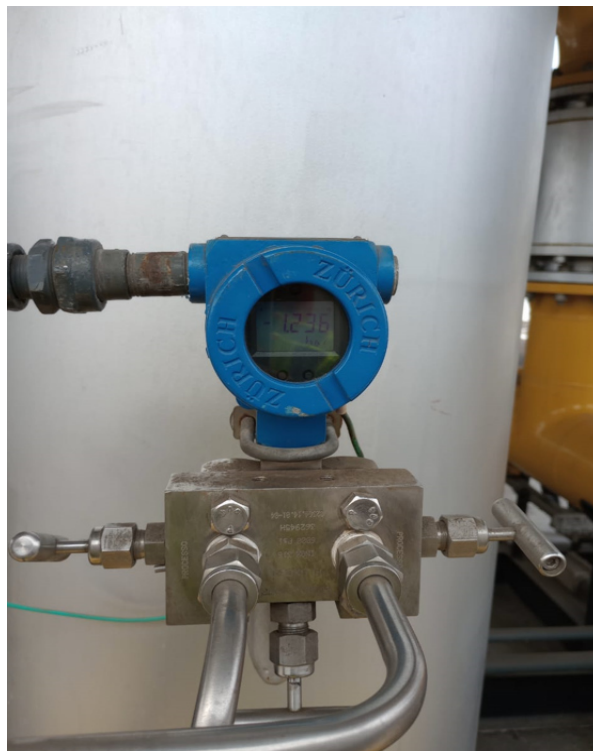
Foto 14: Transmissor do filtro (antes e depois).
