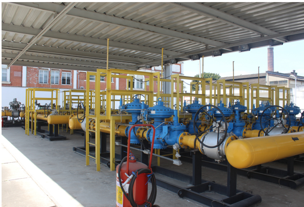
Foto 6: Estação de regulação e medição - ERM
