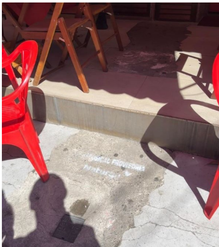
Foto 9: Trecho de recomposição provisória no passeio do Buteco do Portuga.
