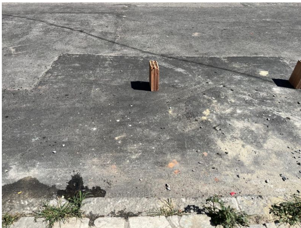
Foto 3: Ponto de recomposição permanente na via diante de uma casa em obra.
