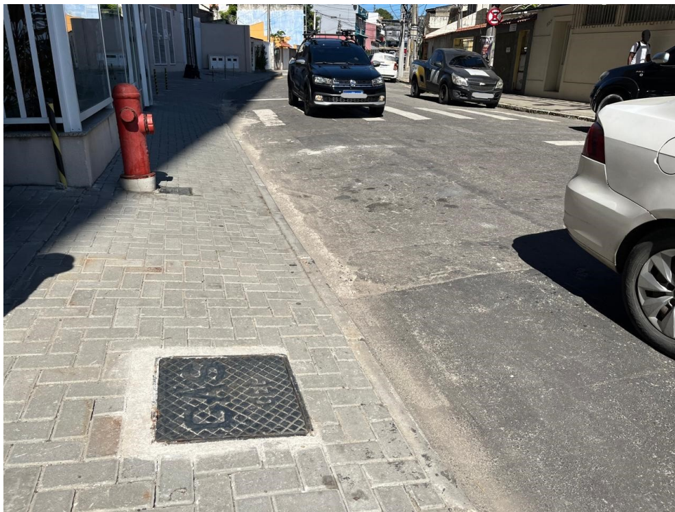
Foto 1: Ponto onde a rede anterior termina e onde iniciou-se a expansão.
