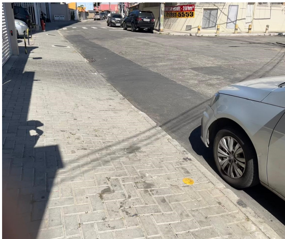
Foto 2: Trecho da via com recomposição onde a obra se iniciou, com marco plano visível.
