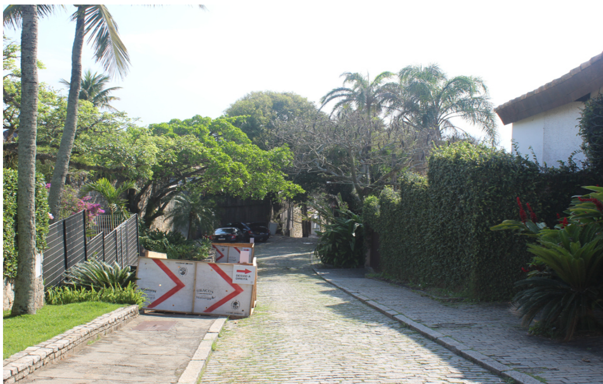
Foto 12: Sinalização e isolamento de obra.
