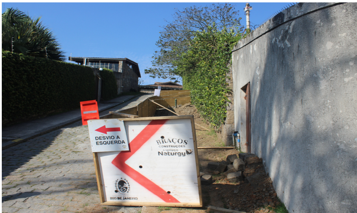
Foto 11: Sinalização e isolamento de obra.
