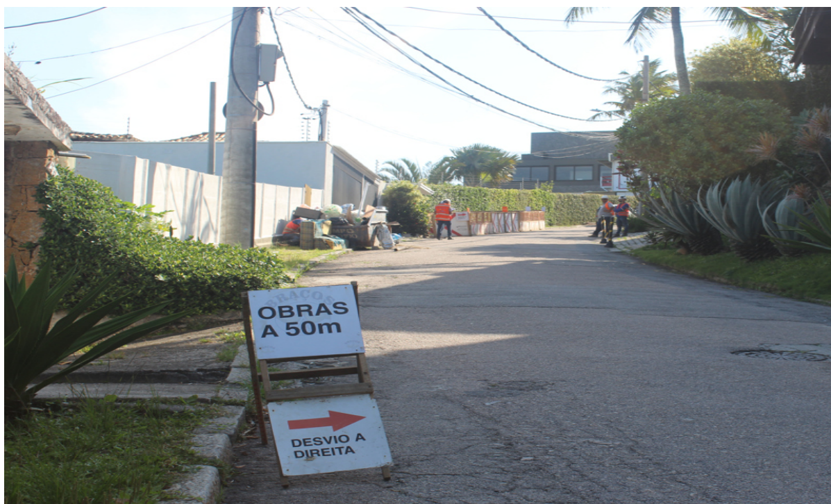
Foto 1: Indicação de obras à frente na Rua José Pancetti, nº 385.
