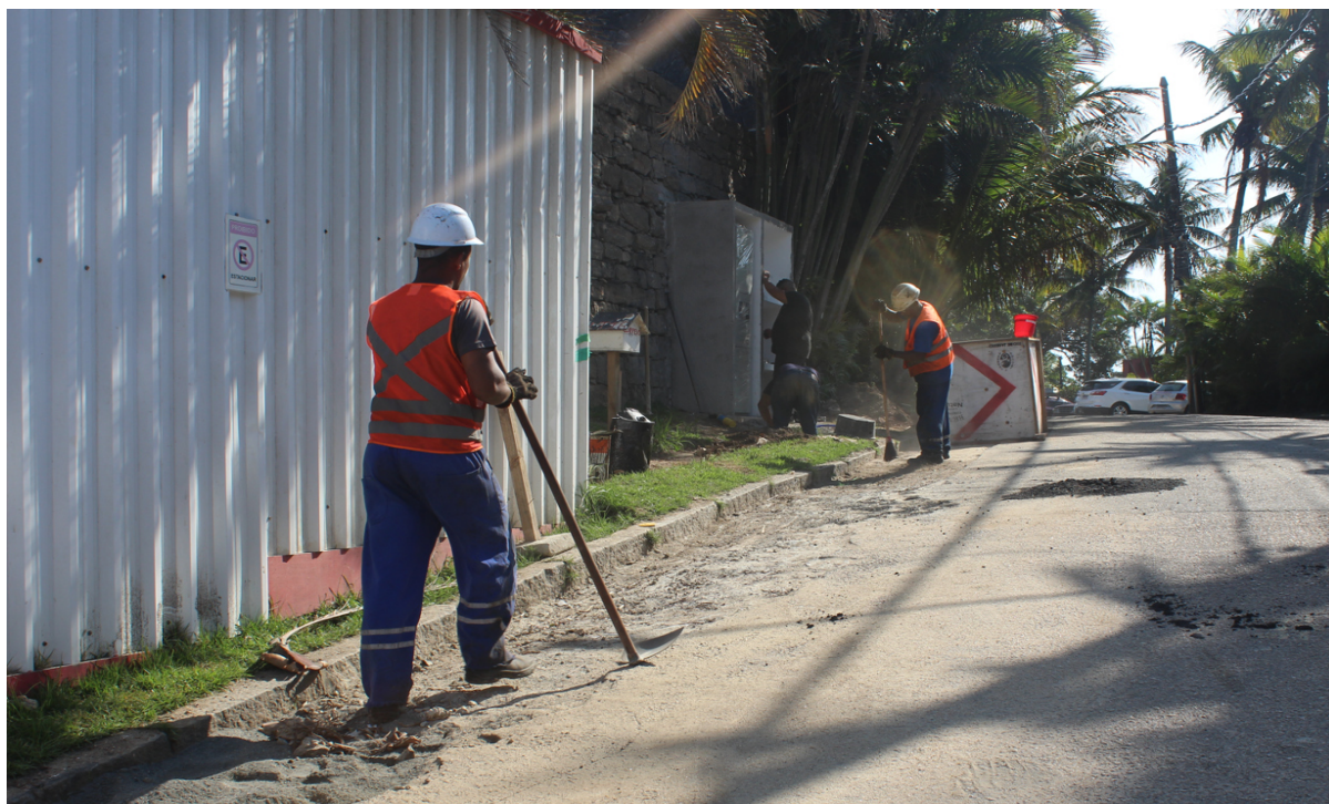
Foto 3: Trabalhadores da Braços preparando trecho da via para receber a recomposição.
