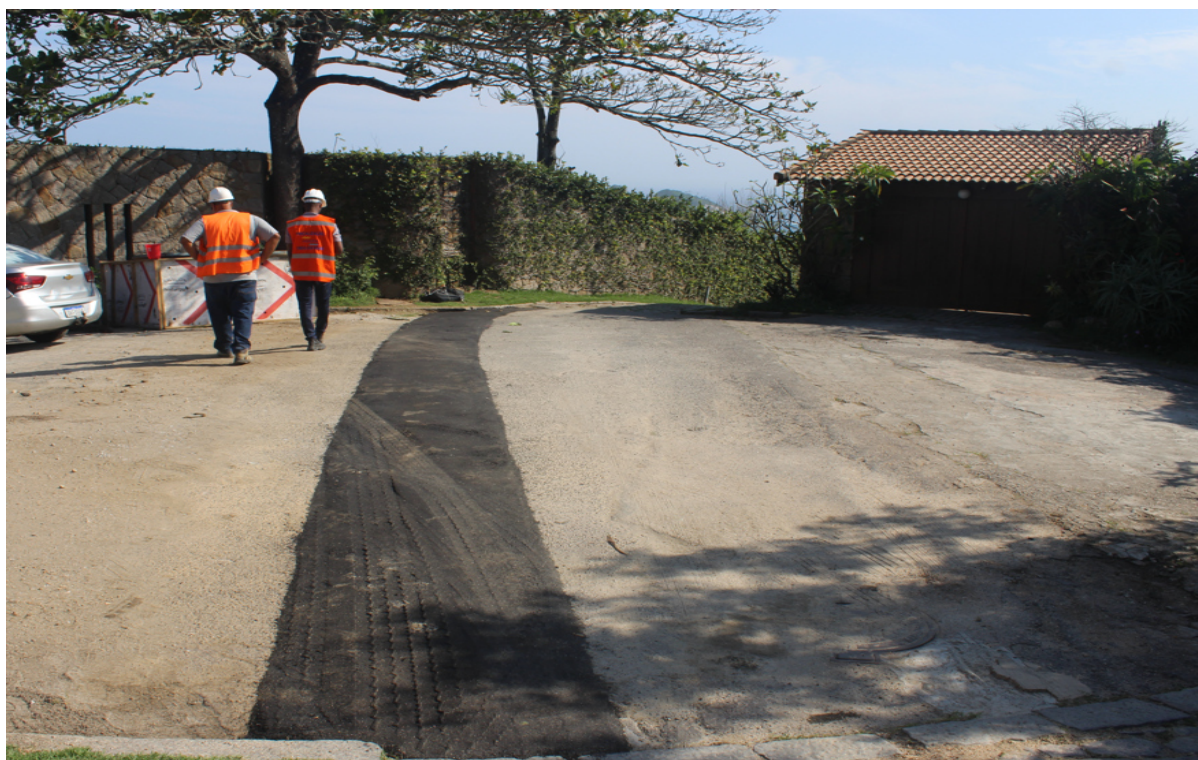
Foto 10: Recomposição asfáltica permanente.
