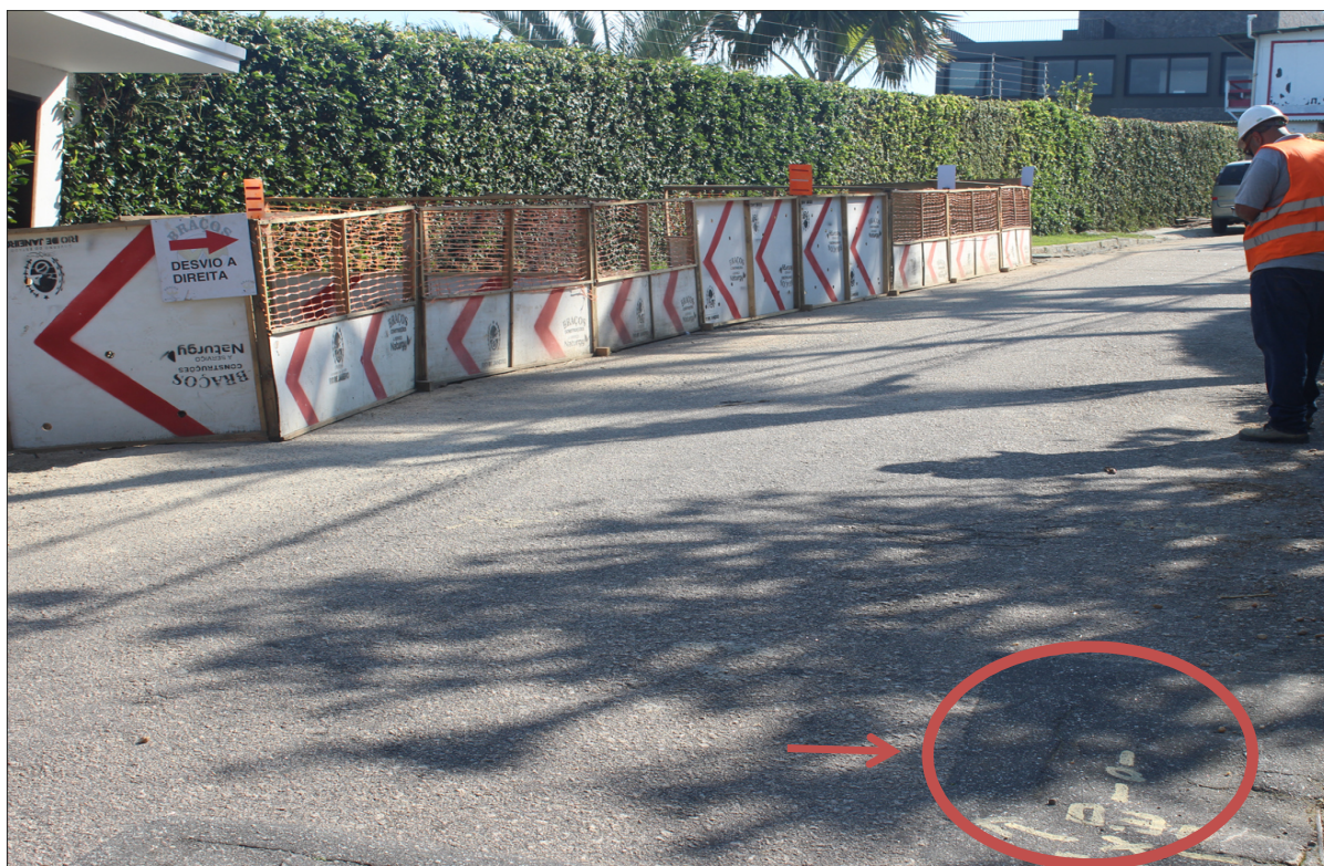
Foto 2: Sinalização de desvio de trânsito, isolamento e ponto de interligação com a rede existente.
