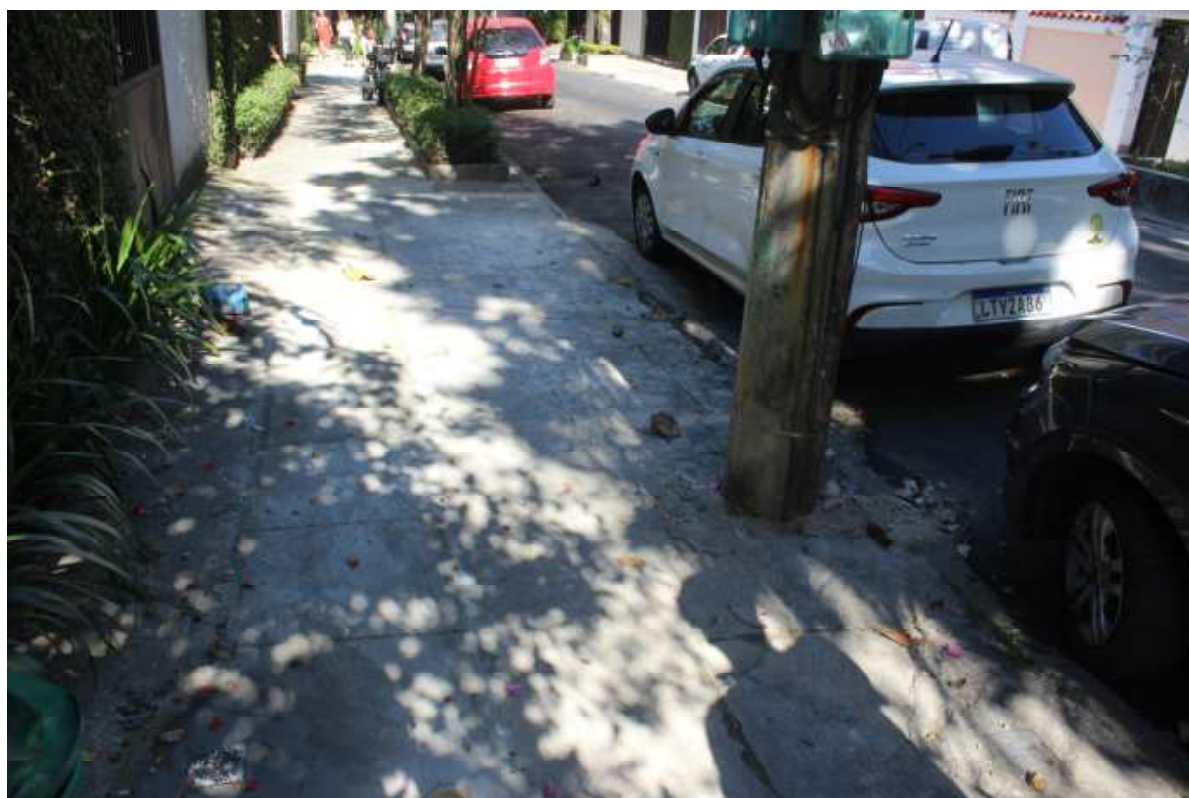
Foto 6: Recomposição na calçada.
