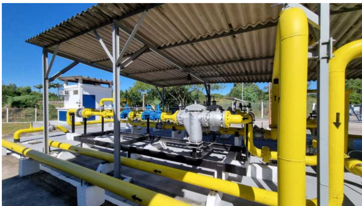
Foto 6: Estação de Regulagem e Medição da FCC.
