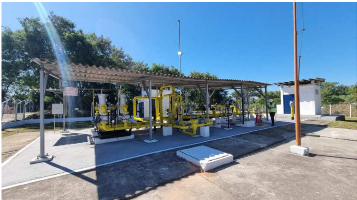
Foto 2: Vista frontal da estação.
