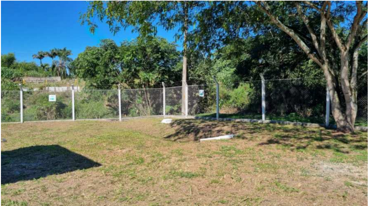
Foto 13: Cerca e sinalização de rota de fuga da estação.
