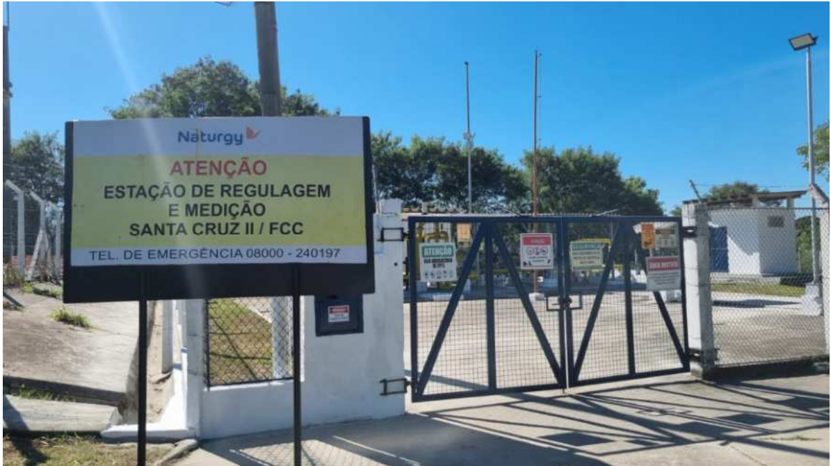
Foto 1: Portão de entrada e placa de identificação da ERD DISTRITO INDUSTRIAL DE SANTA CRUZ em Santa Cruz, Rio de Janeiro/RJ.
