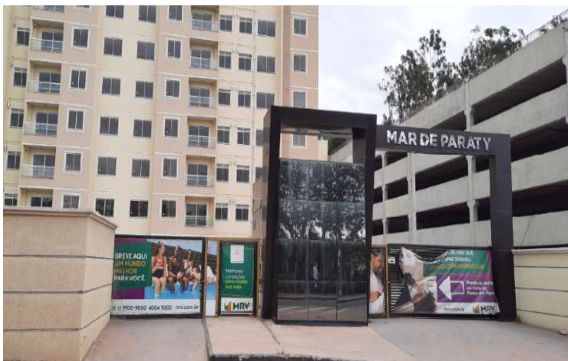
Foto 1: Fachada do condomínio
