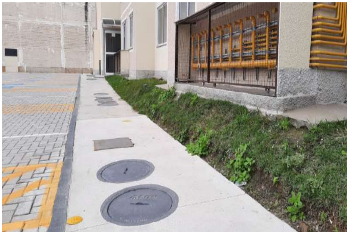
Foto 4: Marco plano indicando presença de rede
