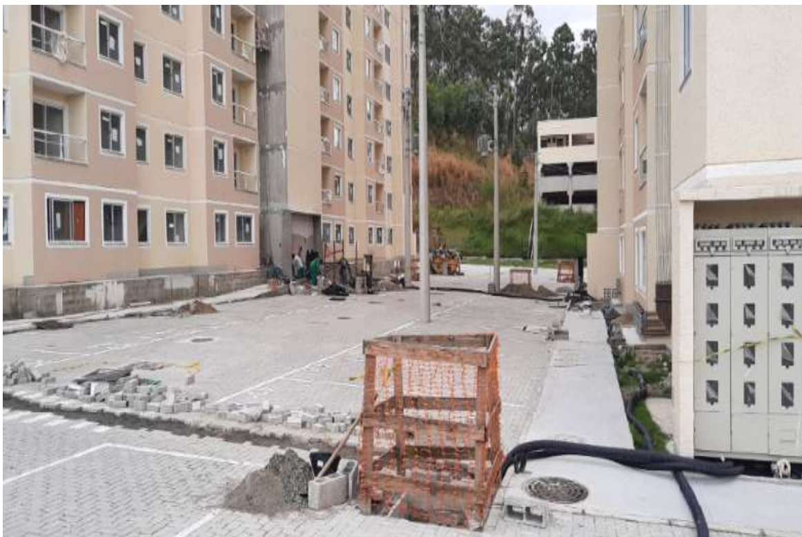
Foto 2: Situação atual das obras do condomínio
