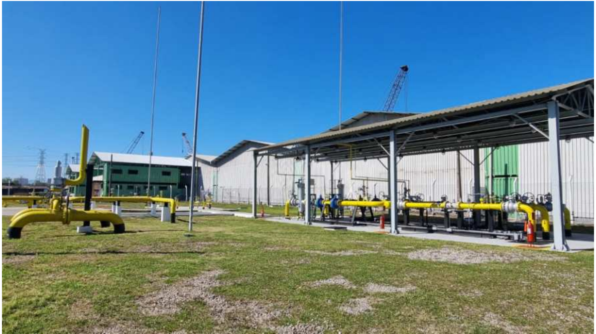
Foto 3: Vista frontal da estação.
