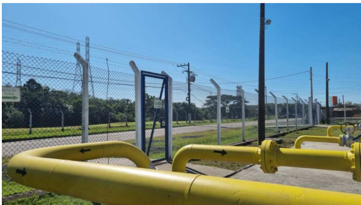
Foto 16: Cerca e sinalização de rota de fuga.
