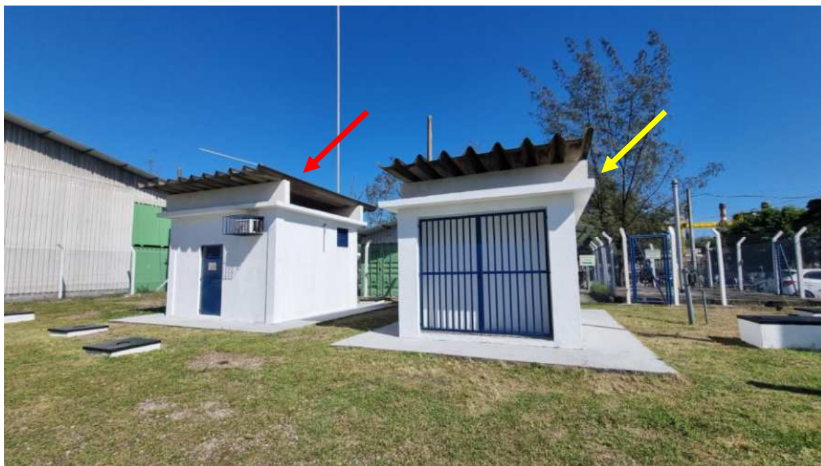
Foto 13: Sala de controle do sistema de telemetria (seta vermelha) e sala de armazenamento de material (seta amarela).
