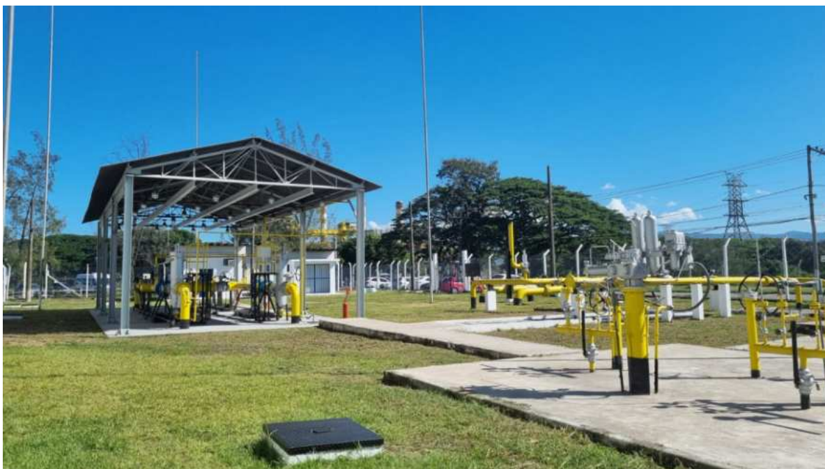
Foto 17: Vista lateral da estação – a mesma se encontra em bom estado de conservação.
