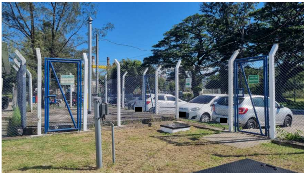
Foto 15: Sinalização de segurança e de rota de fuga.
