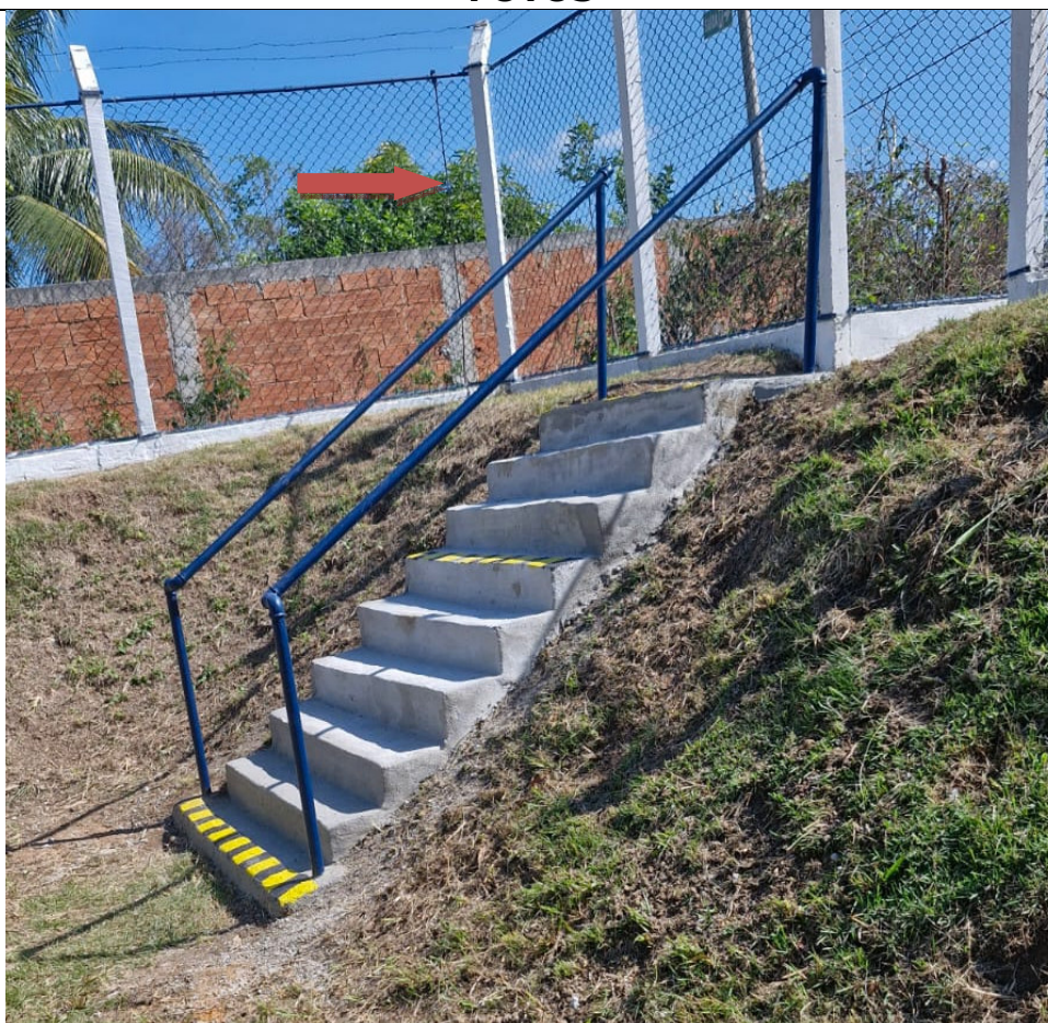
Foto 7: Escada de acesso ao duto. Destaque para fio de aterramento.
