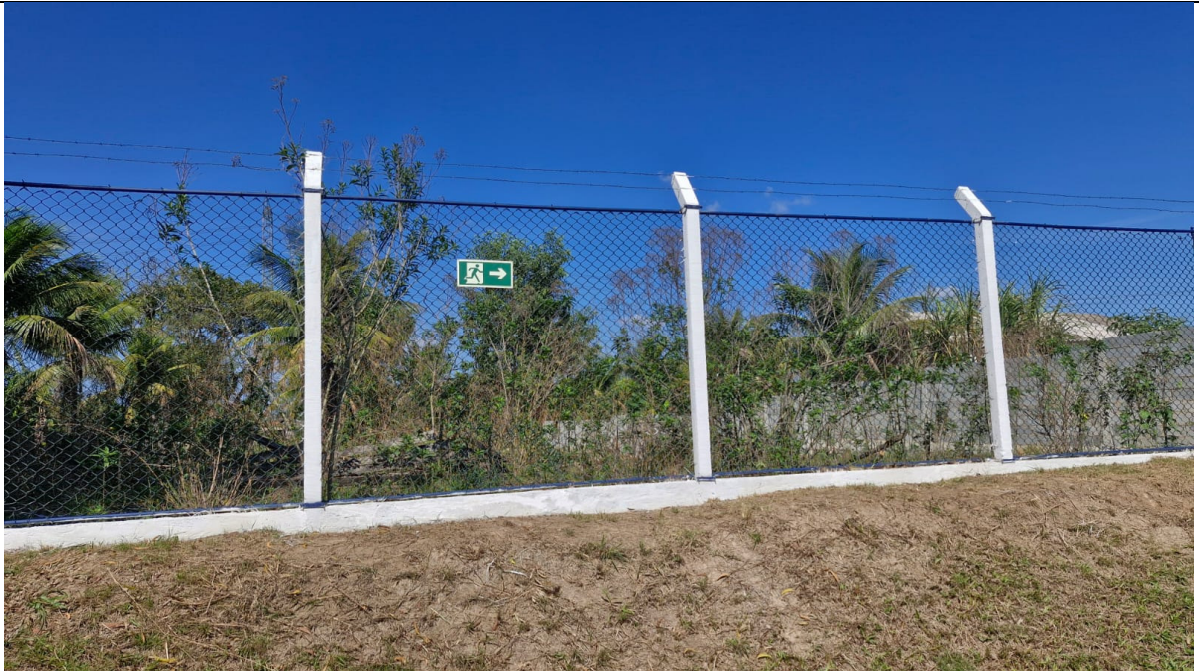
Foto 5: Grades de delimitação e sinalização da Rota de Fuga.
