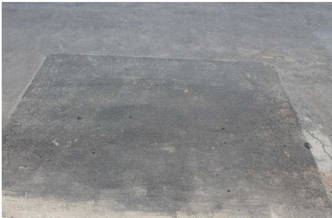
Foto 4: Recomposição da via permanente.
