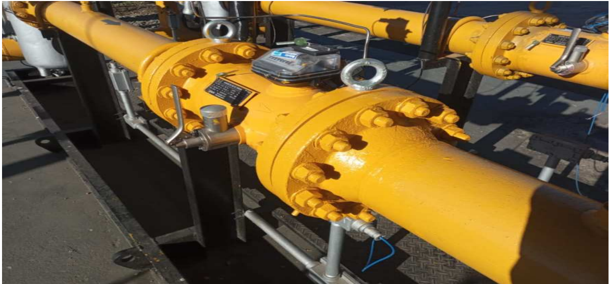
Foto 15: Pintura realizada na conexão do medidor de gás turbina com a tubulação da estação.
