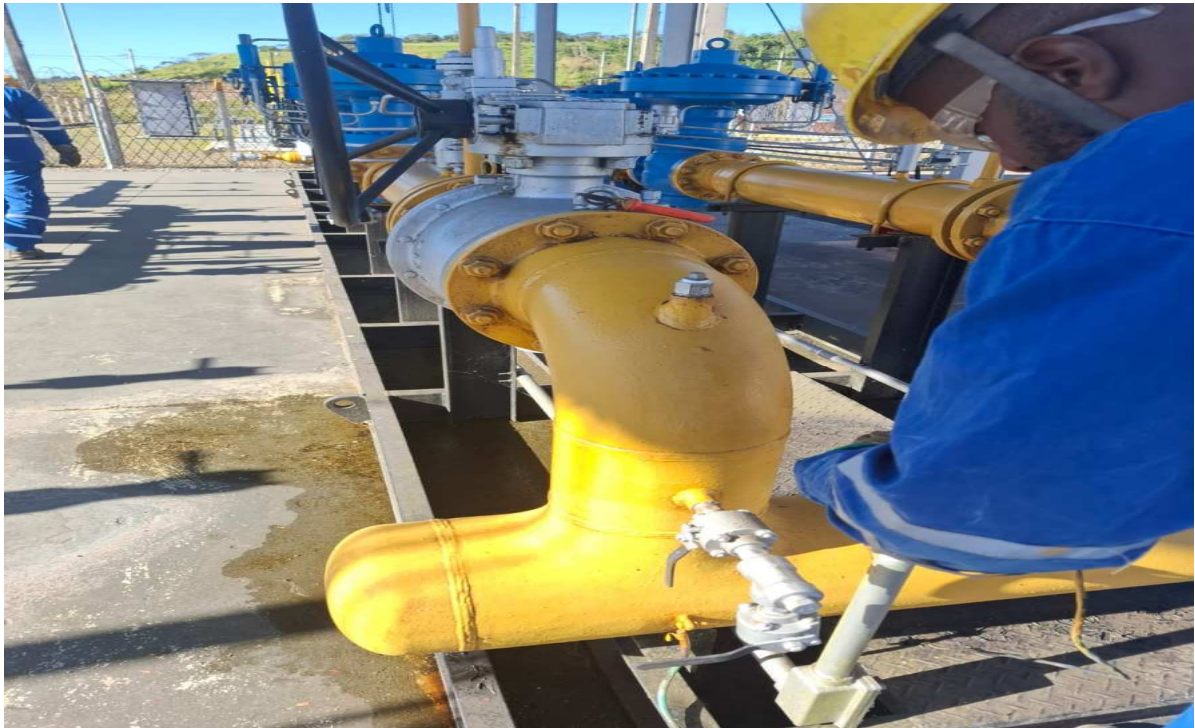
Foto 17: Retirada de equipamento de medição.
