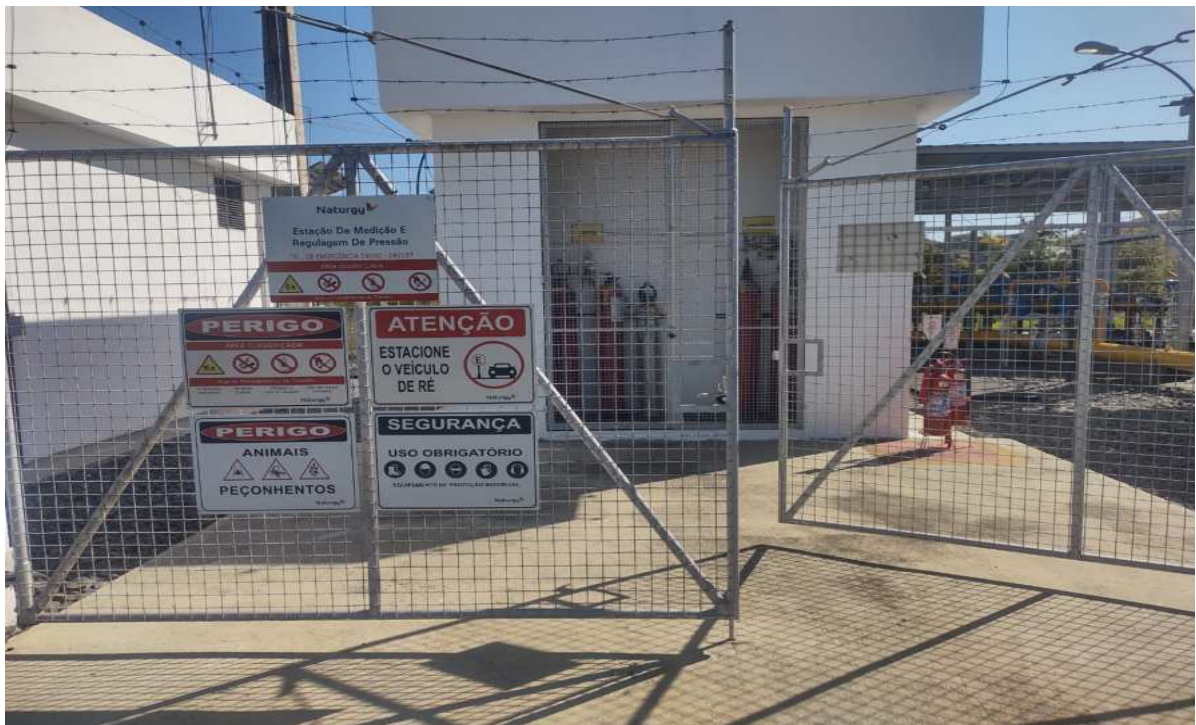
Foto 2: Portão de acesso e placas de sinalização de segurança.
