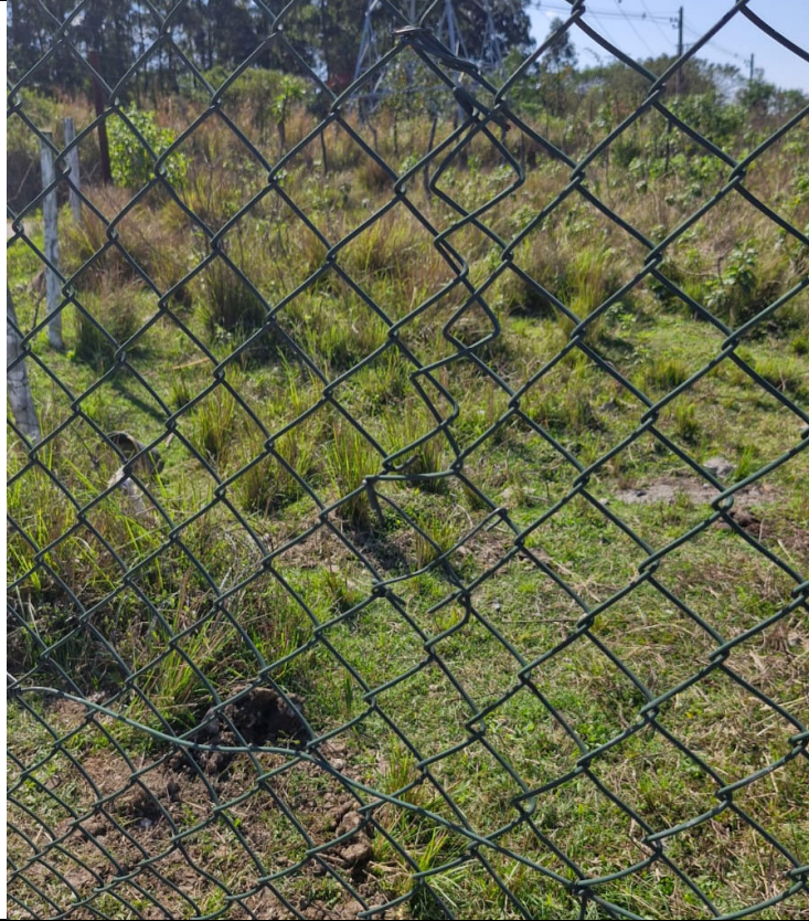
Foto 5: Grade com emendas. Estação é alvo de invasões para furtar fios de aterramento.
