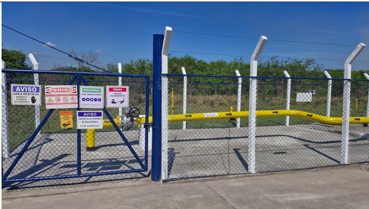
Foto 1: Vista da estação na entrada.
