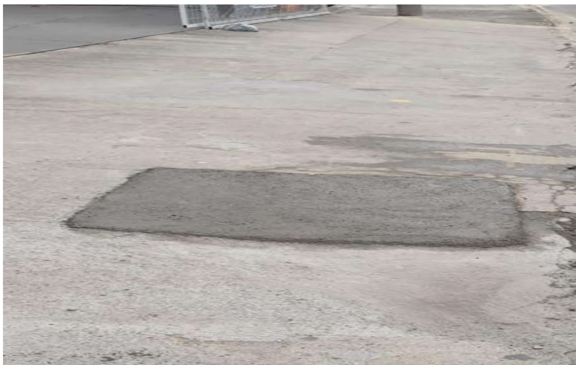
Foto 5: Reparo da falha na recomposição do passeio (depois).
