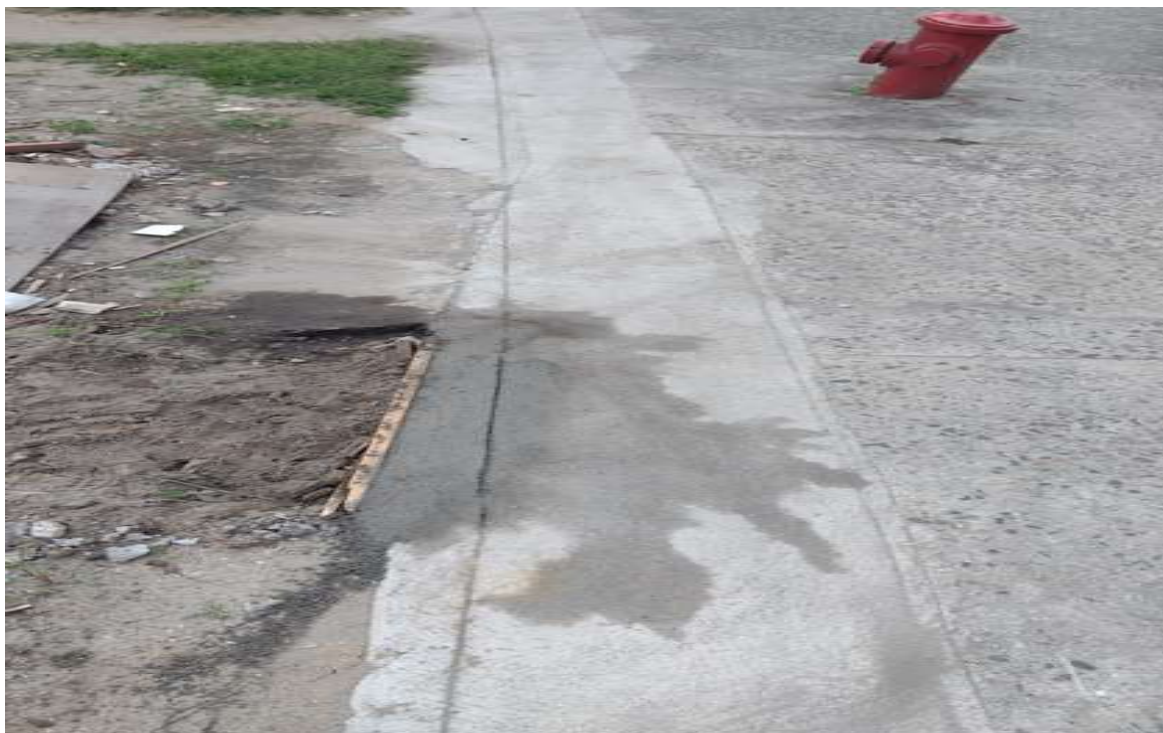
Foto 3: Reparo da falha na recomposição do passeio (depois).
