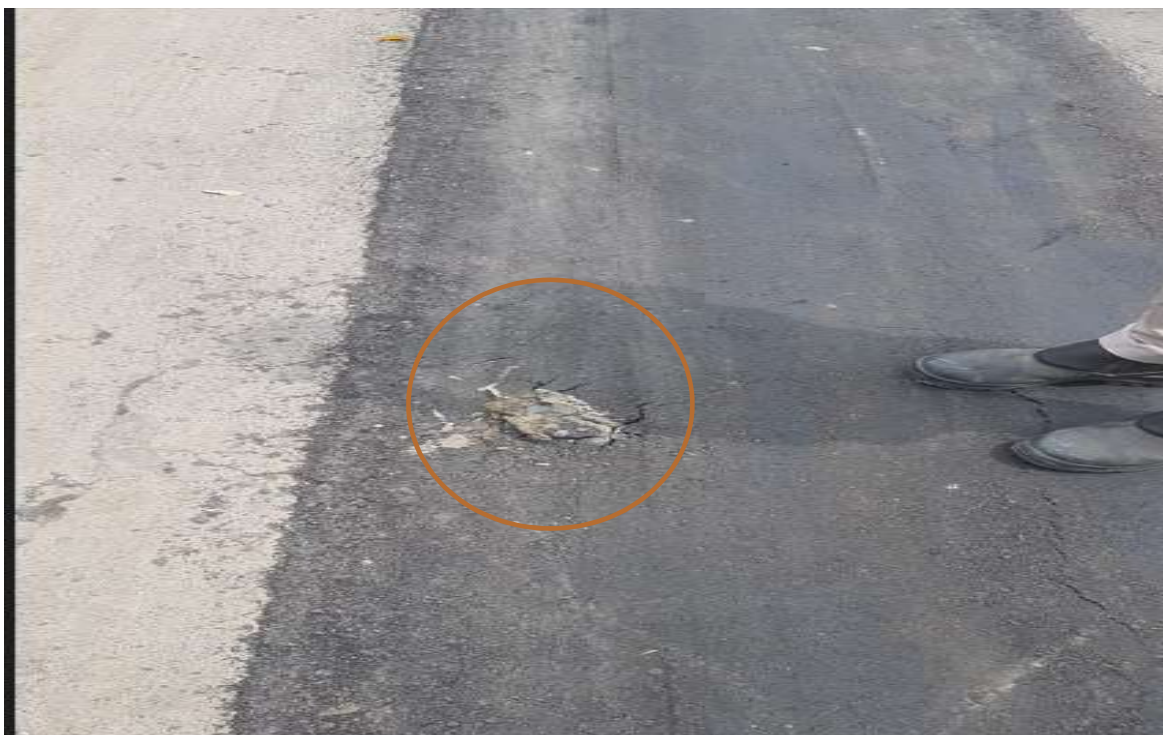
Foto 7 : Recomposição na pista com irregularidade (antes).
