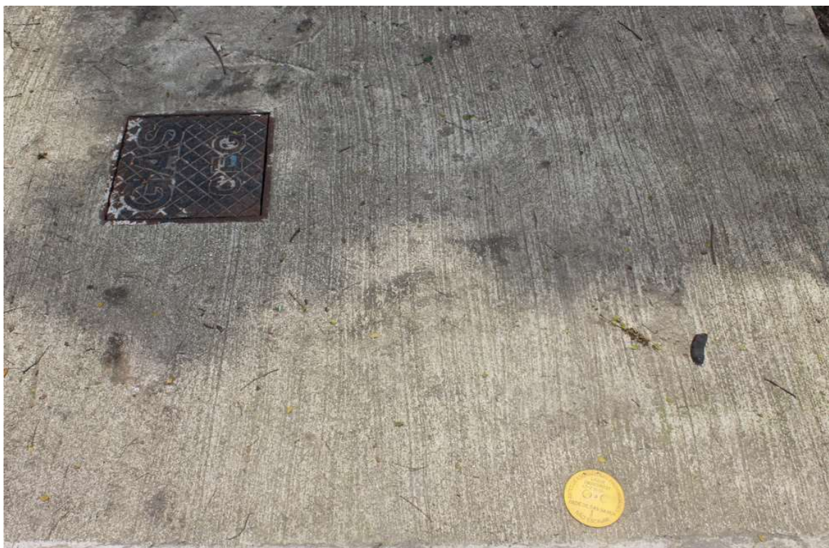
Foto 2: Recomposição do passeio, válvula de segurança e marco plano.
