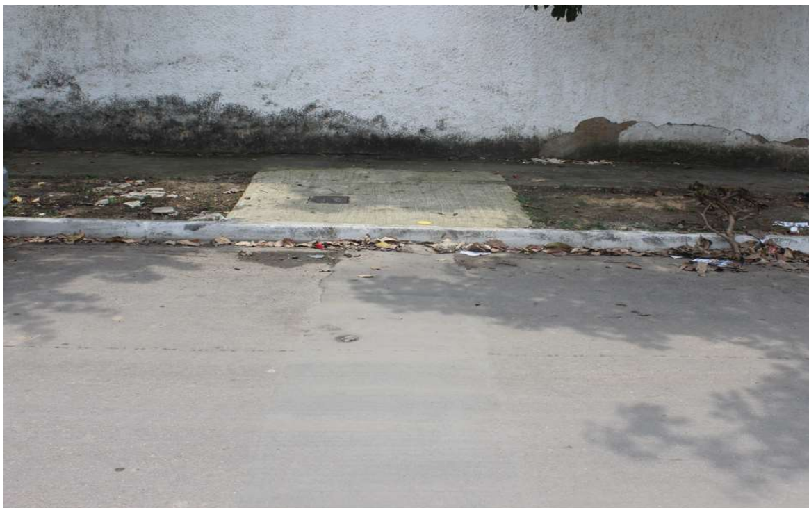
Foto 3: Recomposição do trecho de travessia.
