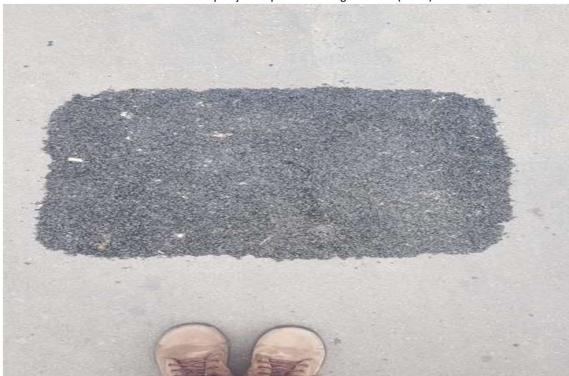
Foto 7 : Recomposição na pista com irregularidade (antes).
