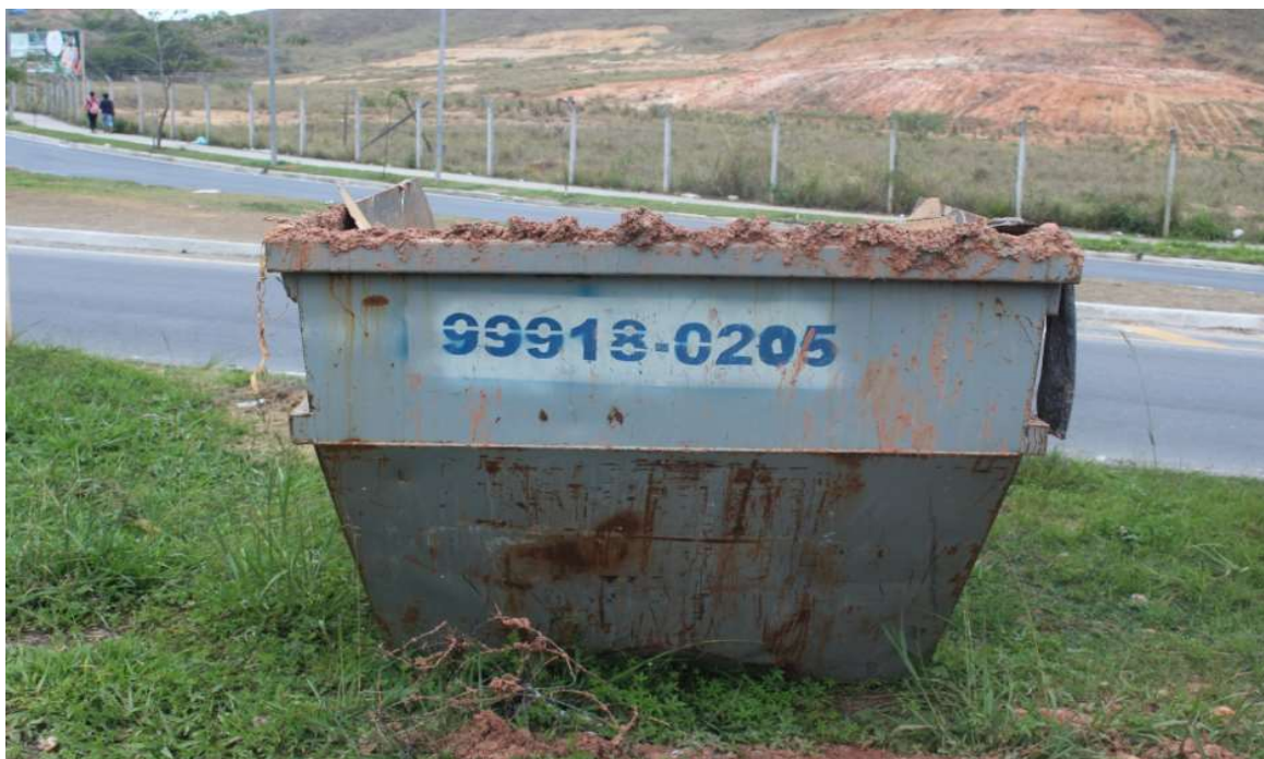
Foto 8: Caçamba de descarte sem sinalização e sem cobertura de tapume (antes).
