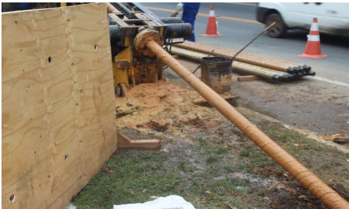
Foto 18: Perfuratriz hidráulica após a execução de uma perfuração.
