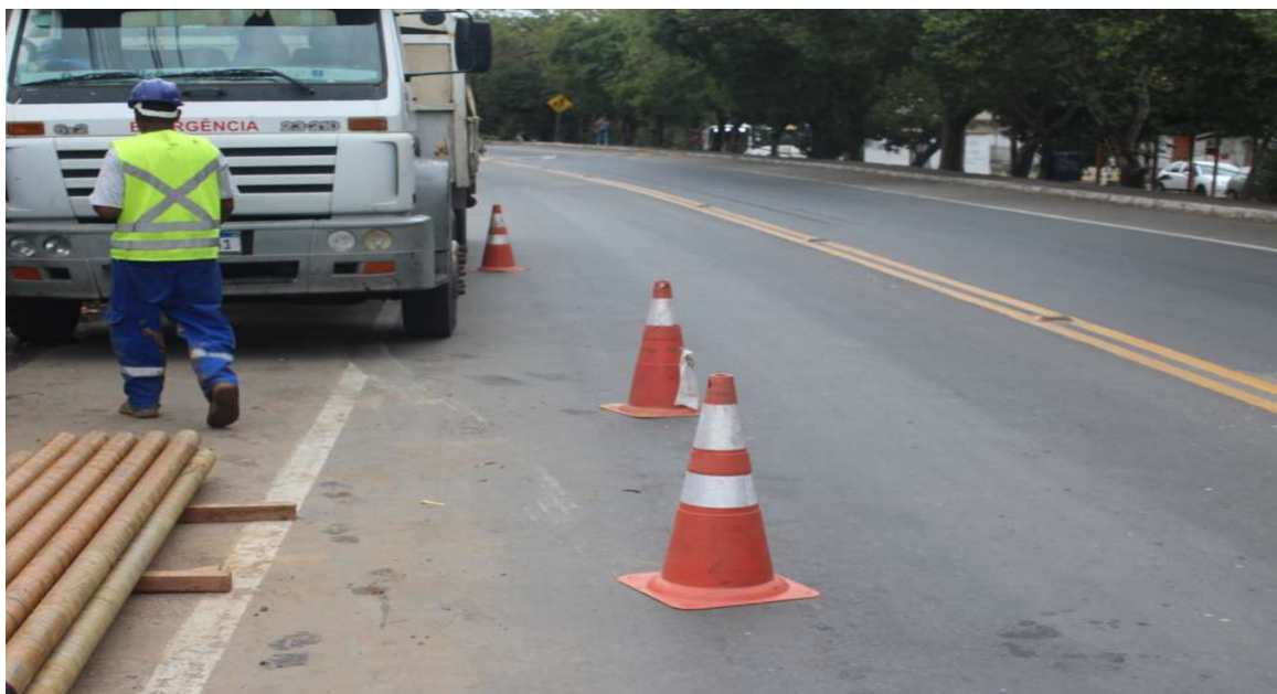
Foto 19: Sinalização na via com cones.
