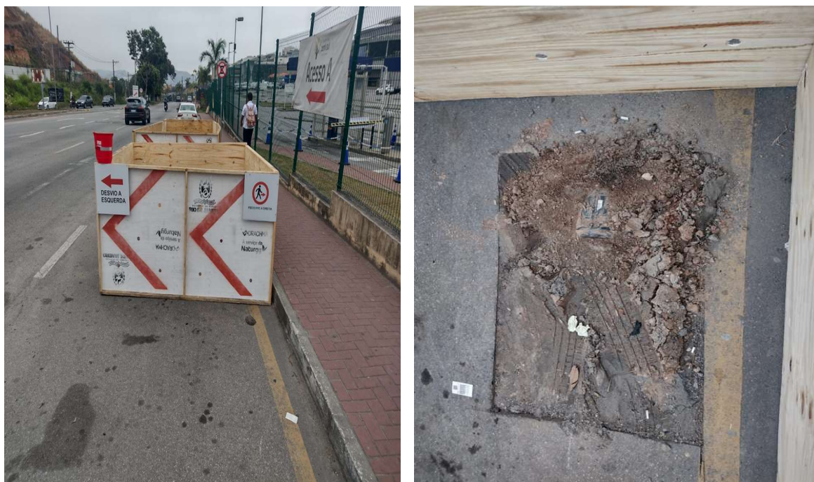
Foto 4: Obra na via com proteção e sinalização (depois).
