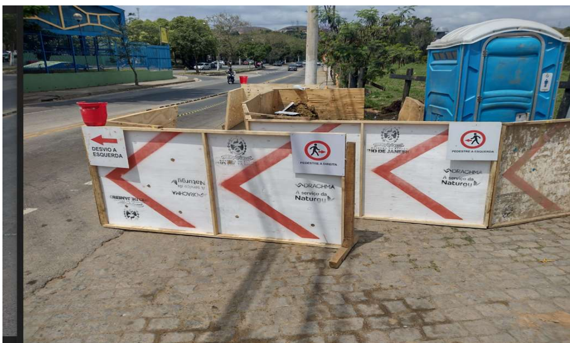
Foto 14: Tapume com sinalização (depois).
