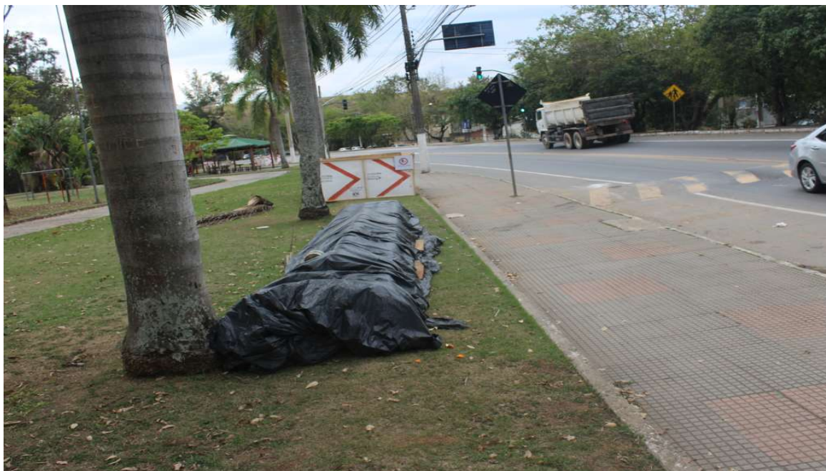
Foto 20: Tubulação sem proteção ou isolamento (antes).
