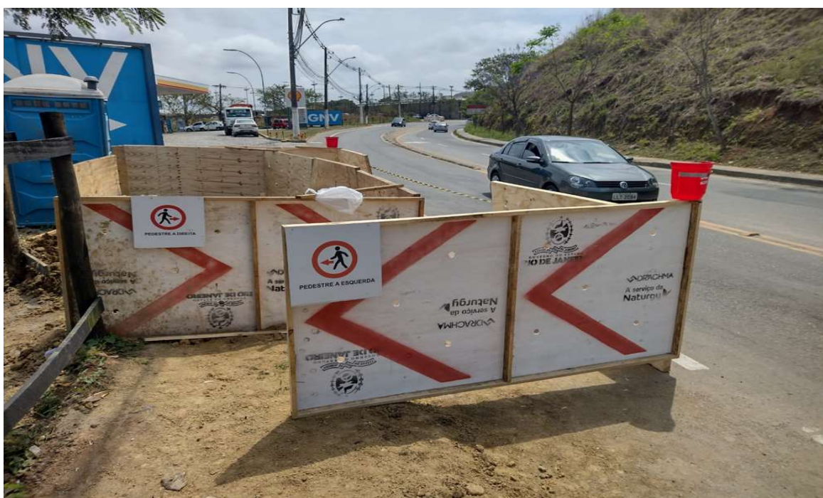
Foto 16: Tapume com sinalização (depois).
