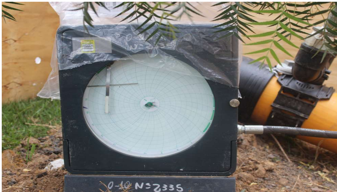
Foto 11: Manômetro utilizado no teste de estanqueidade, em curso, da rede.
