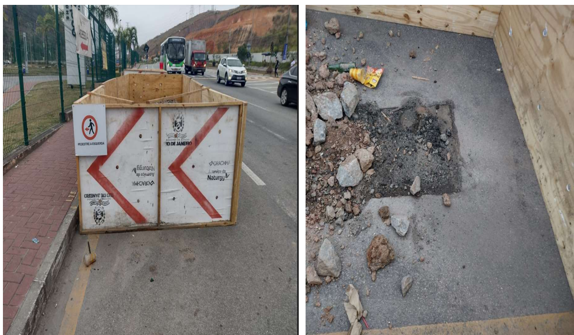
Foto 2: Tapume alinhado e ajustado (depois).
