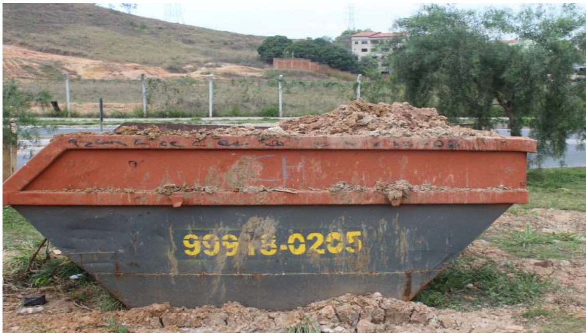
Foto 7: Caçamba de descarte sem sinalização e sem cobertura de tapume (antes).
