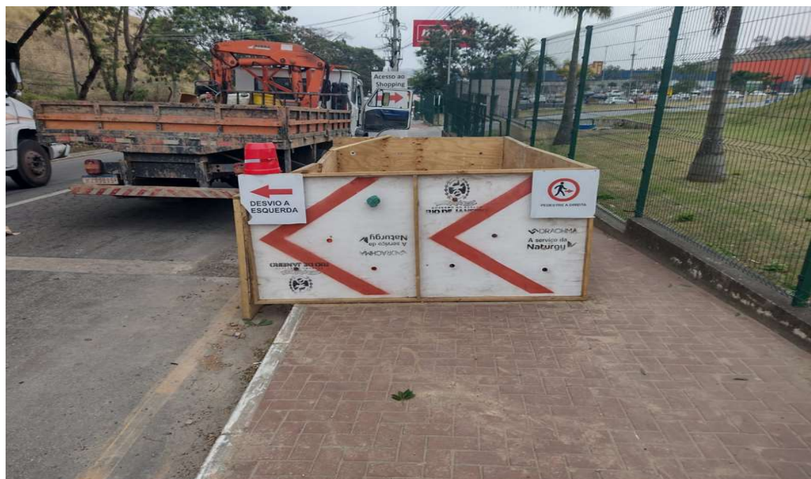
Foto 6: Tapume com sinalização (depois).
