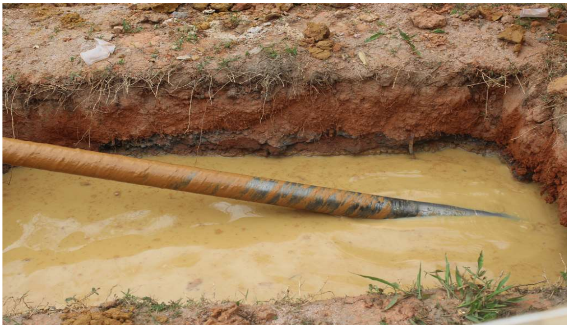
Foto 17: Execução da perfuração com uma perfuratriz hidráulica.
