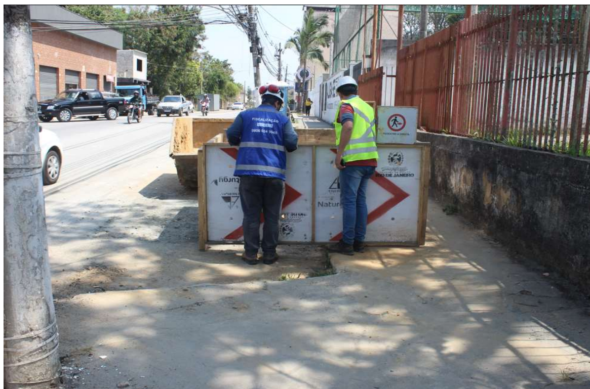
Foto 4: Equipe da AGENERSA durante a vistoria na Avenida Francisco Torres.
