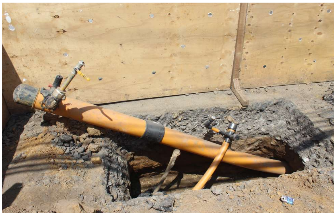
Foto 3 : Derivação de rede e ramal.
