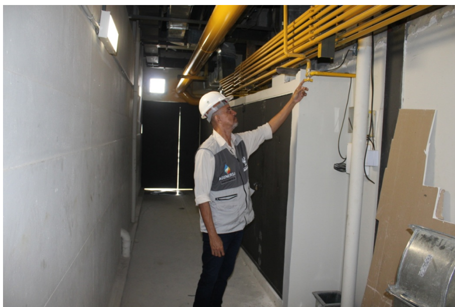
FOTO 26 – Corredor técnico do mercado em vistoria pela AGENERSA
