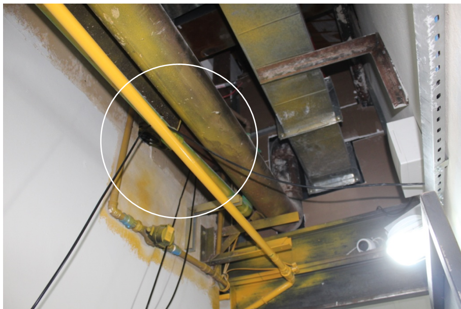
FOTO 05 – Passagem da tubulação junto a cabeamentos (< 20 cm)
