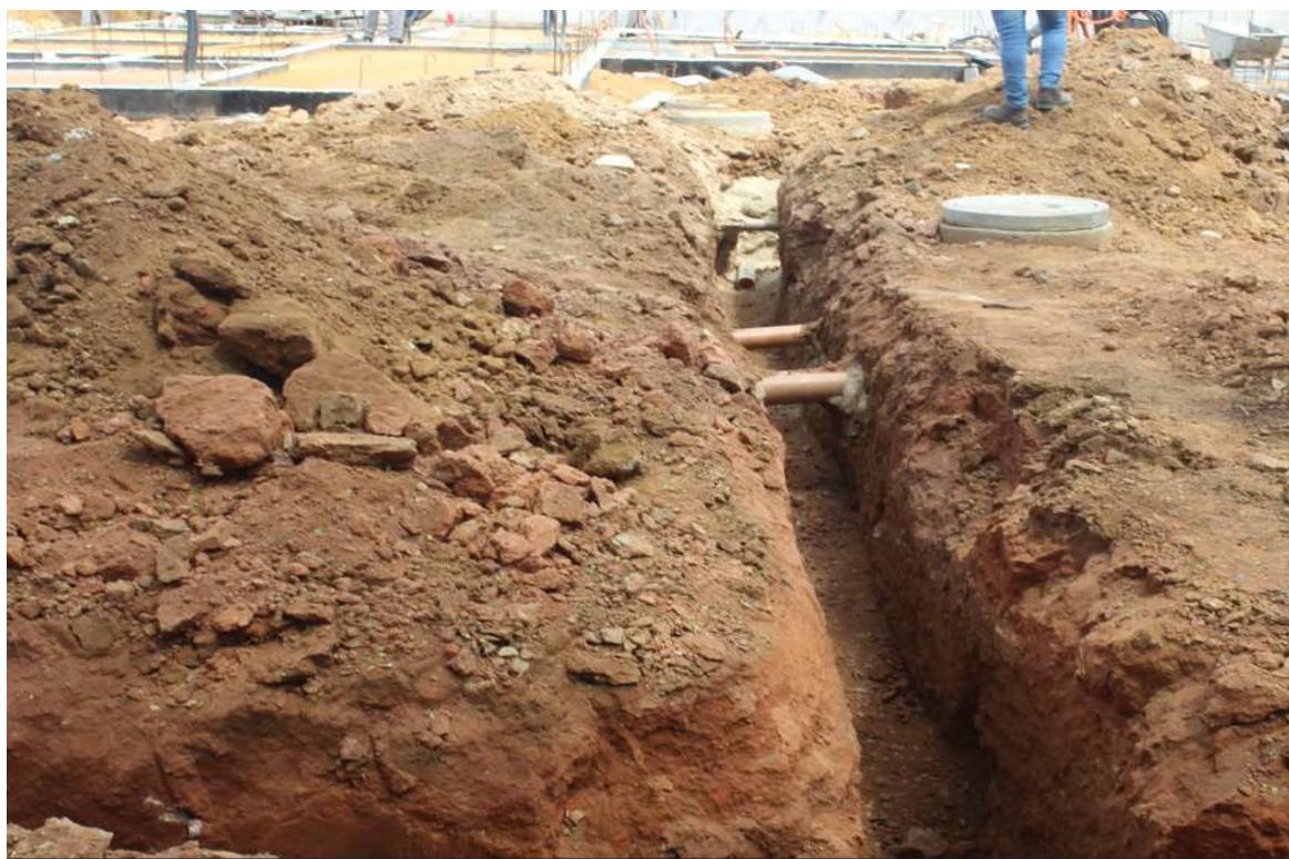
Foto 4: Abertura para assentamento de dutos de gás.
