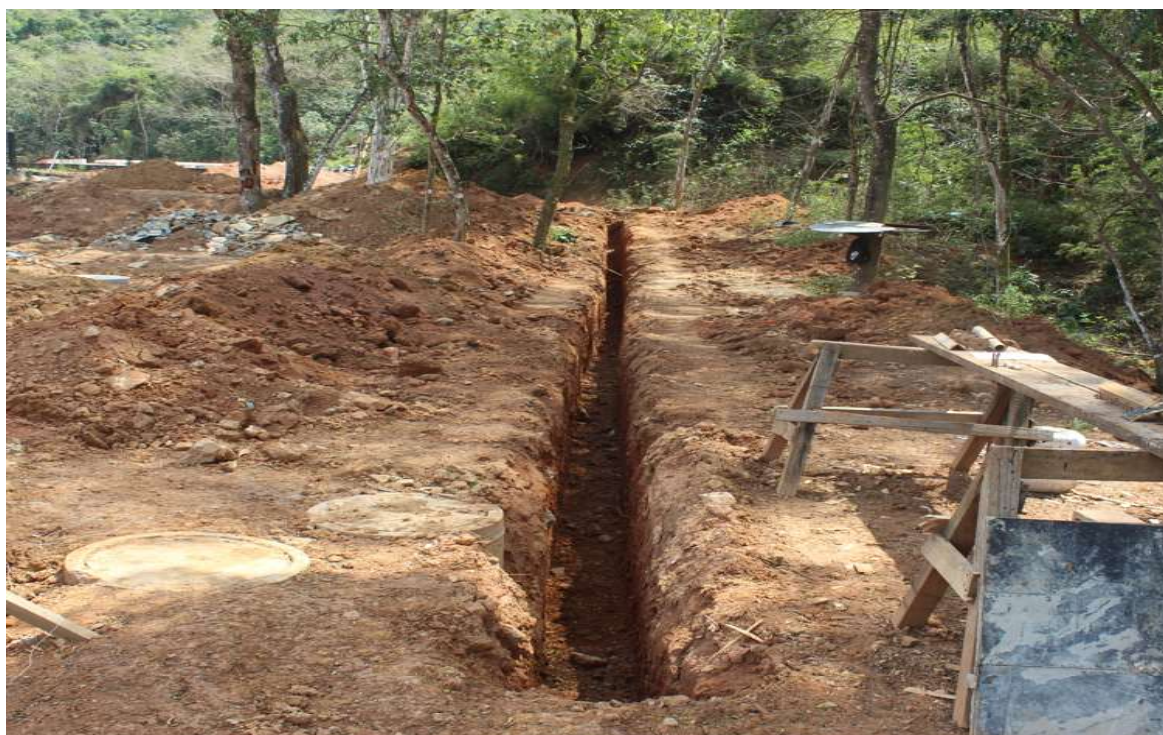
Foto 3: Abertura para assentamento de dutos de gás.
