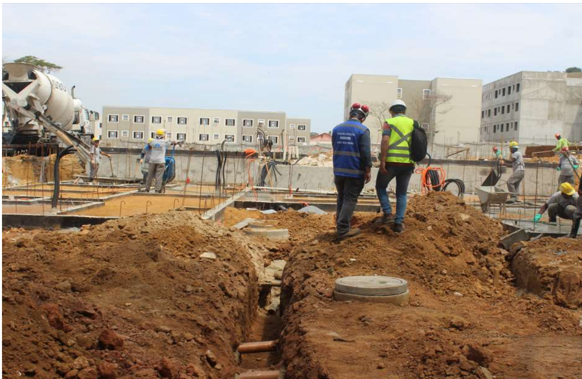
Foto 2: Equipe de vistoria da AGENERSA.
