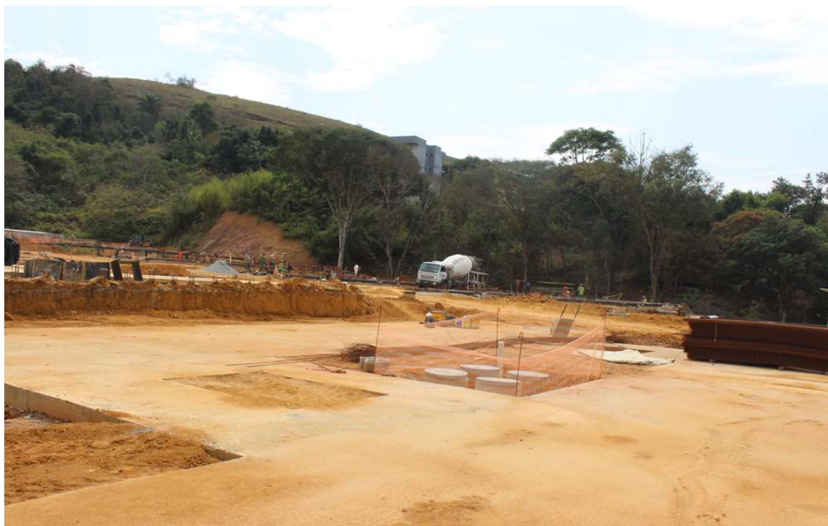
Foto 1: Canteiro de obras, pertencente a construtora, em fase inicial.
