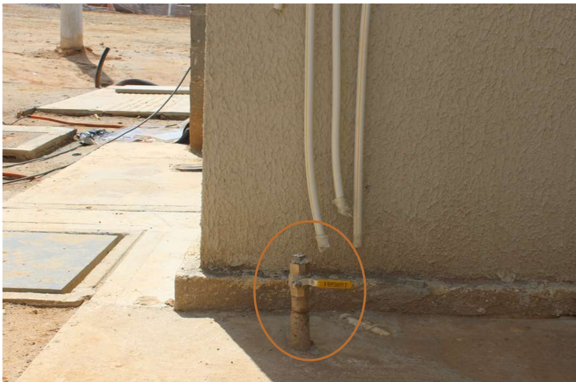
Foto 5: Medida ao alto e válvula de segurança.
