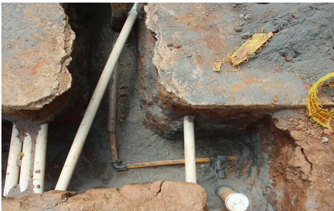
Foto 3: Derivação da rede aguardando a interligação.
