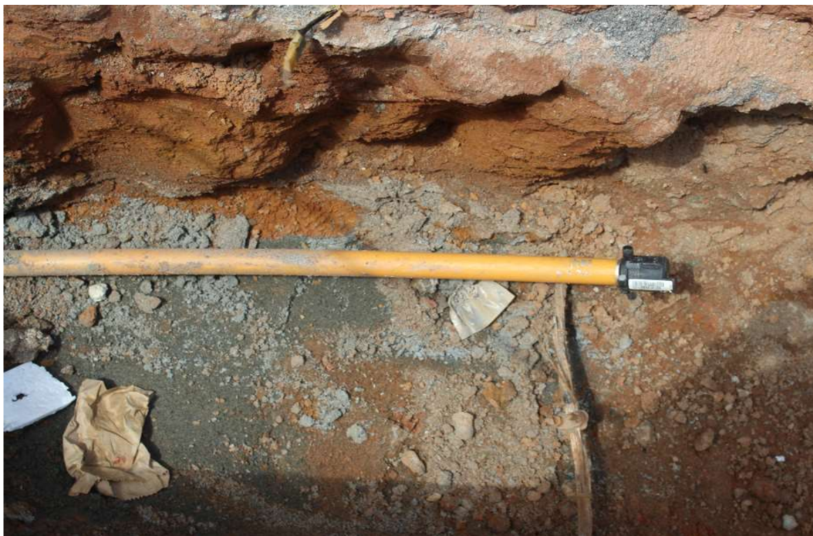
Foto 4: Ramal para alimentação dos Pls.
