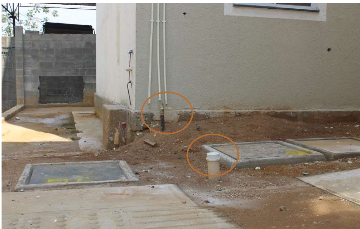
Foto 5: Medida ao alto e válvula de segurança.
