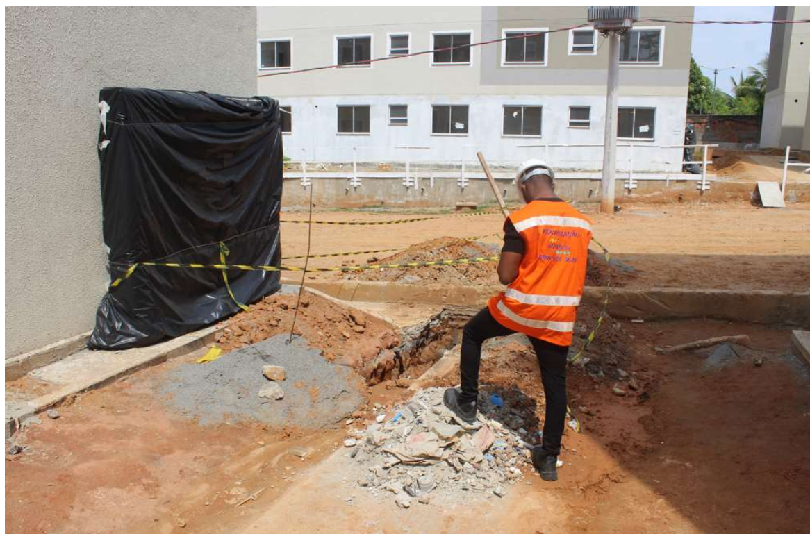
Foto 2: Equipe de vistoria da AGENERSA.
