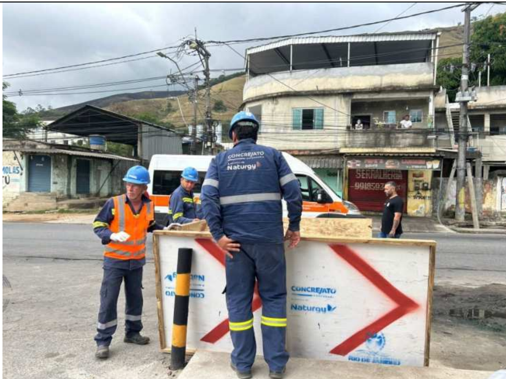
Foto 5: Funcionários da Concrejato demarcando com tapumes o local da perfuração.
