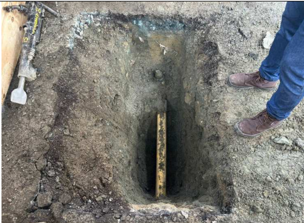
Foto 9: Trecho de tubulação de gás exposto para realização de vídeo inspeção.
