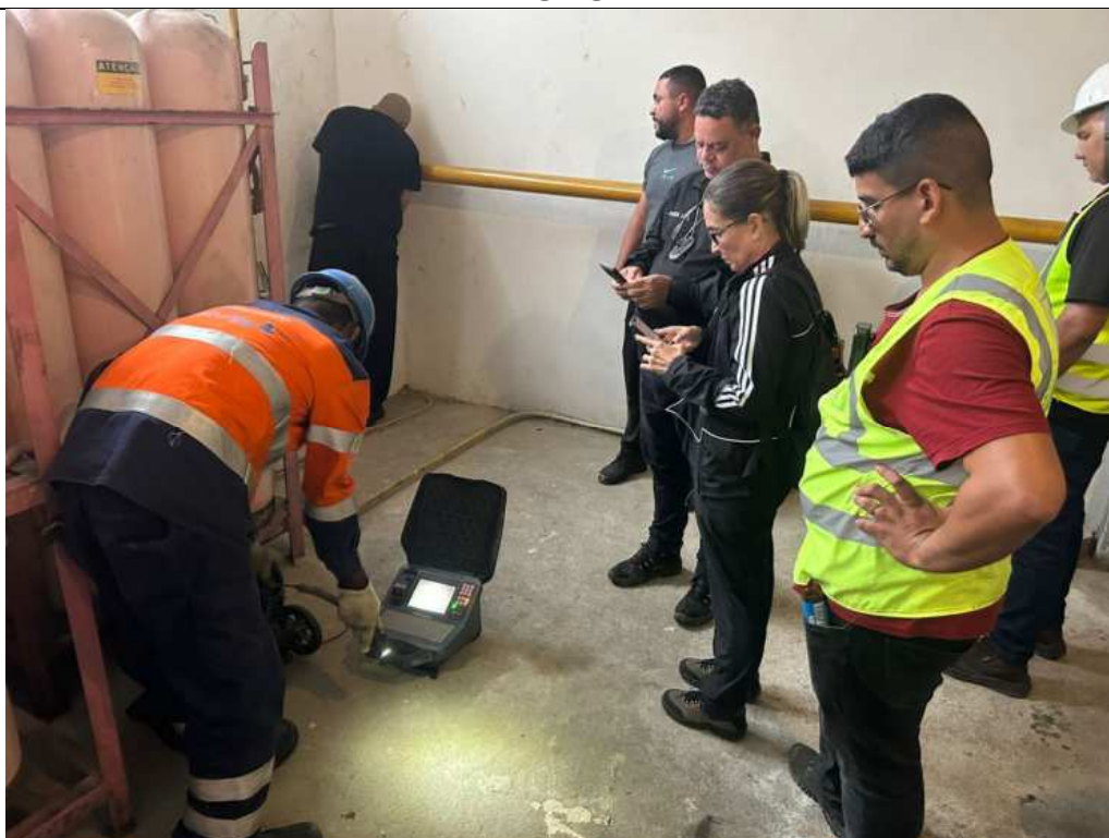
Foto 6: Funcionários observam imagem interna do tubo que conecta ERM ao compressor.
