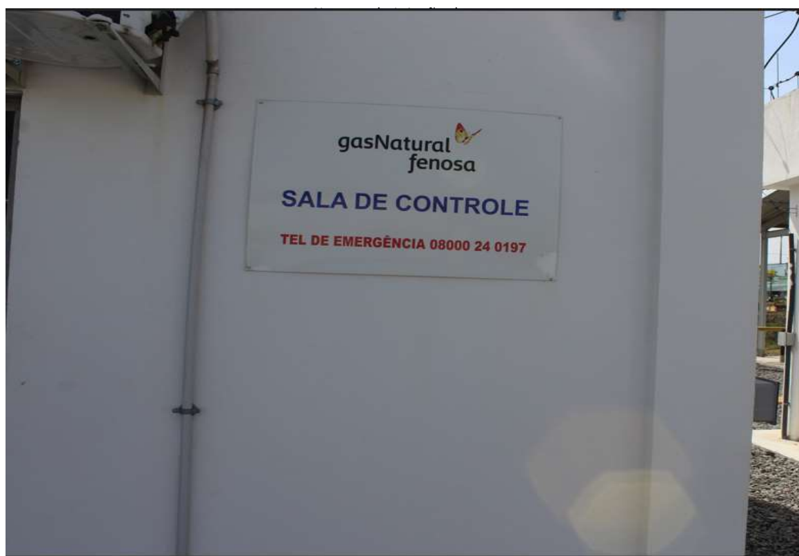
Foto 18: Sala de controle.
