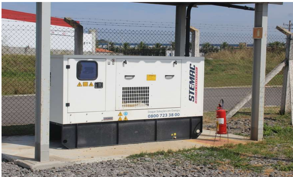
Foto 9: Gerador de energia elétrica atuante como Nobreak.
