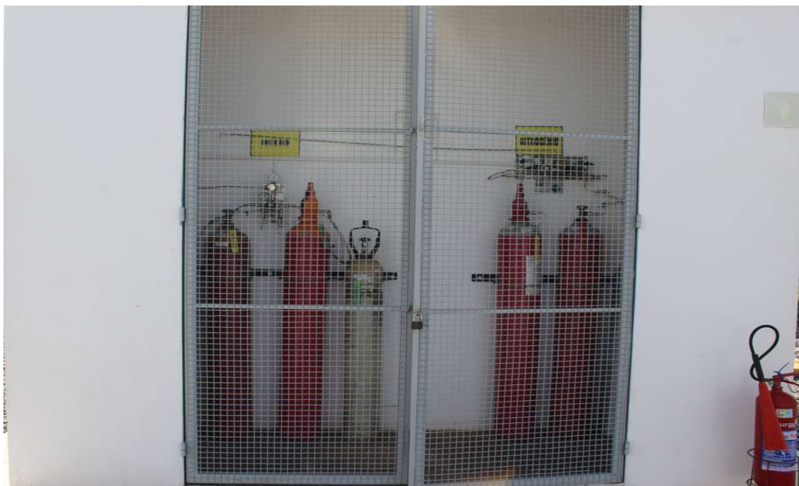
Foto 7: Local de armazenamento dos cilindros de gás Hélio e Nitrogênio.
