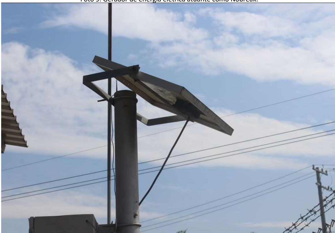
Foto 9: Gerador de energia elétrica atuante como Nobreak.
