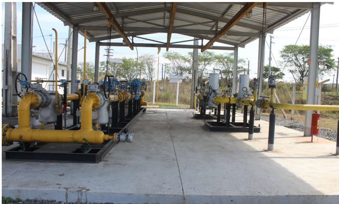
Foto 13: Estação de regulação e medição - ERM (à esquerda da foto) e Estação de regulação e distribuição - ERD (à direita da foto).
