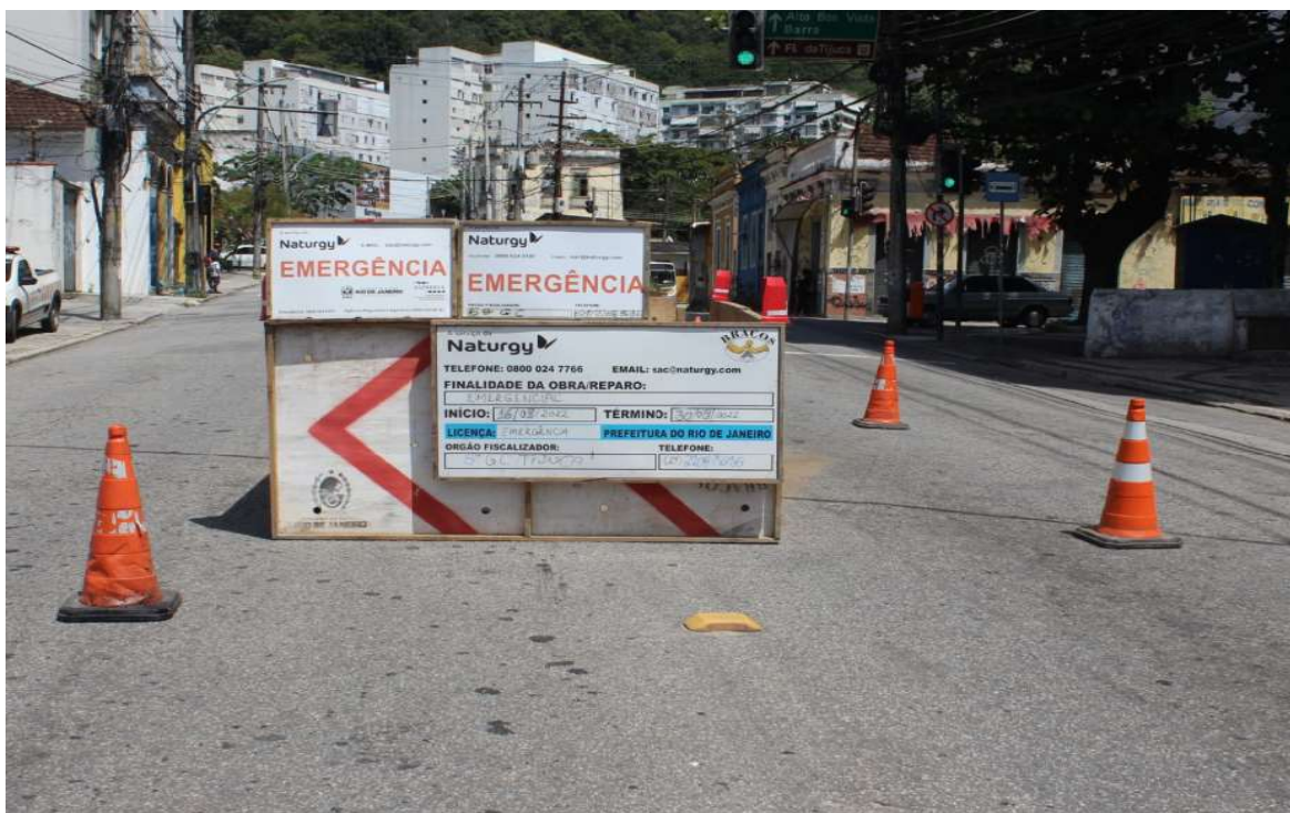
Foto 1: identificação da obra e sinalização
