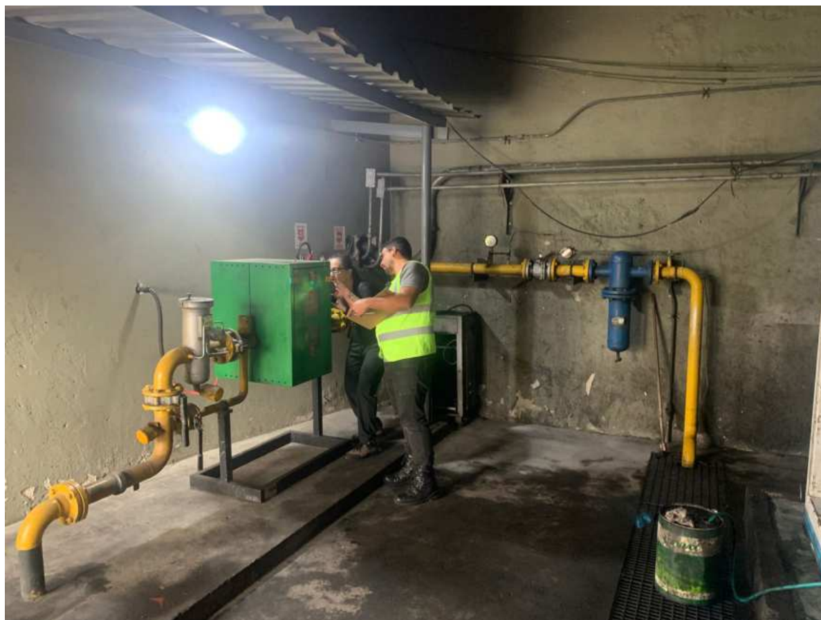
Foto 11: Funcionários durante inspeção do medidor.
