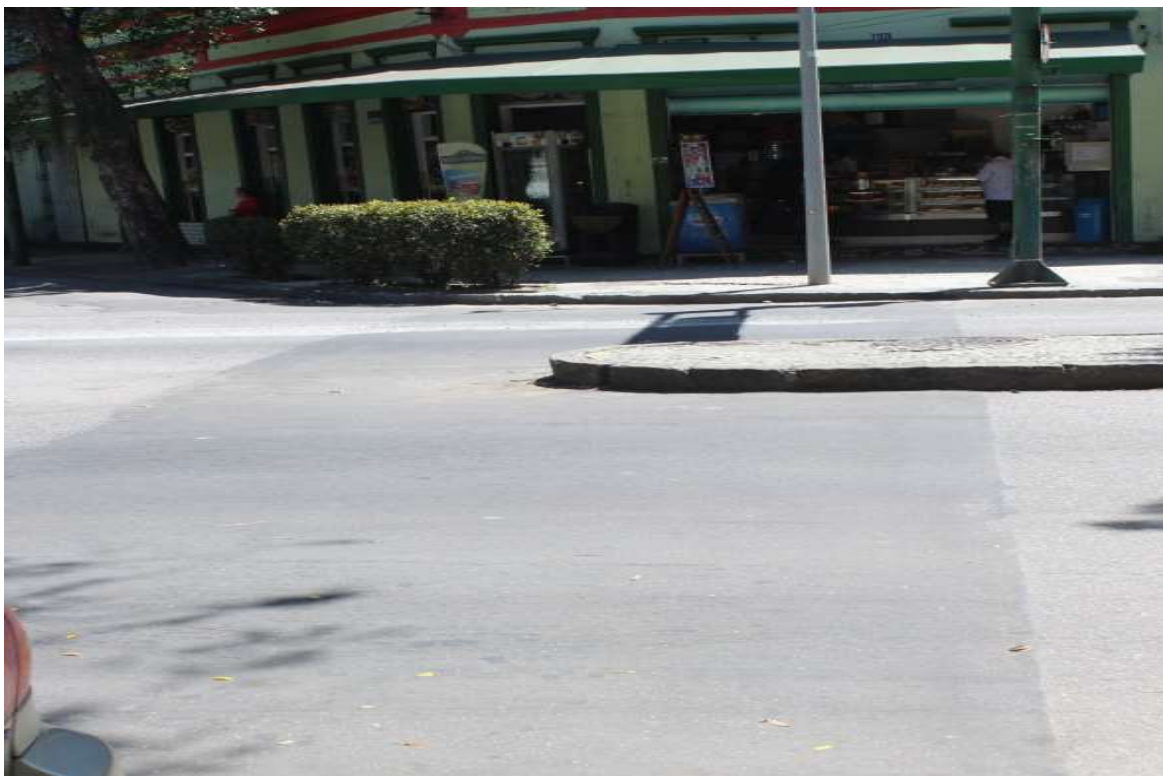
Foto 6: Recomposição da travessia
