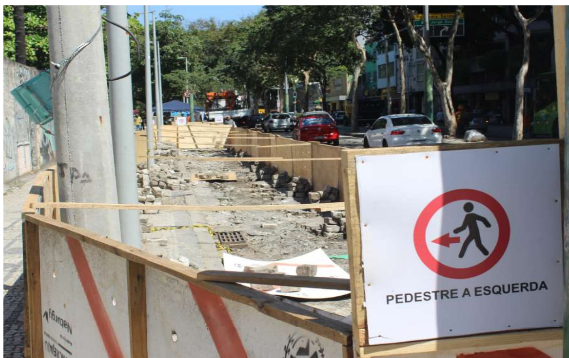
Foto 3: Reparo da recomposição do paralelo
