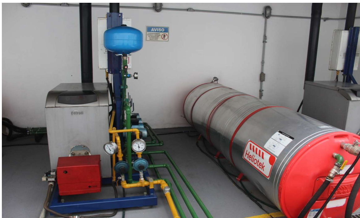
Foto 5: Sistema de aquecimento de água para os trocadores de calor.
