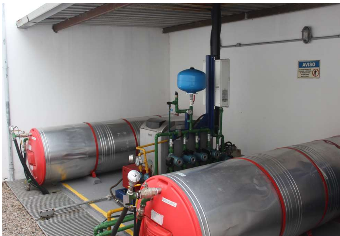
Foto 5: Sistema de aquecimento de água para os trocadores de calor.
