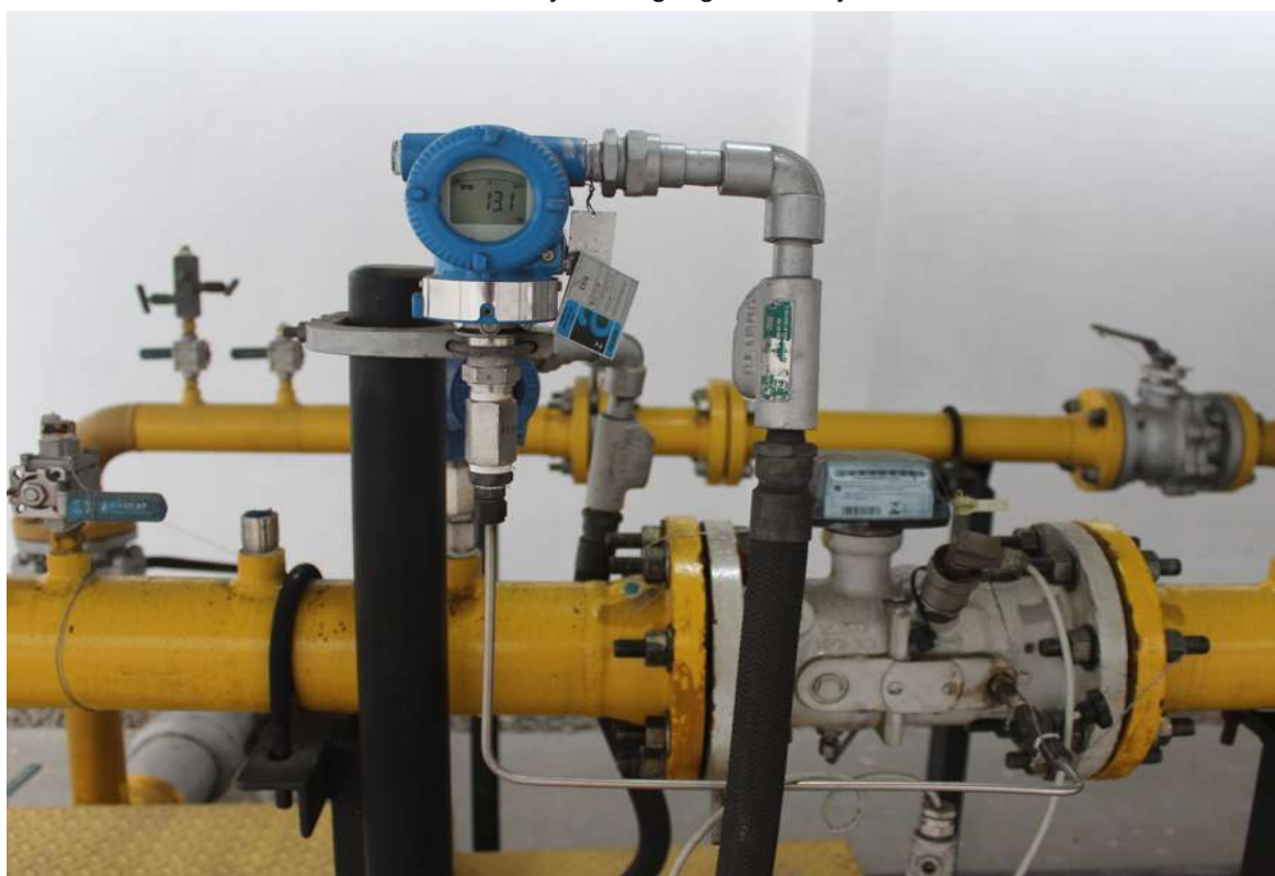
Foto 9: Estação de regulação e medição.
