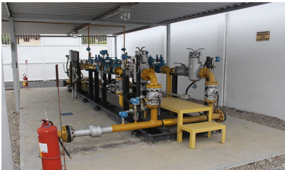
Foto 9: Estação de regulação e medição.
