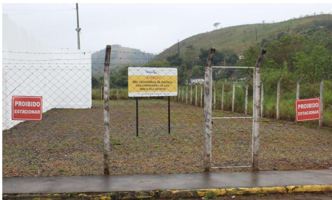
Foto 1: Placa de identificação da Estação
