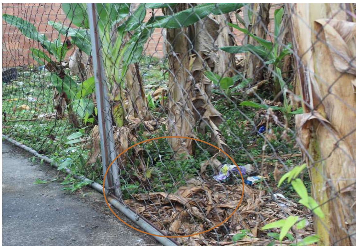
Foto 4: Reparo da abertura na cerca de vedação da estação (depois).
