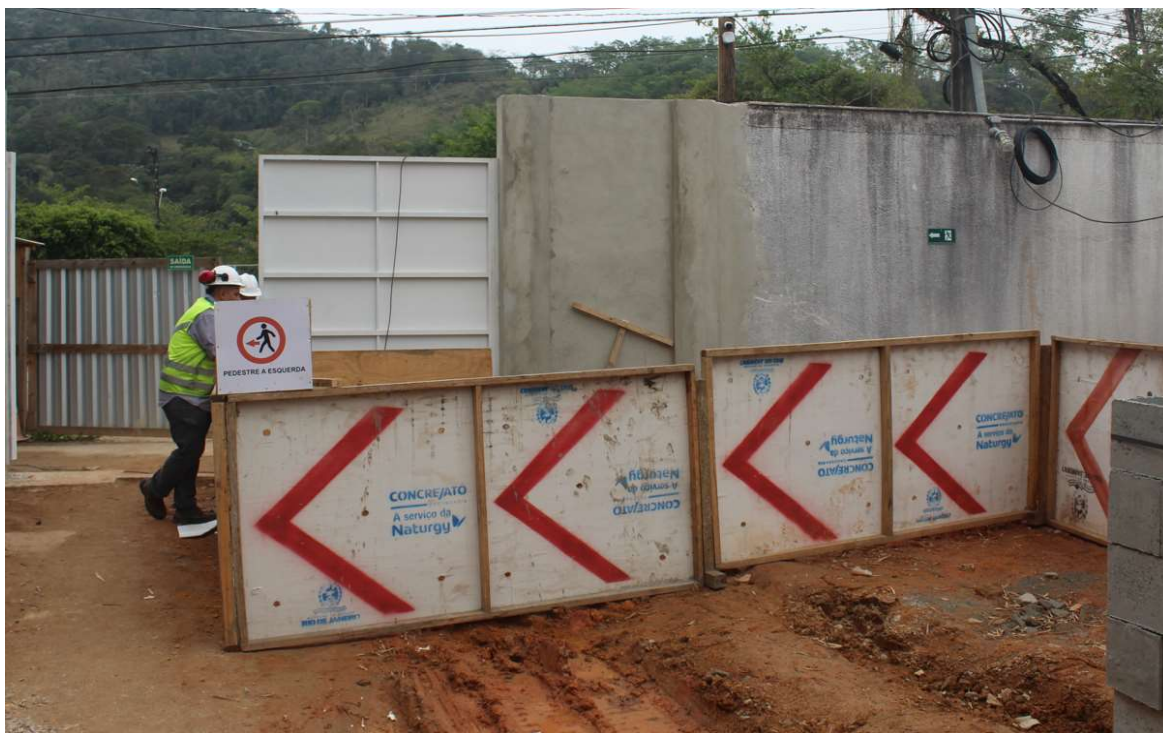
Foto 3: Sinalização de obra
