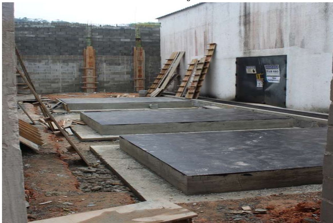
Foto 6: Bases construídas para os compressores futuros
